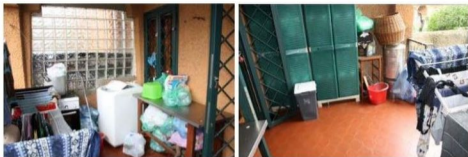
Foto 25 – Foto 26 - Veranda Portico Ovest
