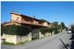
Foto 01 – Via dell'Orsa Minore – lato Est
