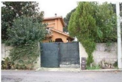
Foto 03 – Via dell'Orsa Minore, 95 – Ingresso Carrabile
