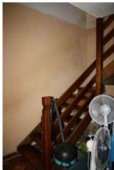
Foto 42 – Sbarco Scala da P.T. a Piano Interrato
