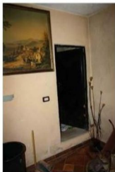
Foto 47 – Accesso al locale Ripostiglio
