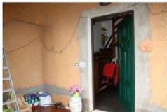
Foto 12 – Porta di Ingresso
