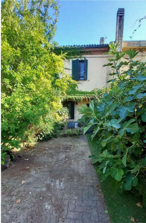
Foto 3 – Vista dell'ingresso sul fronte dal cortile
