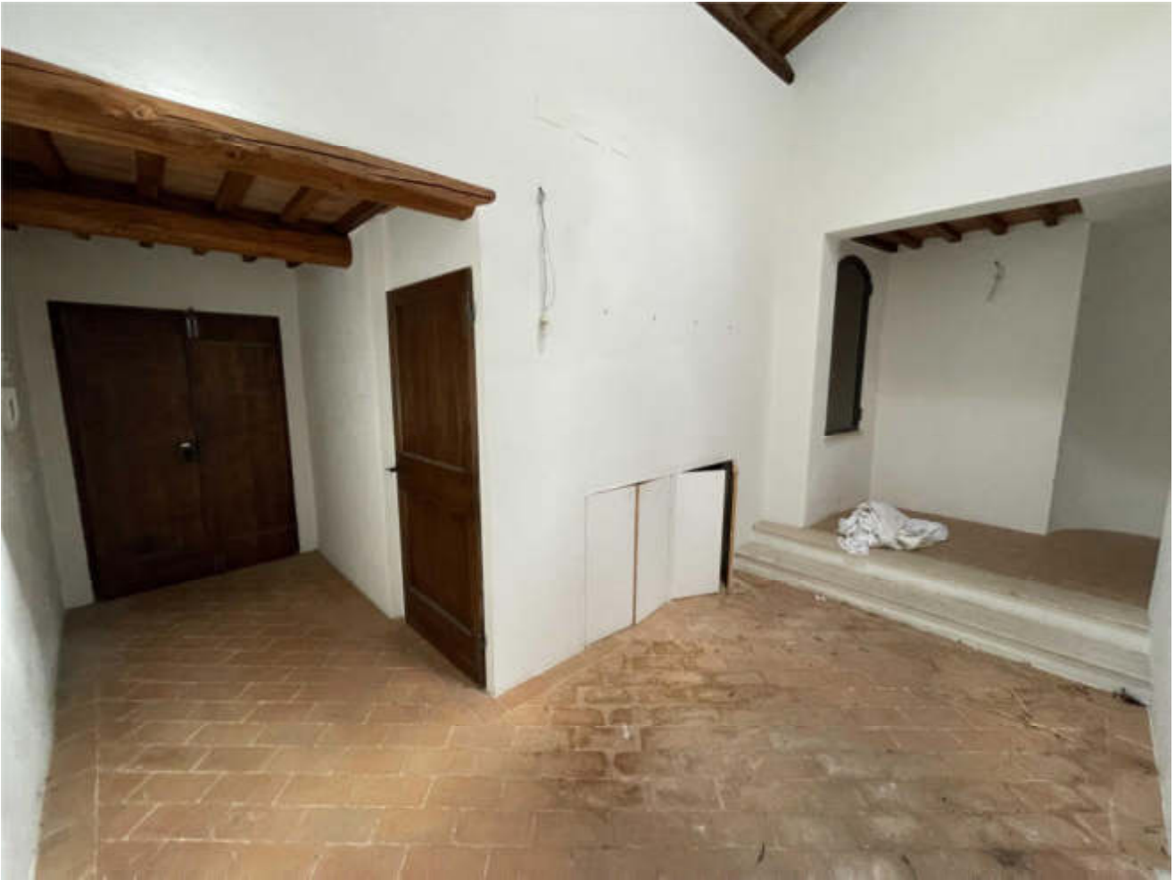
Vista dell'ingresso e del disimpegno
