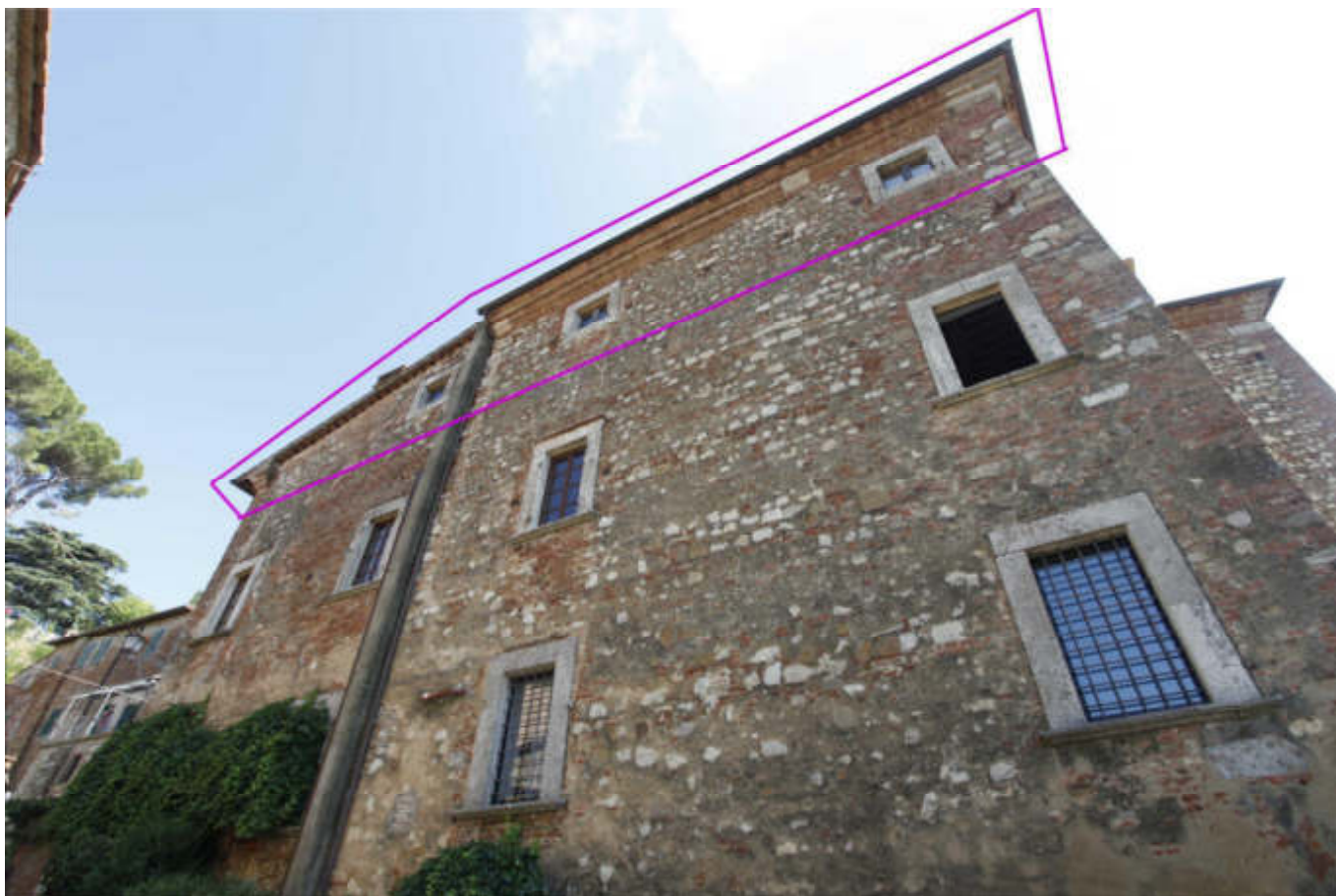
Vista della parte alta della facciata sud
