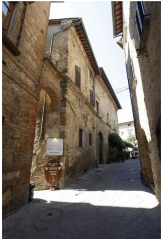
Vista della facciata principale
