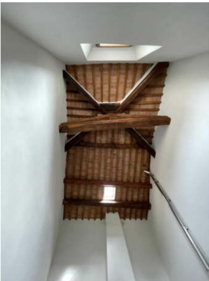
Il solaio della cucina
