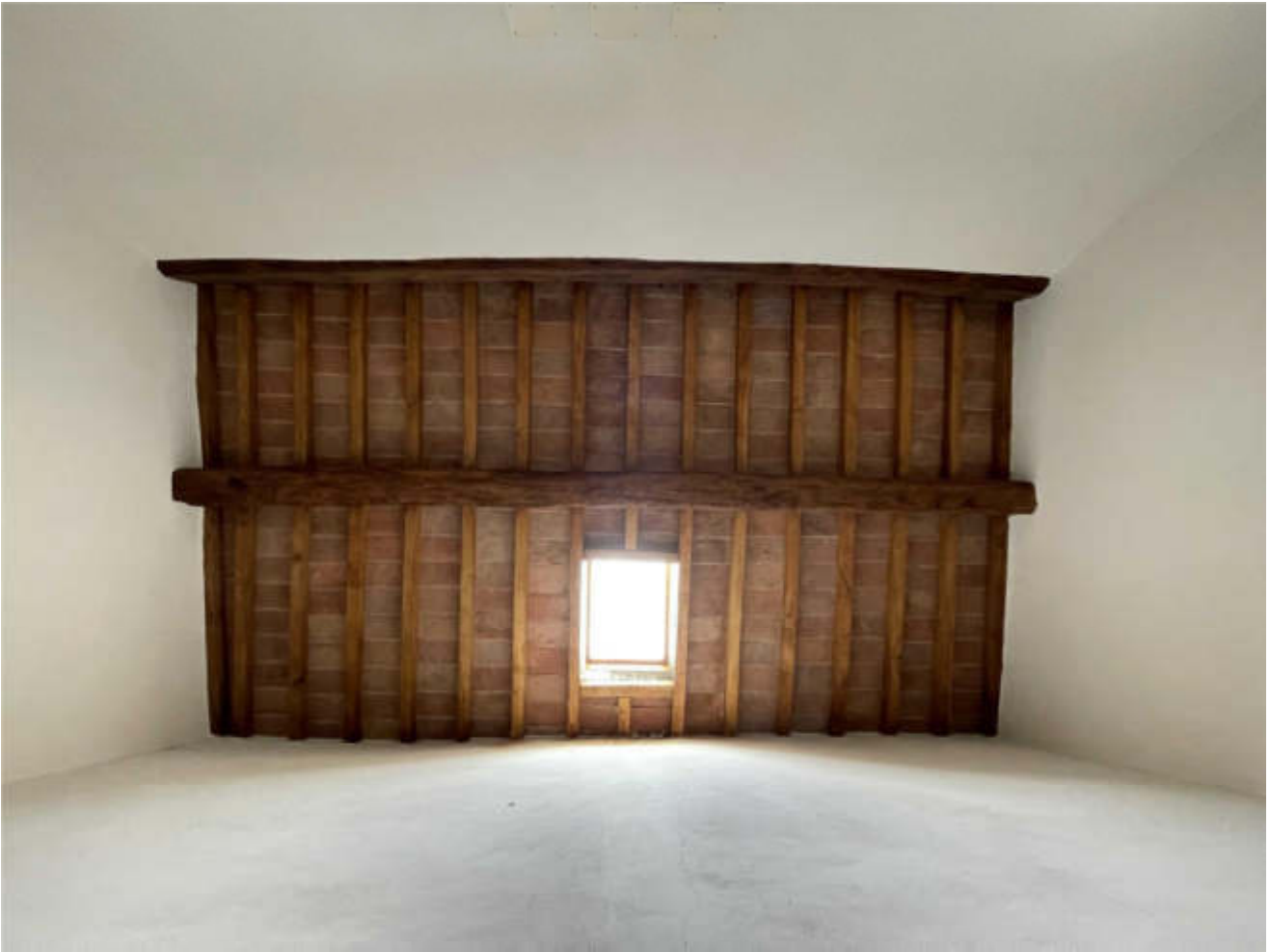
Vista del solaio del disimpegno
