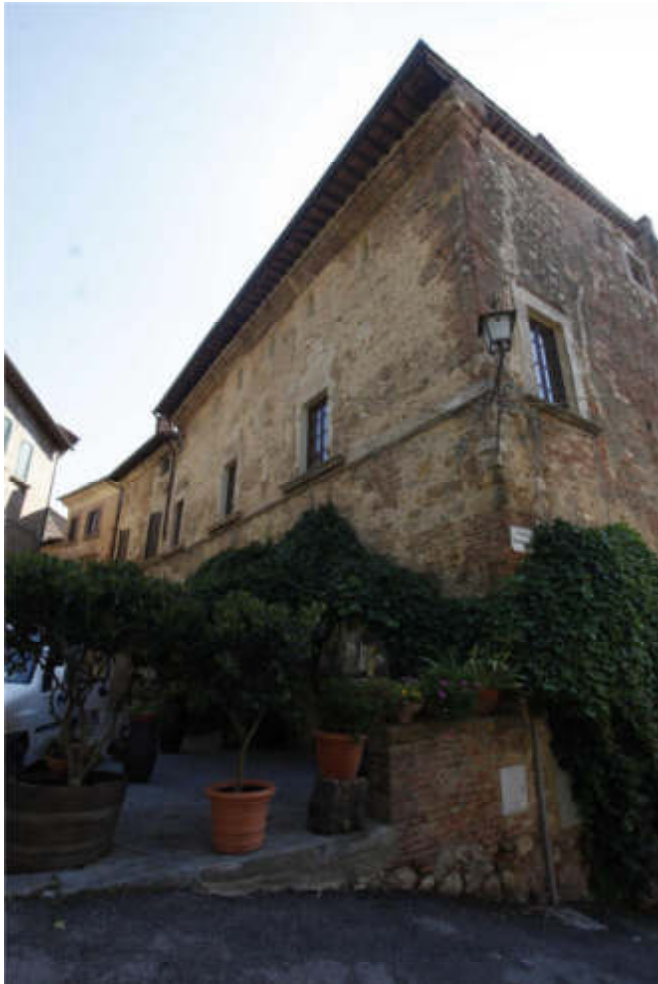
Vista della facciata principale
