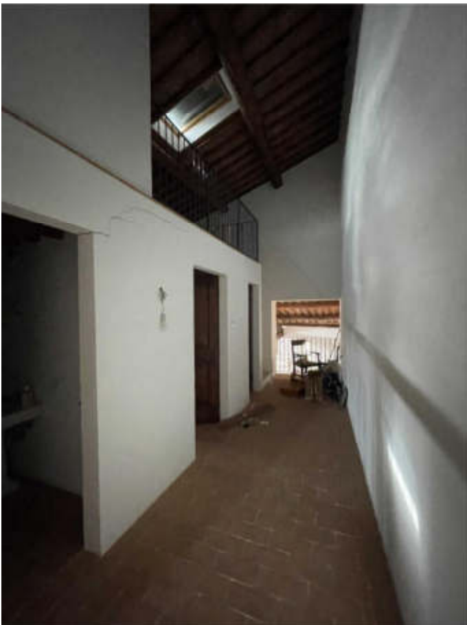
Vista del disimpegno e del soppalco
