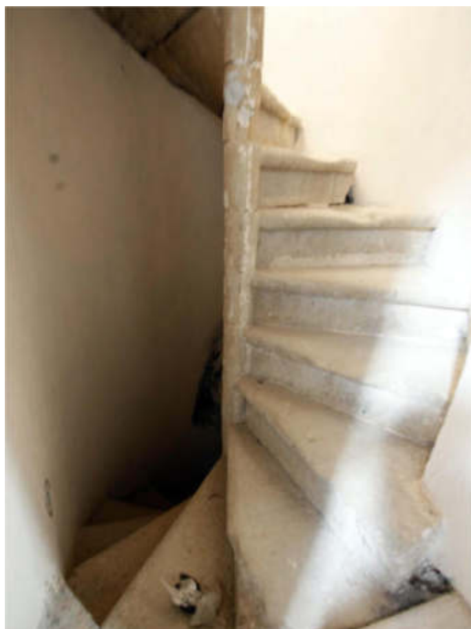
Vista della scala elicoidale condominiale
