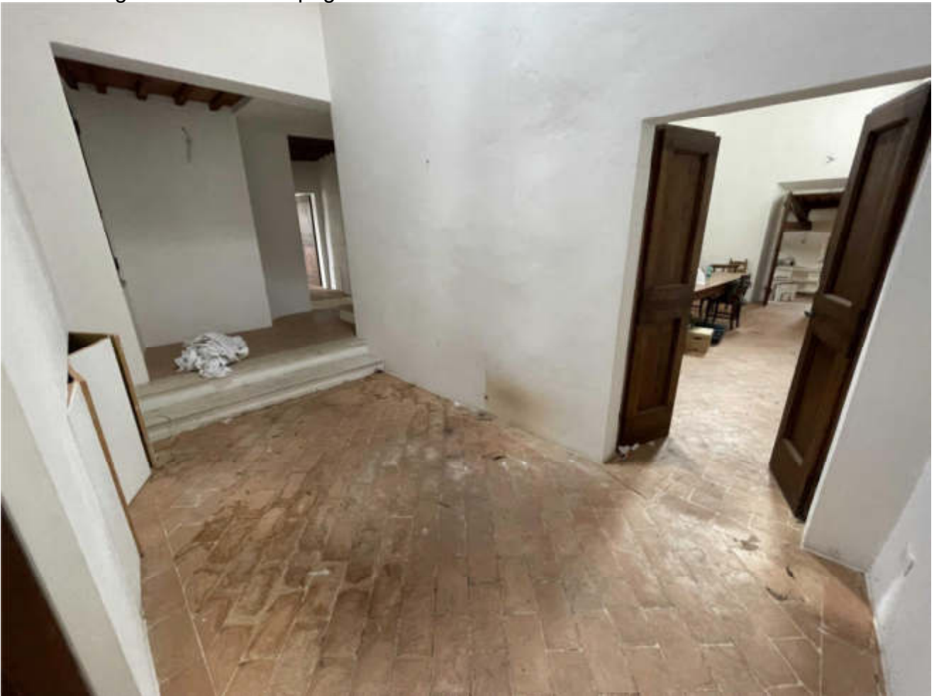
Vista del disimpegno con l'accesso alla cucina
