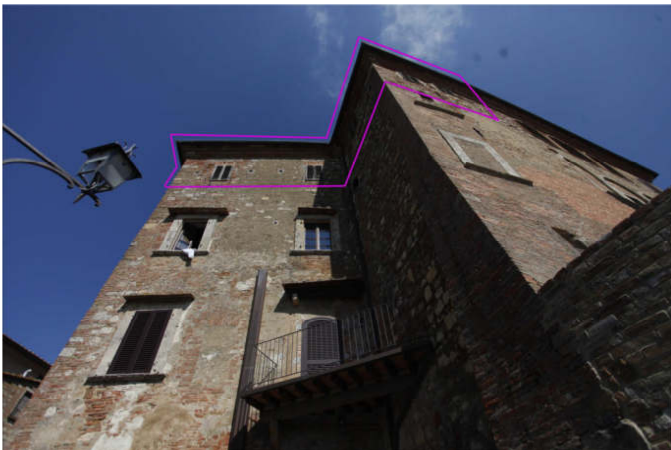
Vista della parte alta della facciata est
