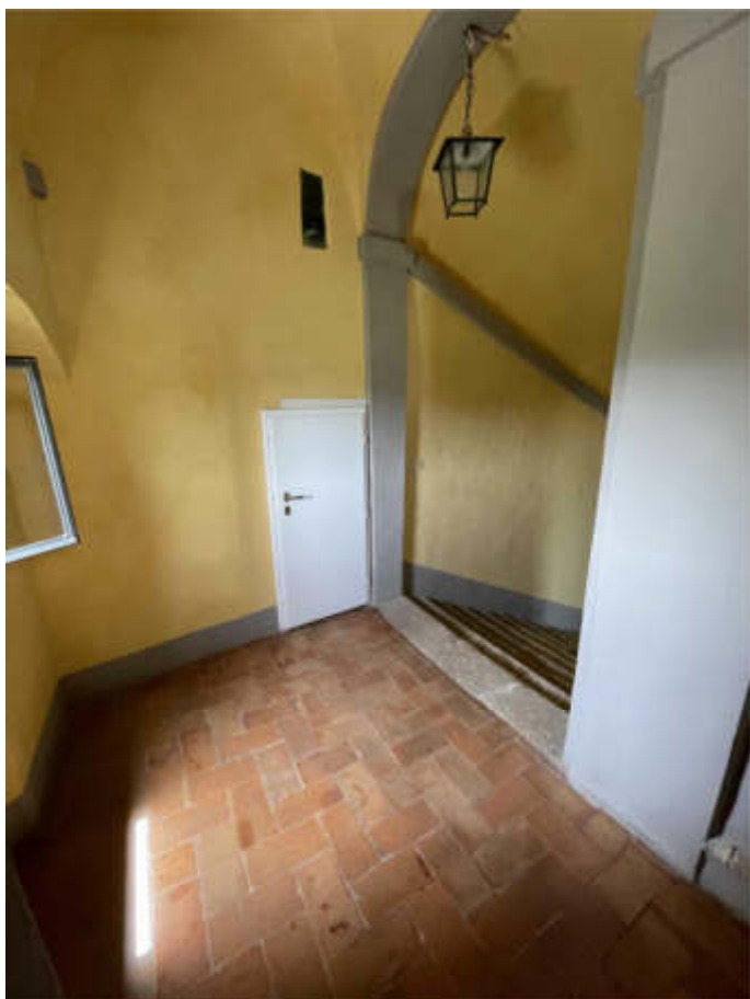
Vista della scala condominiale
