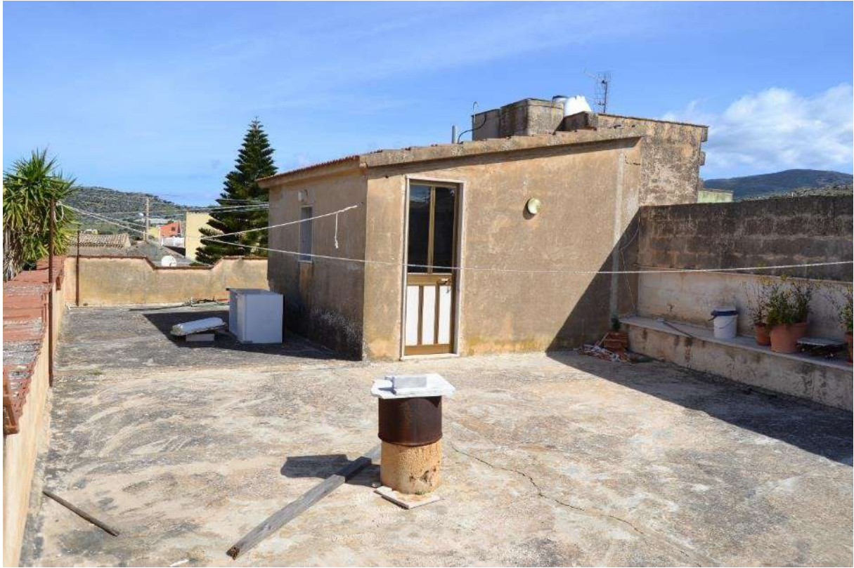
Foto 53) BENE 8 – Lavanderia e lastrici solari
