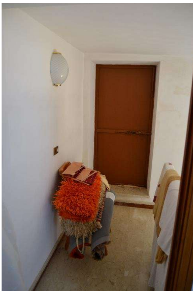
Foto 36) BENE 5 – Vista ballatoio piano secondo e portoncino di accesso ai lastrici solari lato via Piano Alastre
