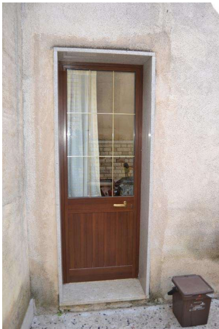
Foto 57) BENI 1 E 22 – Porta di accesso laterale
