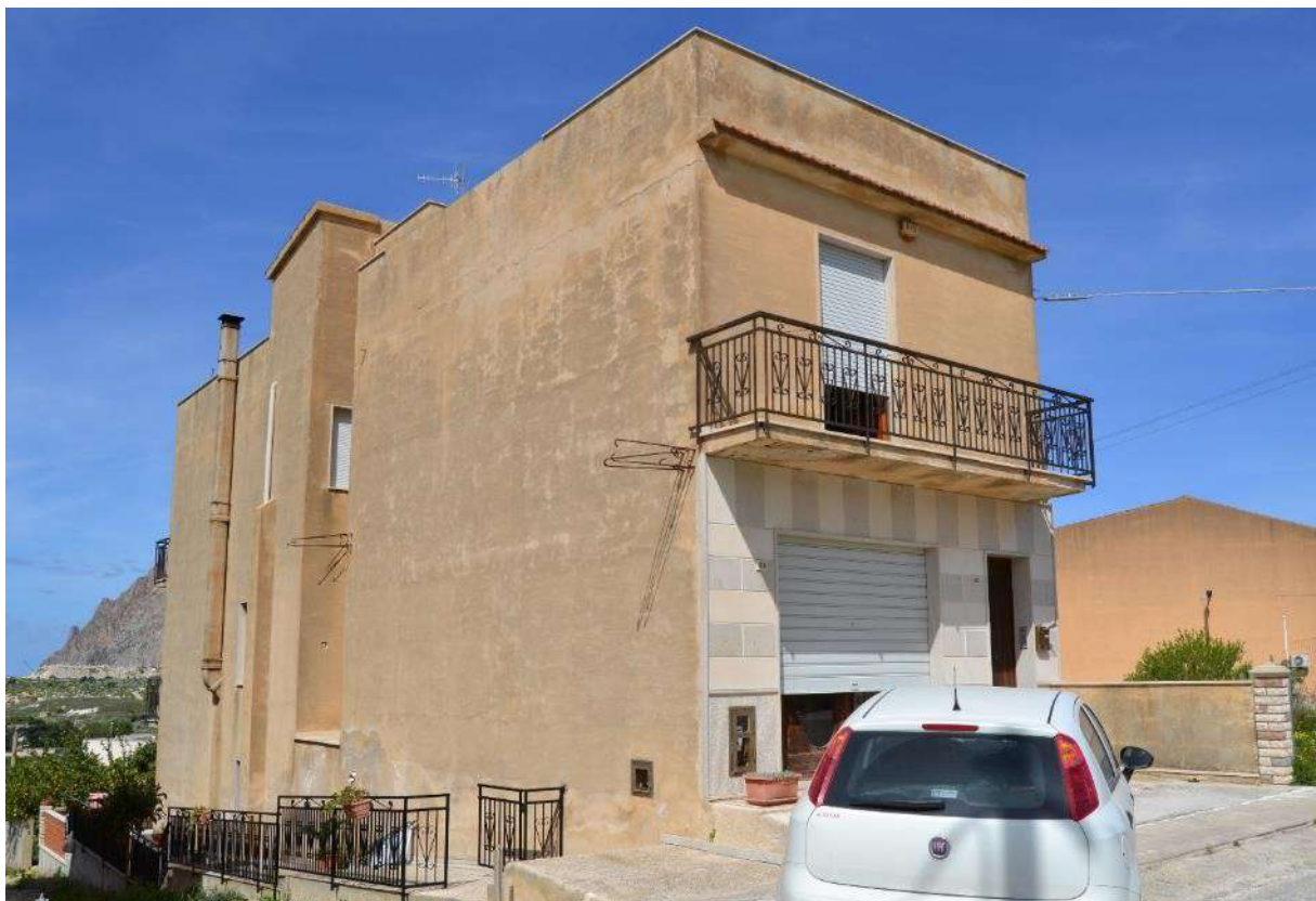
Foto 18) BENE 5 – Facciate lato sud e ovest e camminamenti per l'accesso al piano seminterrato
