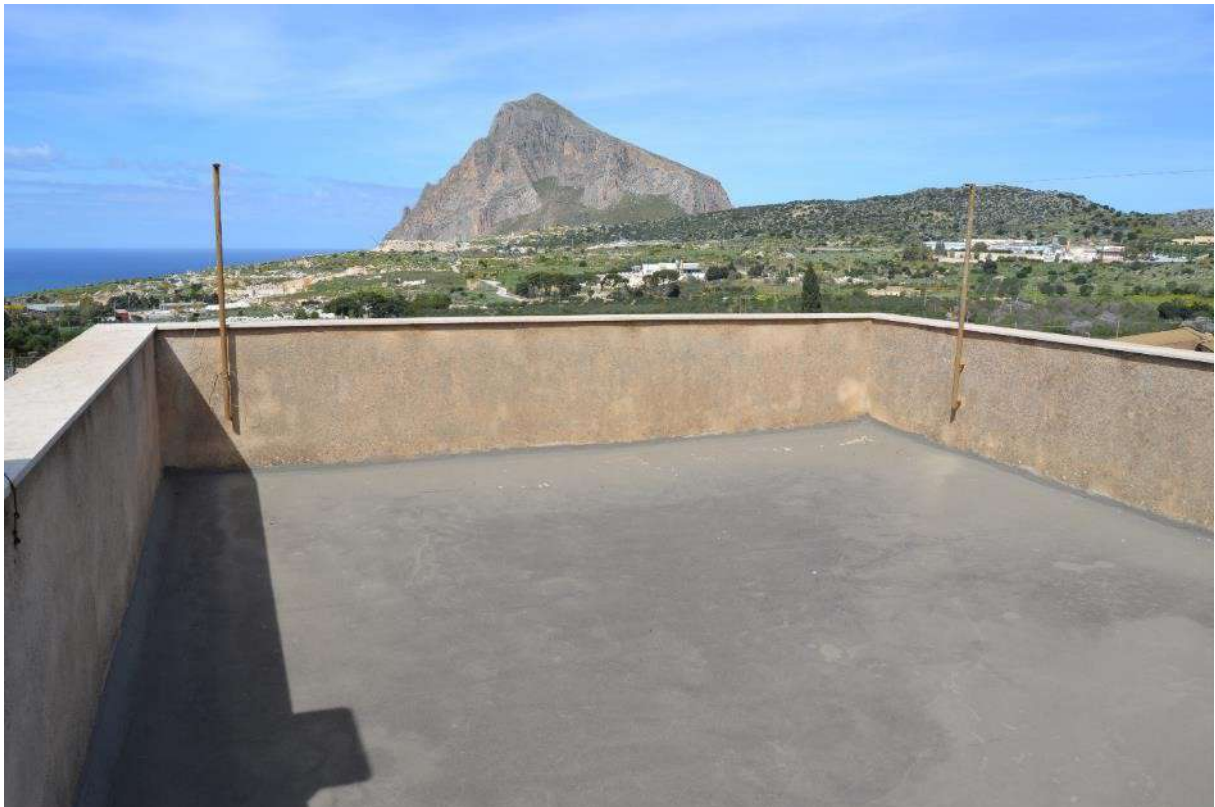
Foto 38) BENE 5 – Lastrico solare lato nord
