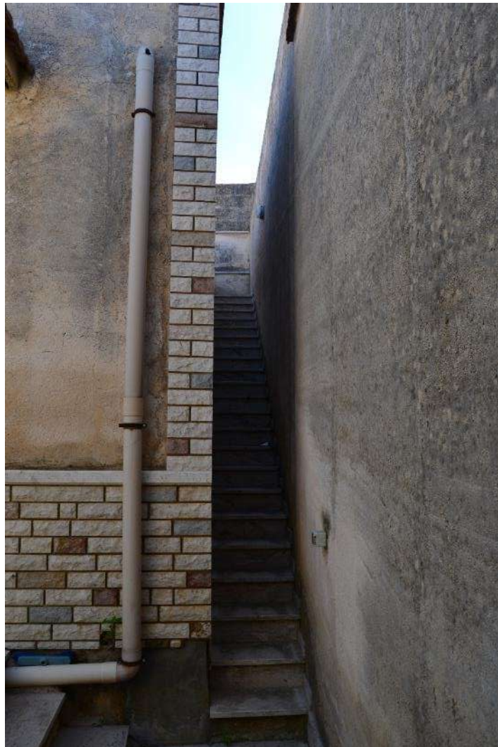
Foto 52) BENE 8 – Scala di accesso ai lastrici solari
