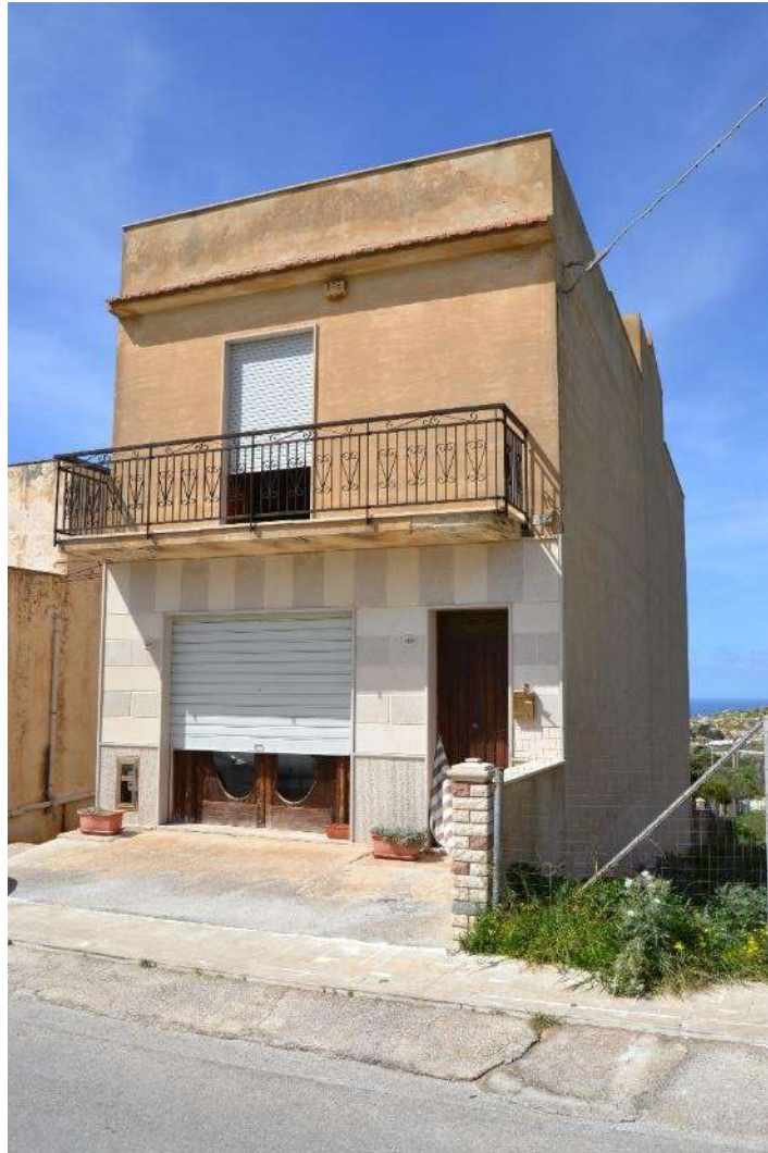
Foto 17) BENE 5 – Vista facciata su Via Piano Alastre e accesso dal civico 35
