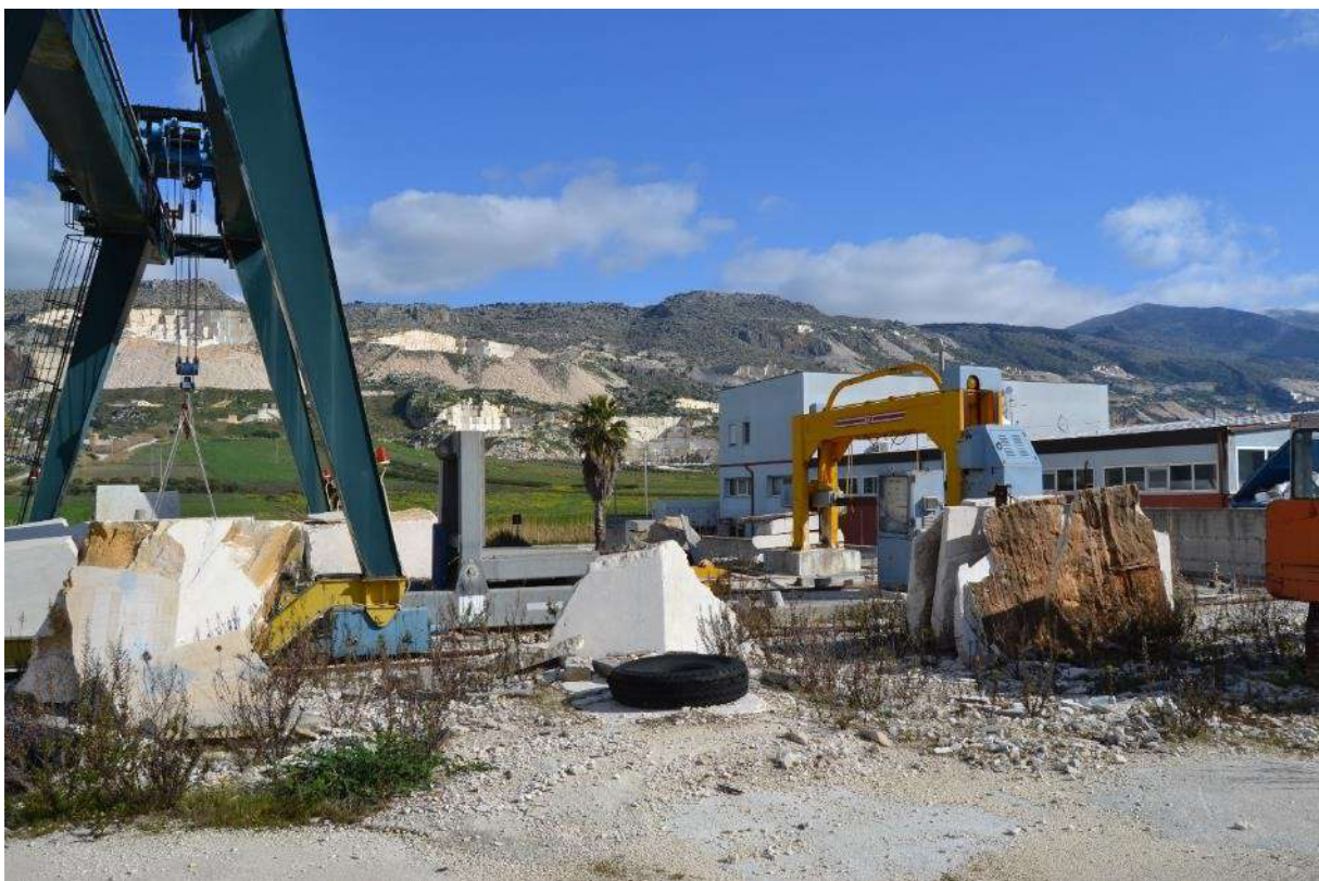
Foto 4) BENI 1 E 2 – Vista macchinari installati nel lotto
