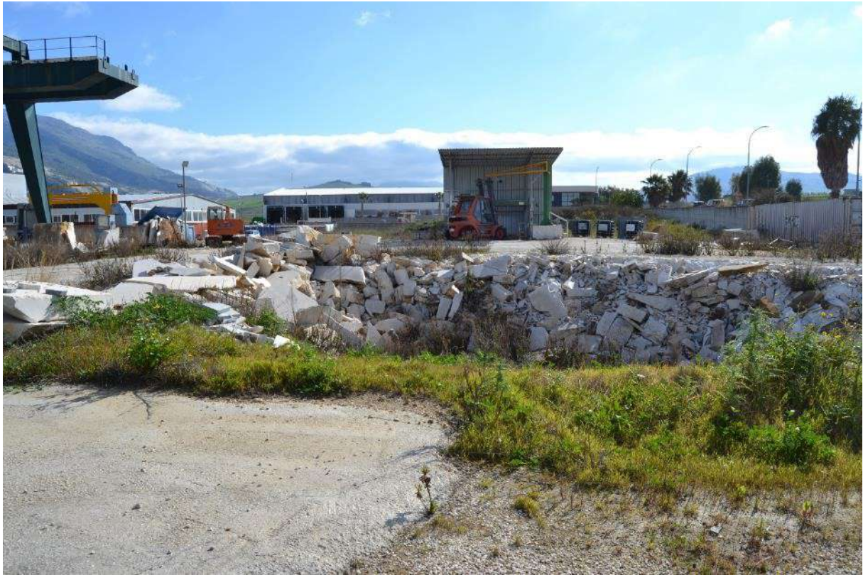
Foto 7) BENI 1 E 2 – Scavo e pezzame di marmo
