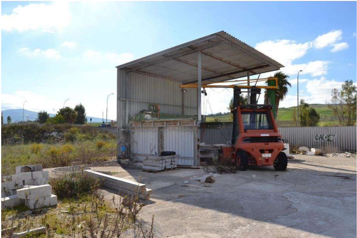
Foto 5) BENI 1 E 2 – Tettoia in acciaio
