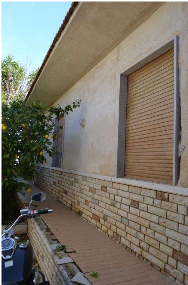
Foto 43) BENE 6 – Facciata lato ovest e camminamenti
