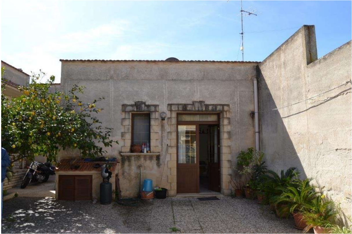
Foto 55) BENE 7 – Ingresso magazzino dalla corte interna
