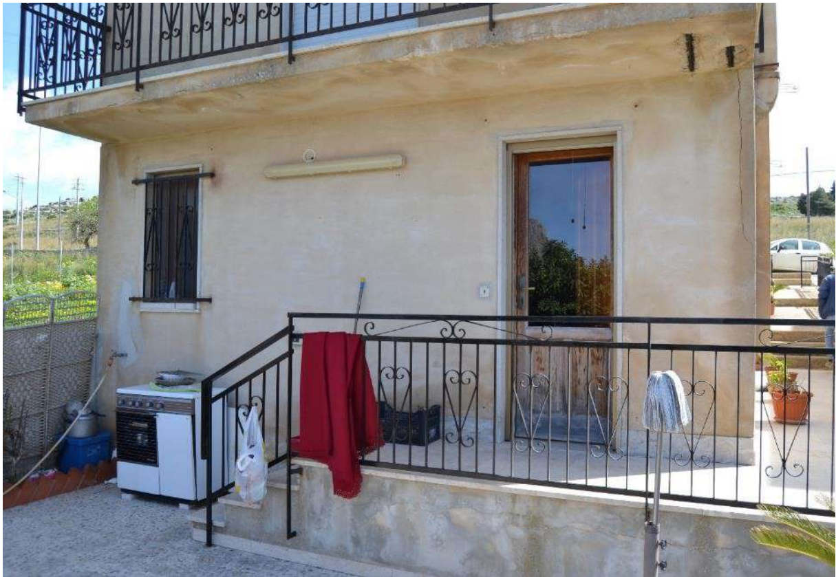
Foto 19) BENE 5 – Facciata lato nord (piano seminterrato)
