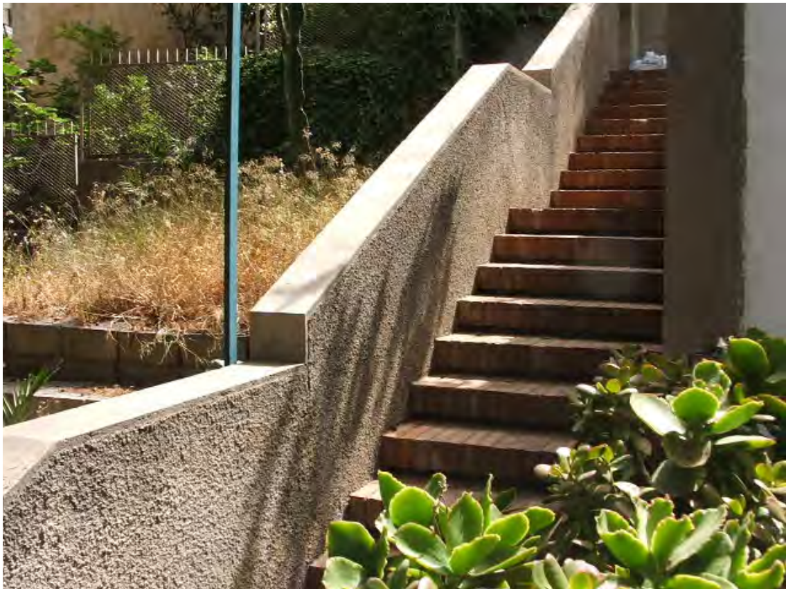
Scalinata verso il piano terra unità collabenti
