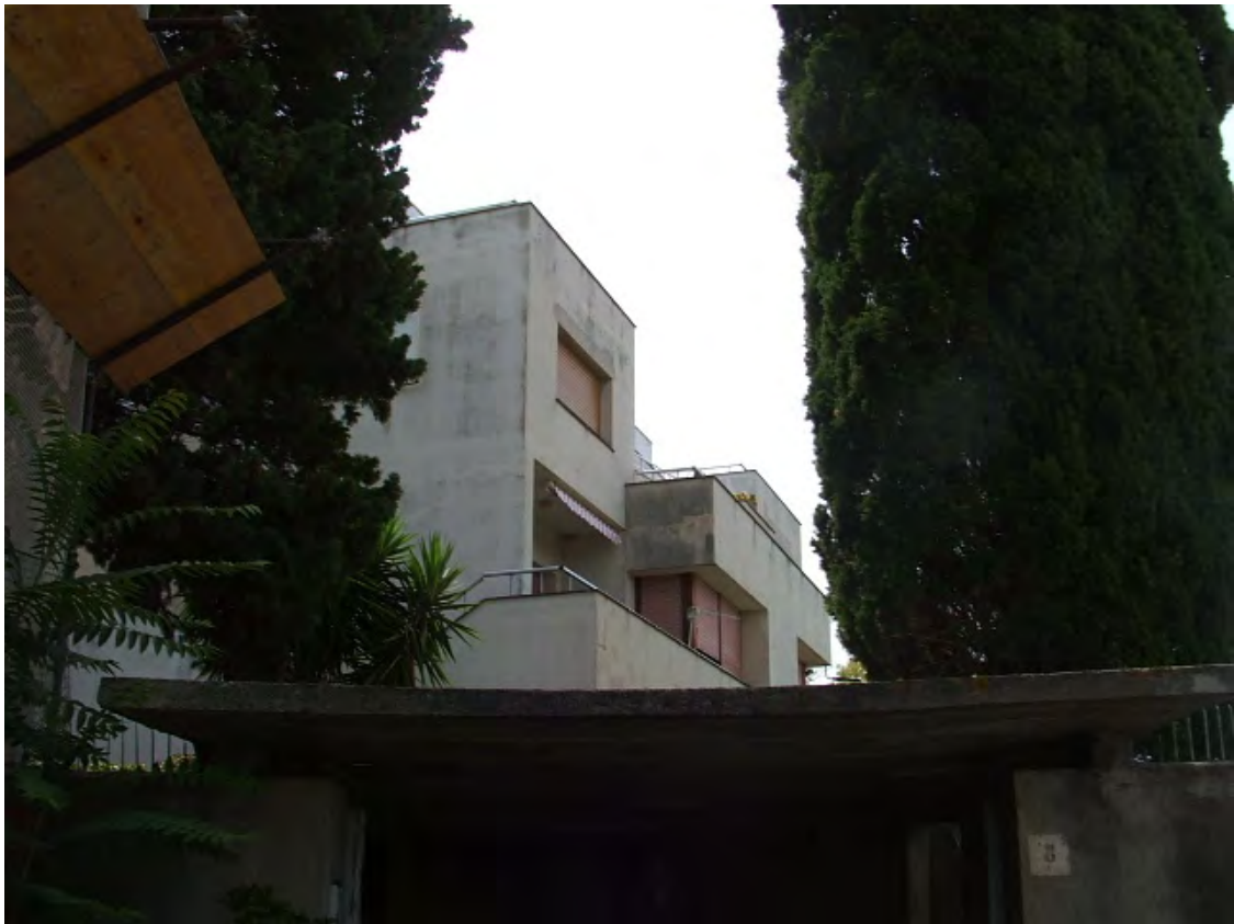
Vista dalla strada di accesso.
