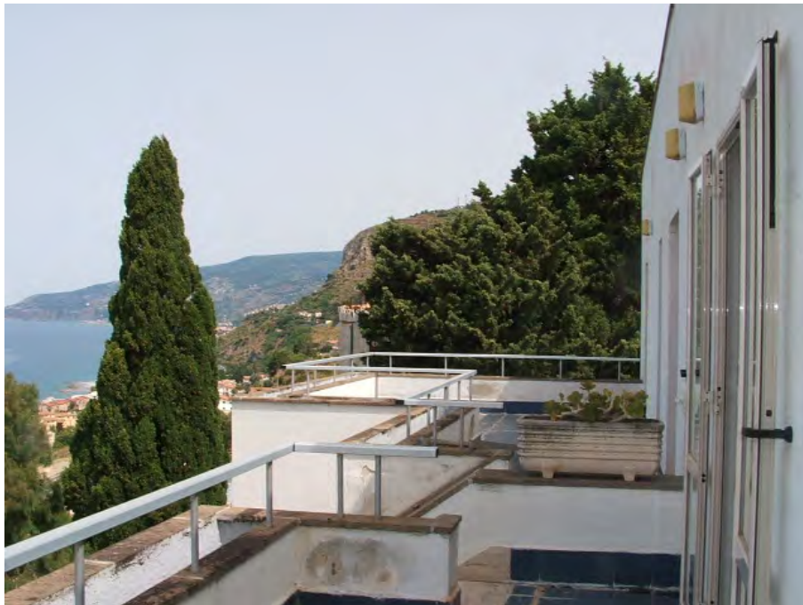
Vista verso nord-ovest
