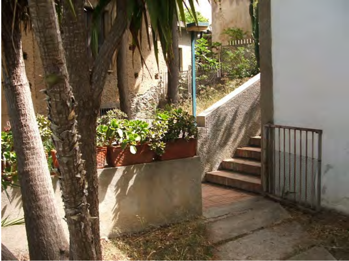
Scalinata verso il piano terra unità collabenti
