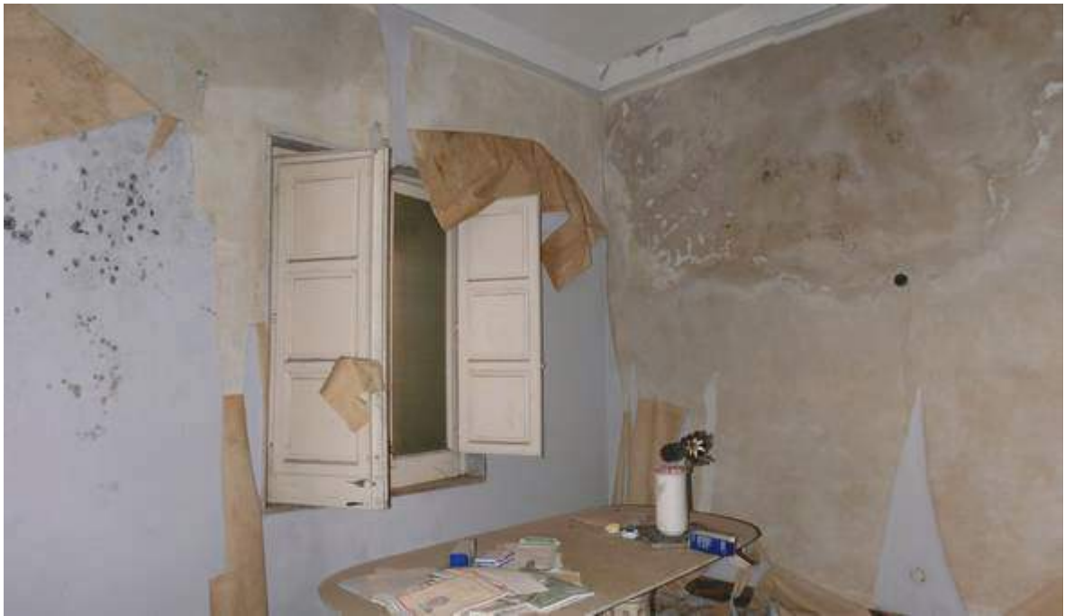
VISTA DI INTERNO A PRIMO PIANO
