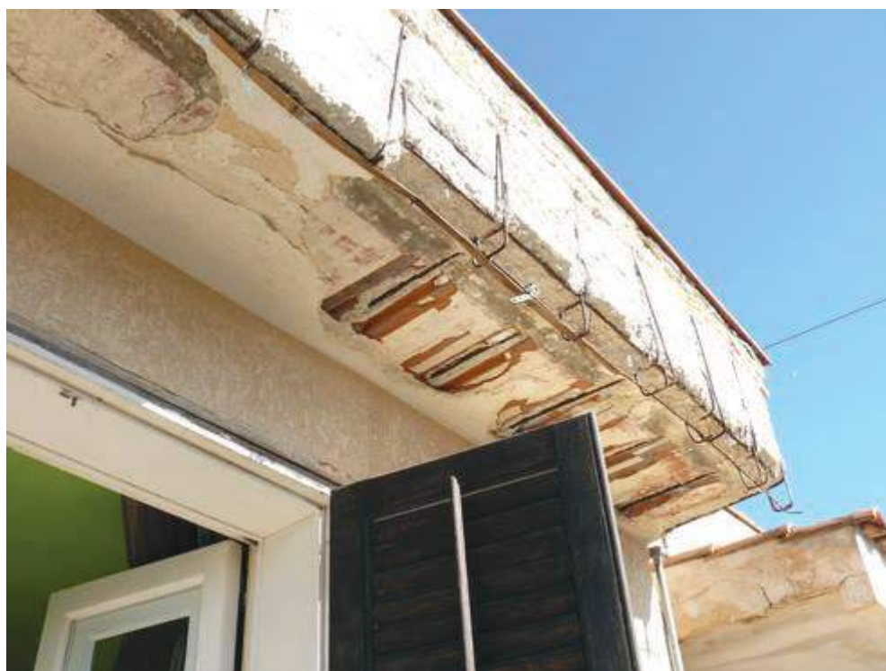
VISTA DEL CORNICIONE DI COPERTURA
