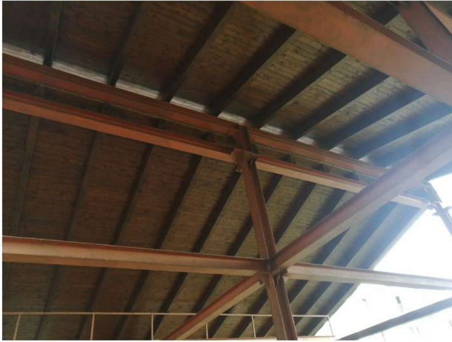
Copertura in legno a falde inclinate
