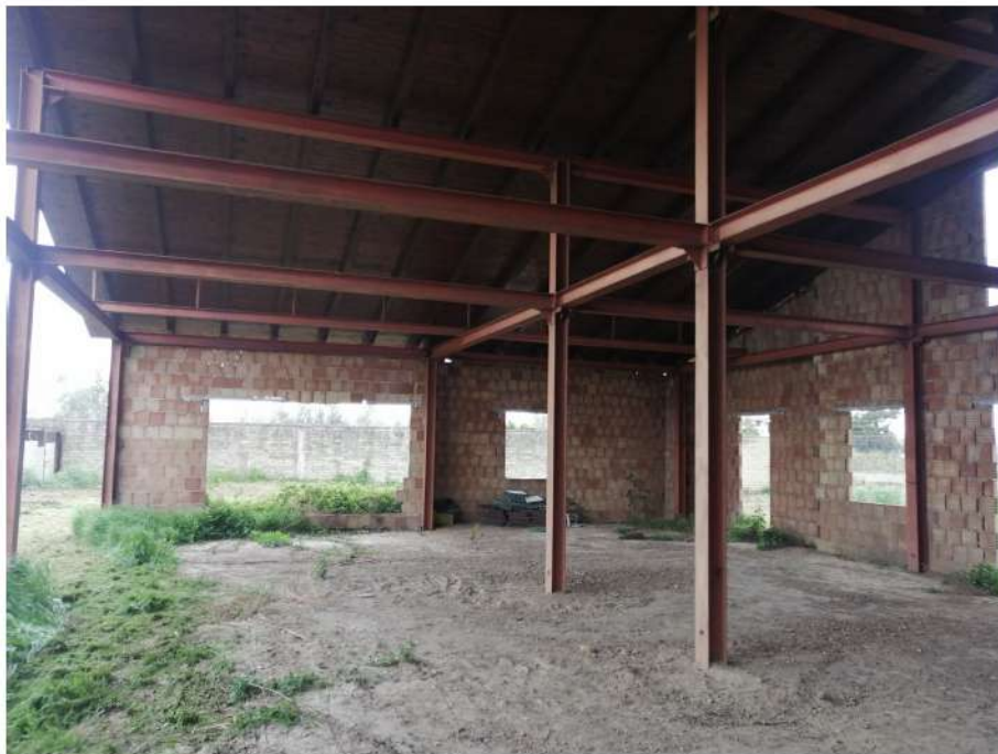
Struttura portante in carpenteria metallica
