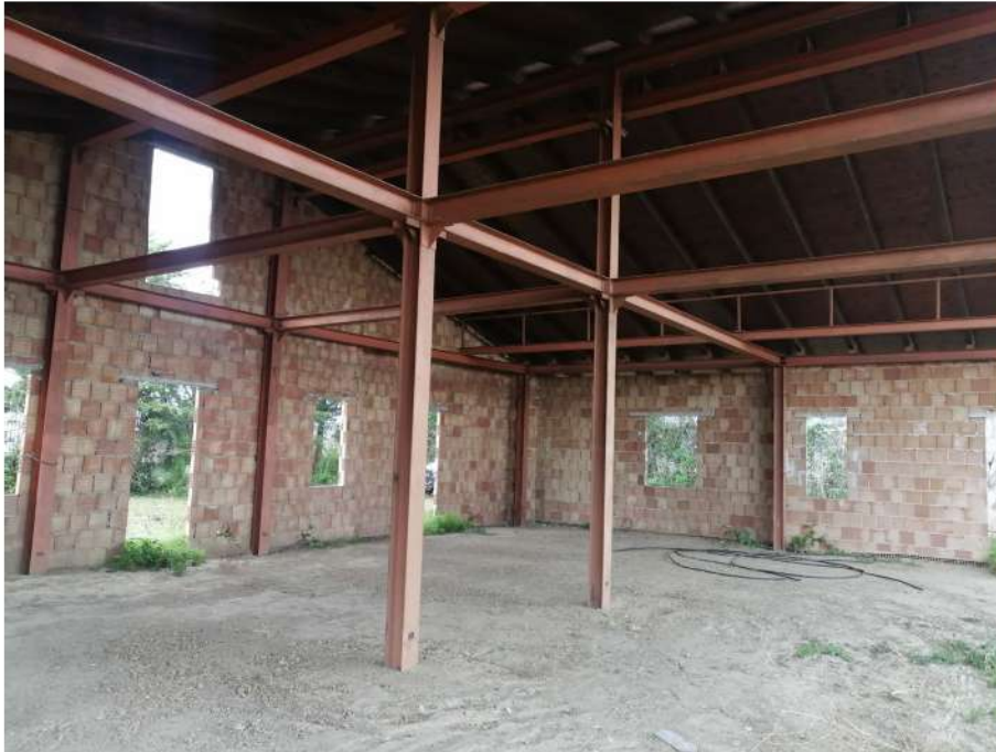
Struttura portante in carpenteria metallica
