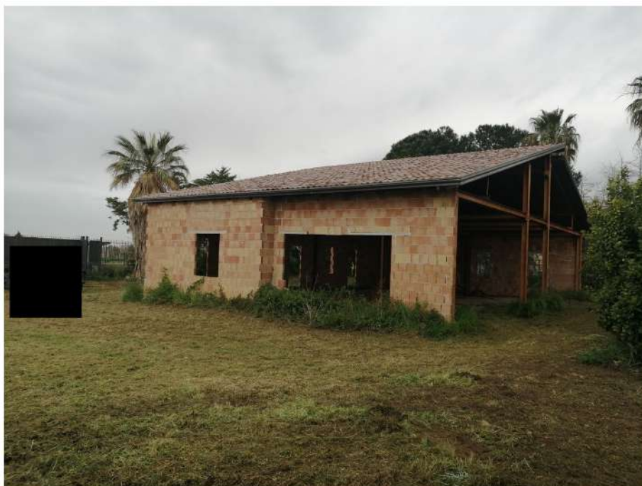
Manufatto edilizio fronte est-sud
