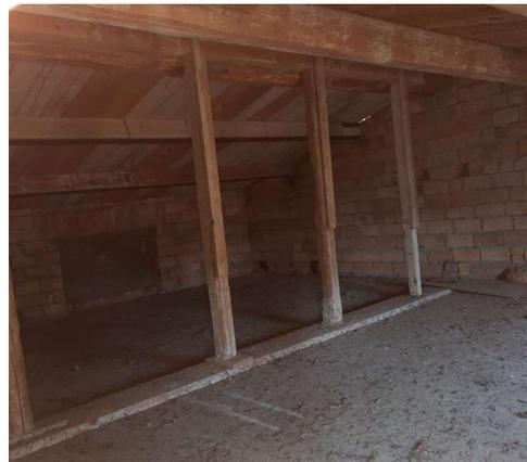
La struttura portante della copertura è in legno con locali piccoli cedimenti, con tavolato a sostegno di manto di tegole. Tutto l'interno è allo stato grezzo ed assolutamente privo di qualsiasi forma di impianto.
