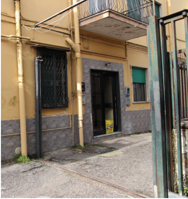
Foto 2 - Portone di ingresso edificio
