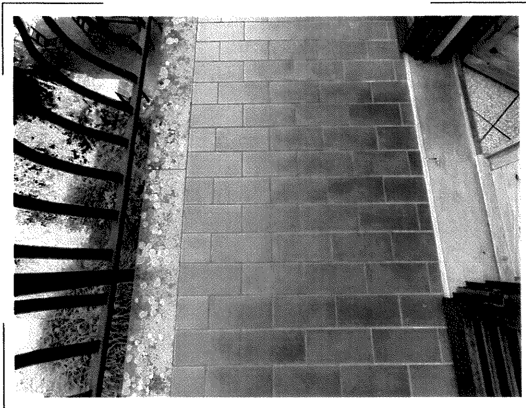
38) CF Fg. 4 p.lia 160 sub. 2 – Particolare della pavimentazione dei terrazzi ad uso esclusivo della porzione di abitazione oggetto di stima (████████████████████)
