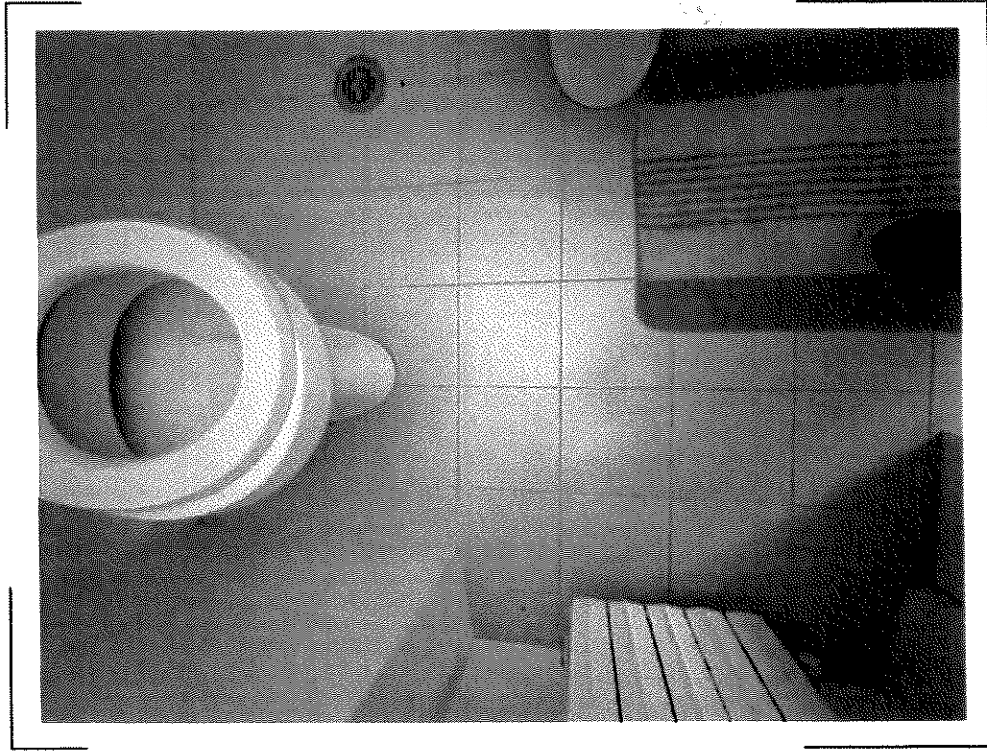
24) CF Fig.4 p.IIa 160 sub.2 – Particolare della pavimentazione dei w.c. al piano terra/rialzato
