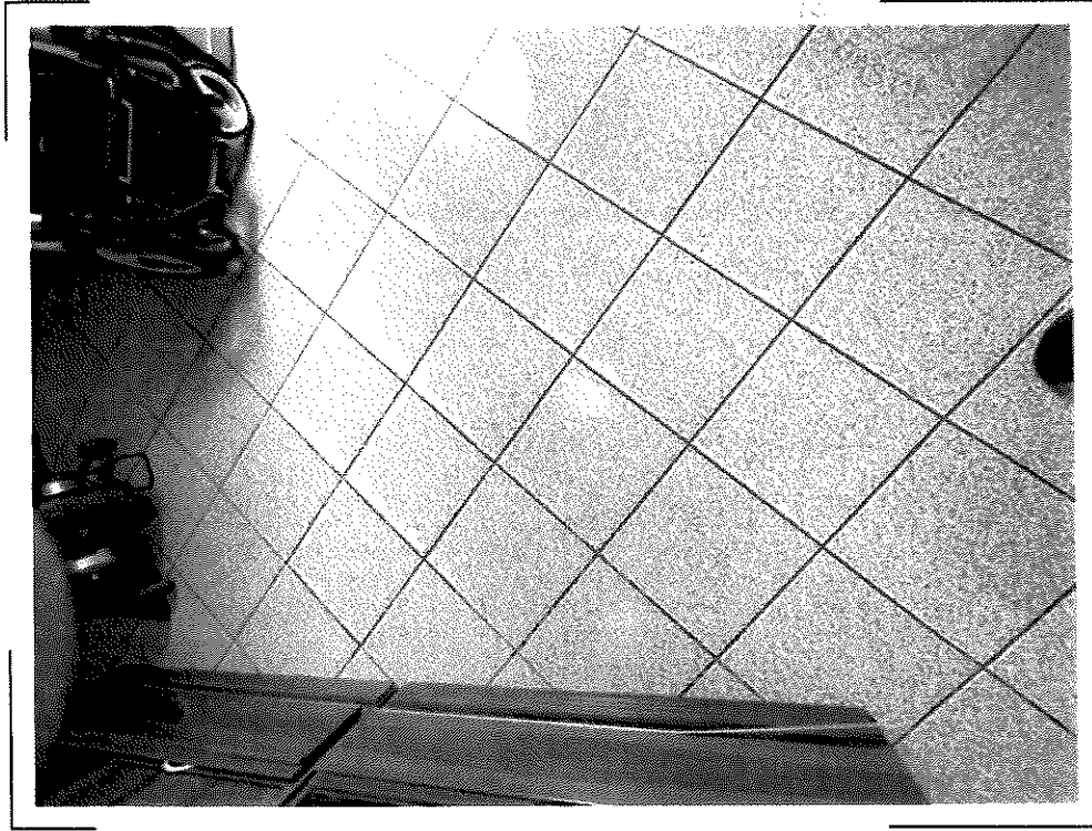
22) CF Fg.4 p.IIa 160 sub.2 – Particolare della pavimentazione dei locali ad uso abitativo al piano terra/rialzato e primo [redacted]
