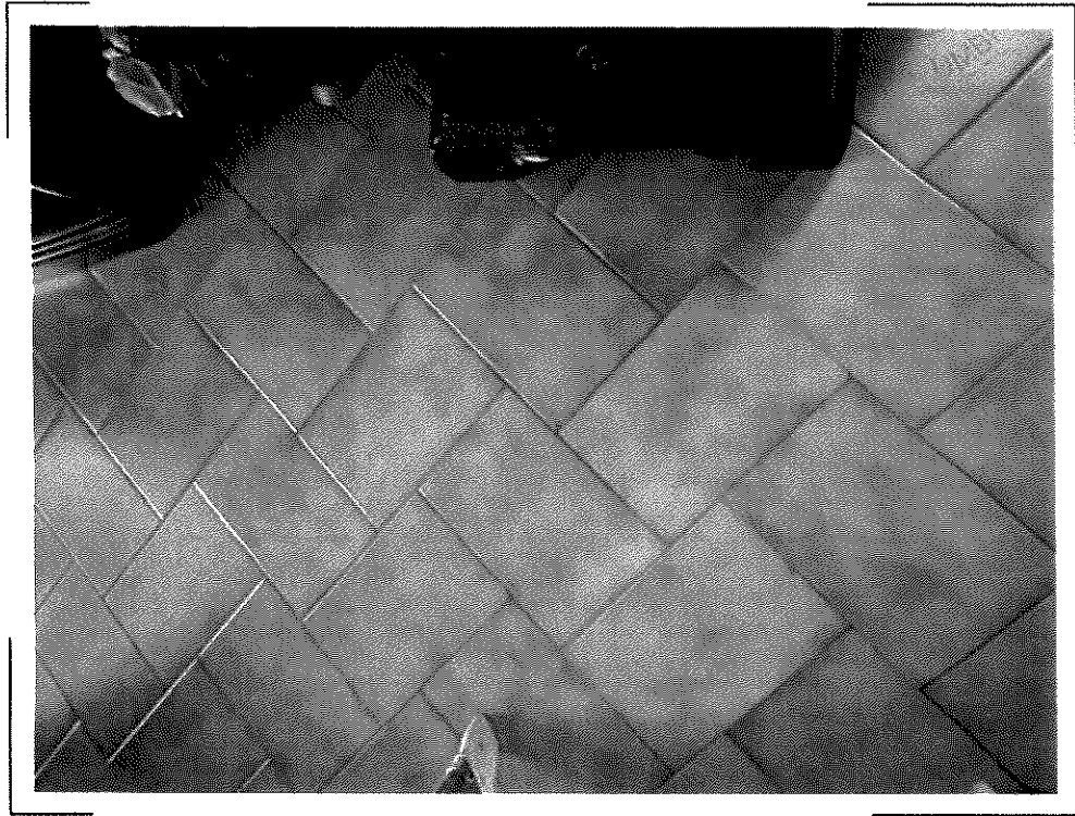
80) CF Fig.4 p.IIa 160 sub. 3 – Particolare della pavimentazione dei locali ad uso abitativo al piano terra e primo [REDACTED]
