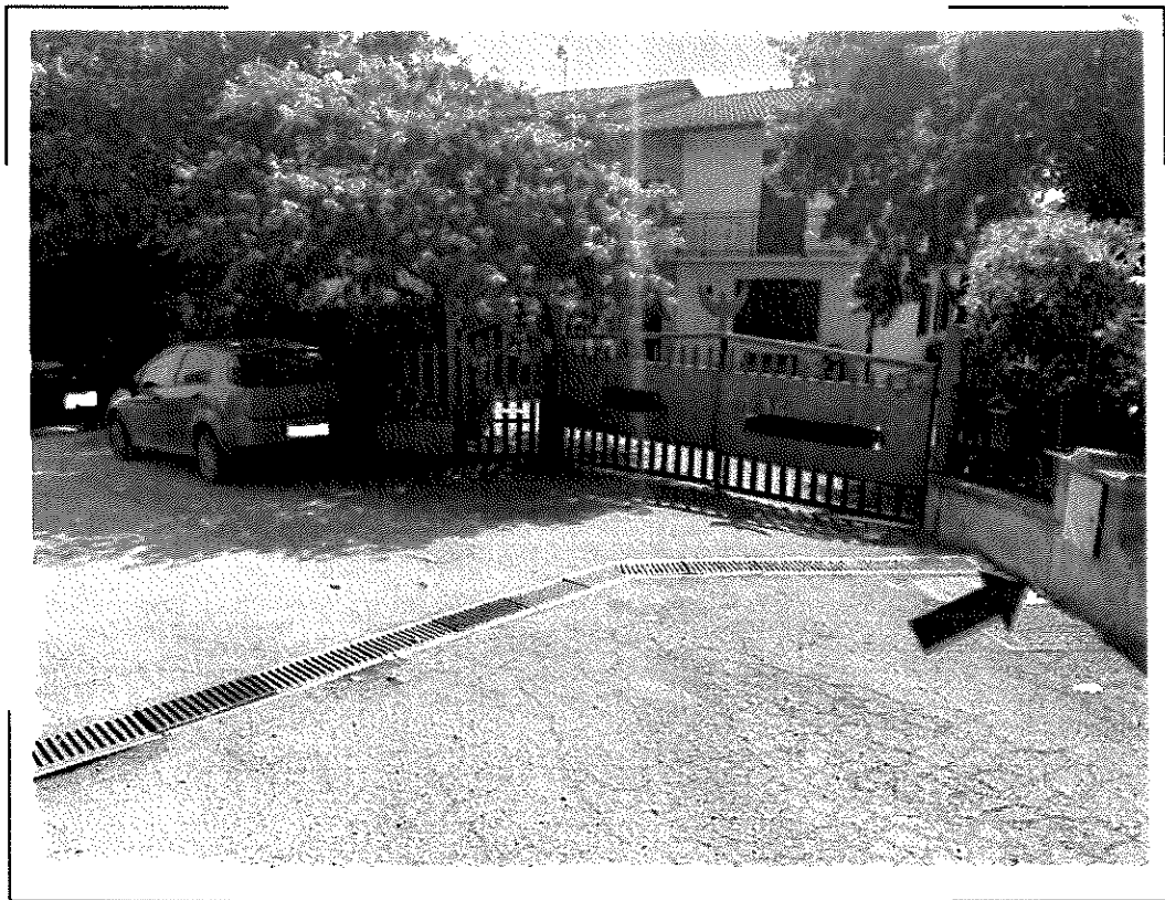
34) CF Fg.4 p.IIa 160 sub.1 (BCNC) – Particolare dell'ubicazione del contatore elettrico
