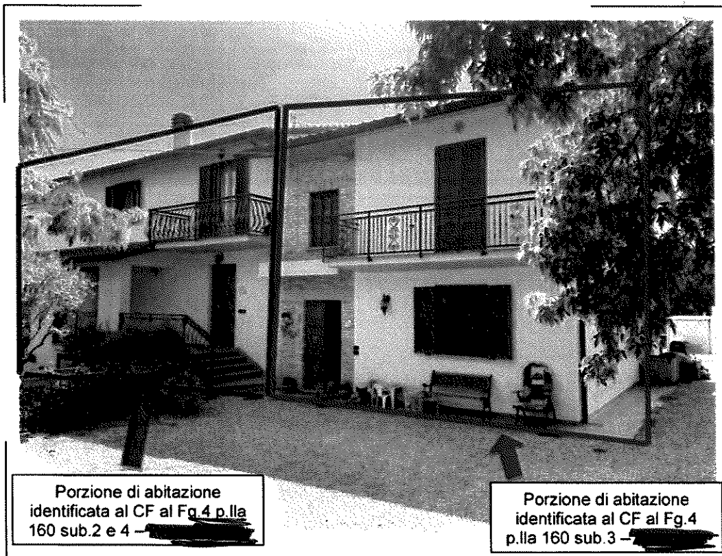
64) CF Fg. 4 p.la 160 sub.1-2-3 e 4 - Vista generale del complesso immobiliare di cui fanno parte i beni oggetto di stima
