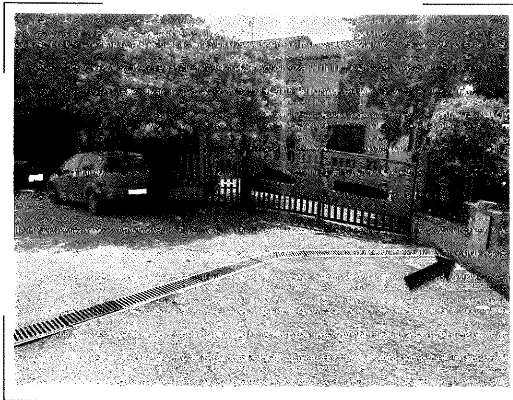
93) CF Fg. 4 p.IIa 160 sub.1 (BCNC) – Particolare dell'ubicazione del contatore elettrico
