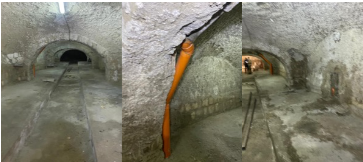
Vista interna del locale deposito e sottoservizi esistenti del fabbricato
