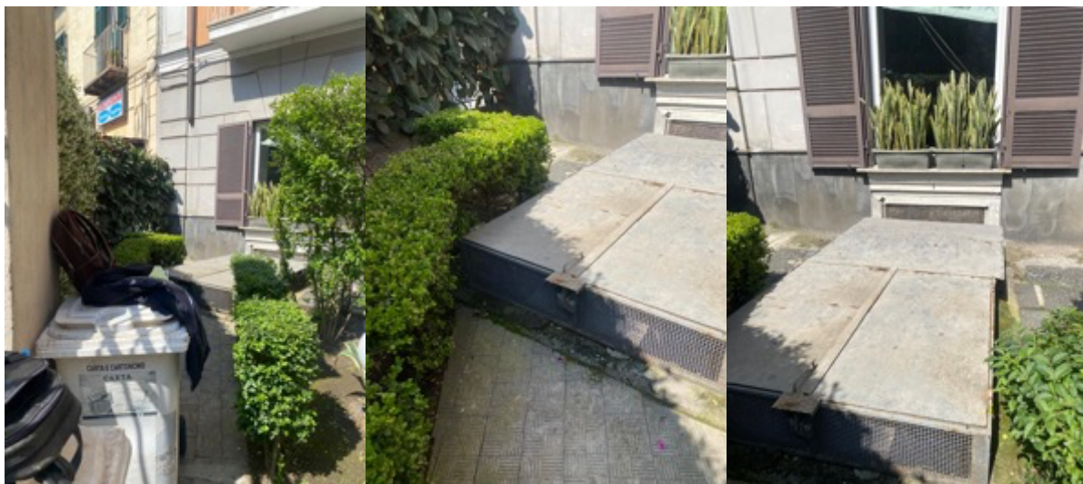
Vista della struttura in ferro e della botola che consente l'ingresso al locale deposito
