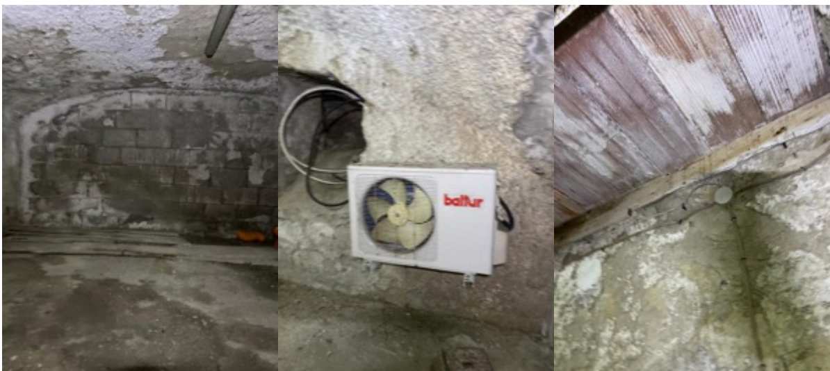
Vista parte del locale e la botola originaria chiusa.
