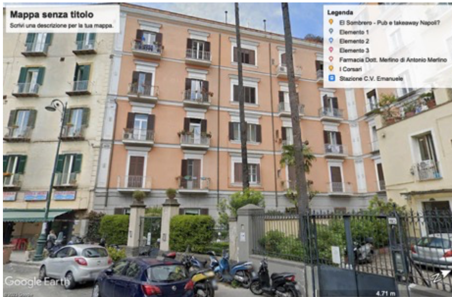
Vista del Fabbricato
