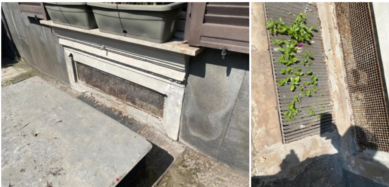
Foto da 8 a 9: Vista apertura per areazione locale interrato
