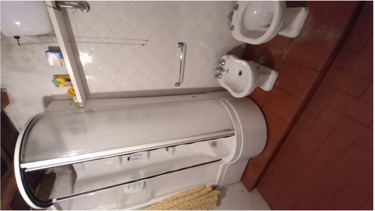
Foto 13 : particolare bagno ( cabina doccia ) .
