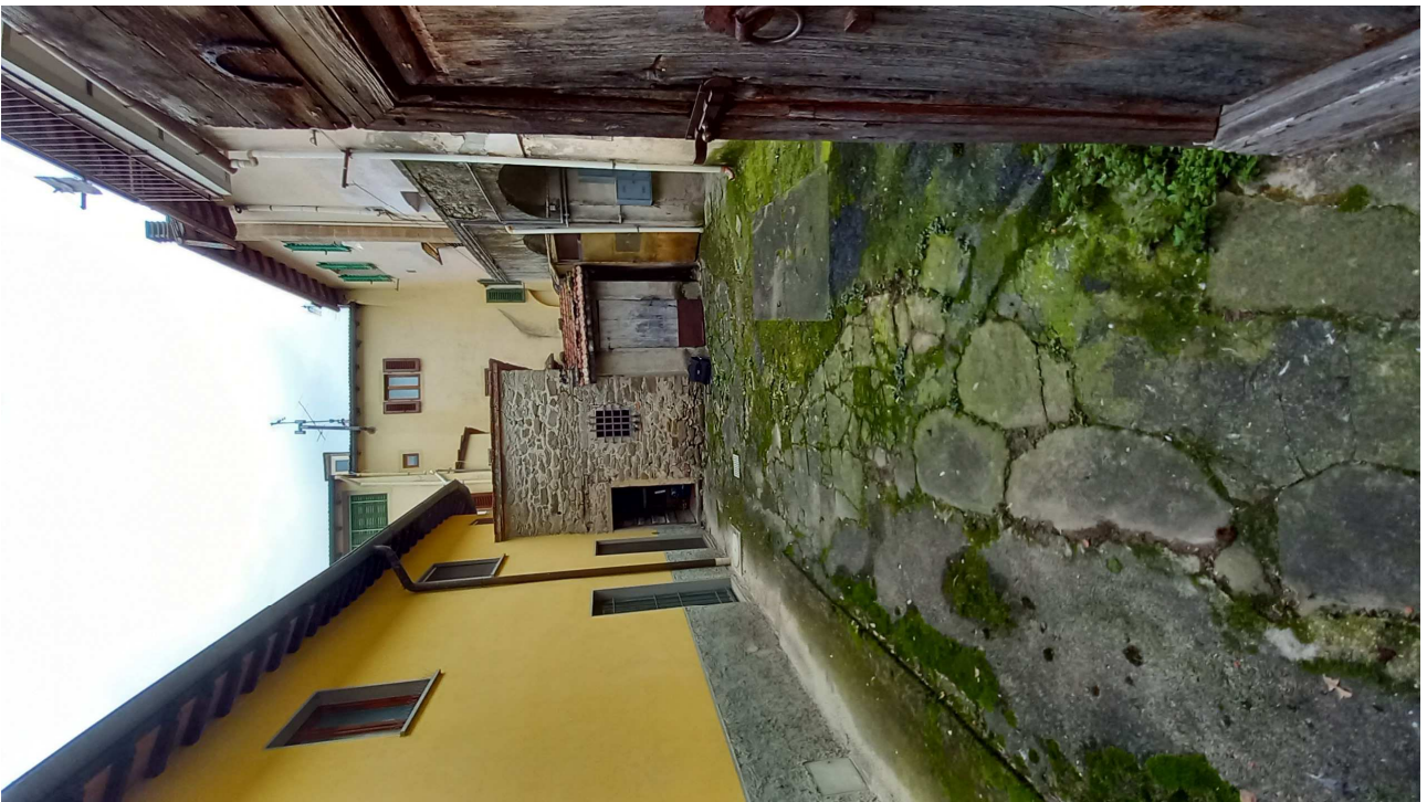
Foto 24 : coorte a comune per accesso a deposito/legnaia
