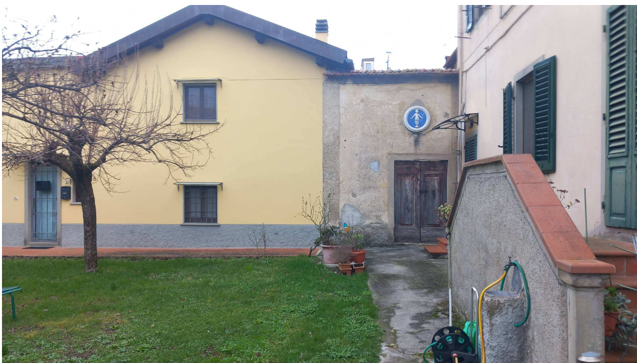
Foto : 21 e 22 : ingresso corte comune del deposito/ legnaia al piano terra
