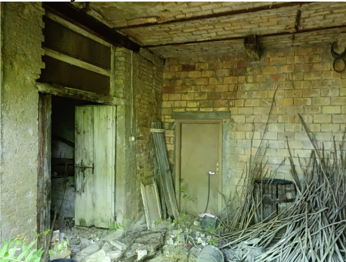
Piano Terra Magazzino – Rimessa lato Nord
