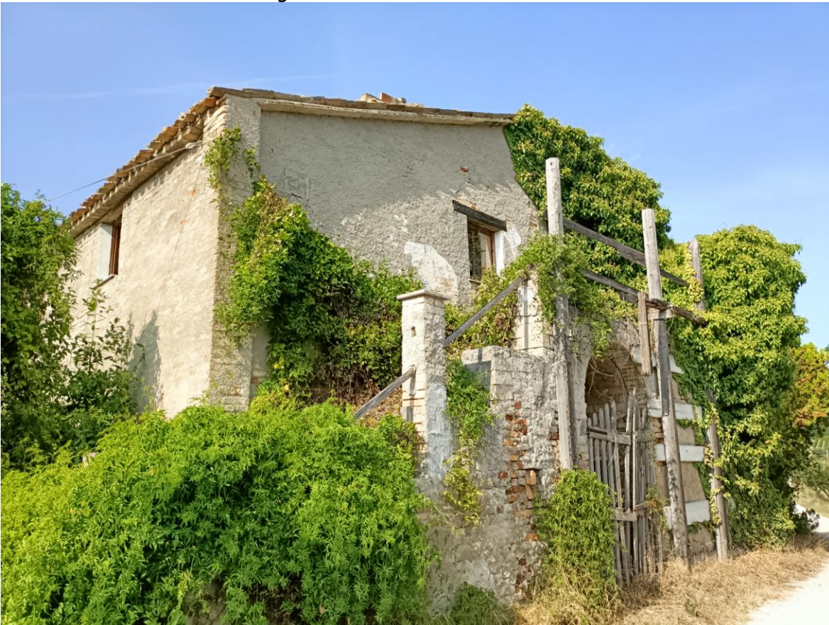
Vista dalla Strada Vicinale - Ingresso lato Sud
