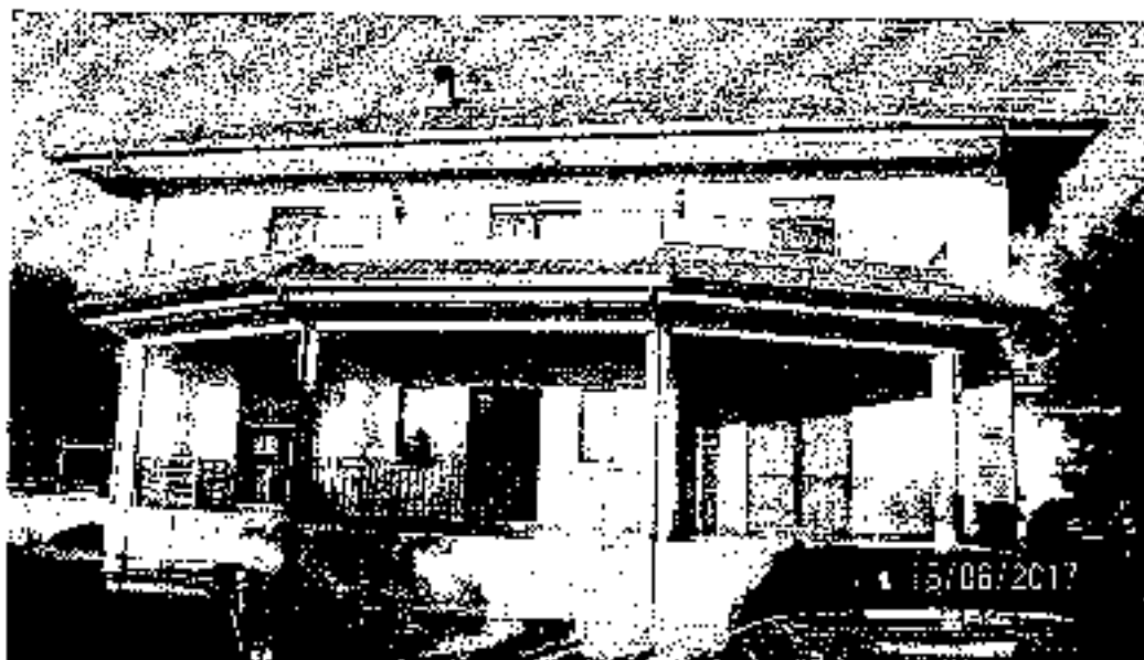
Fabbricato Prospetto principale lato ovest
