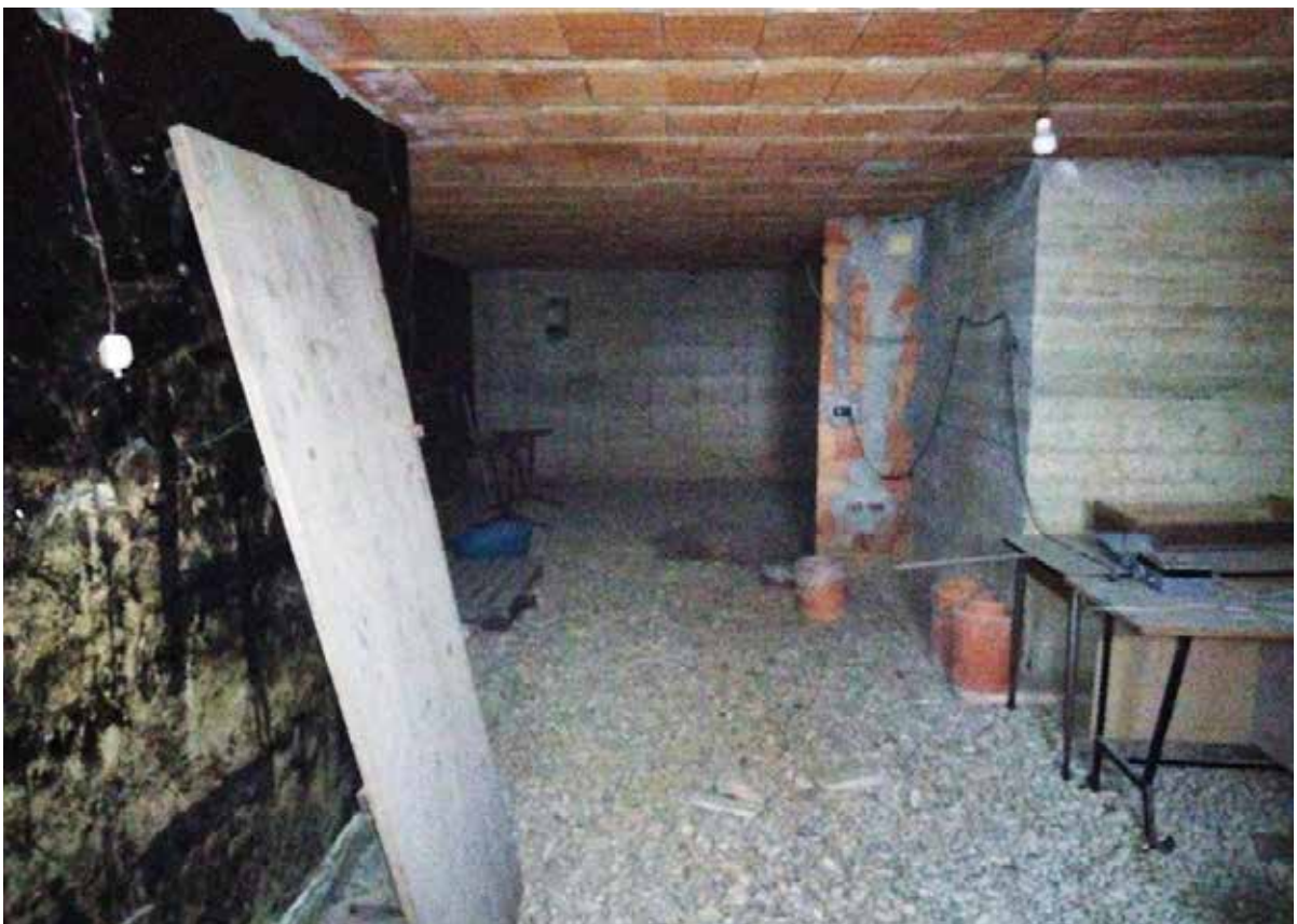
Riferimento 9 - Sub 9 - Seminterrato
