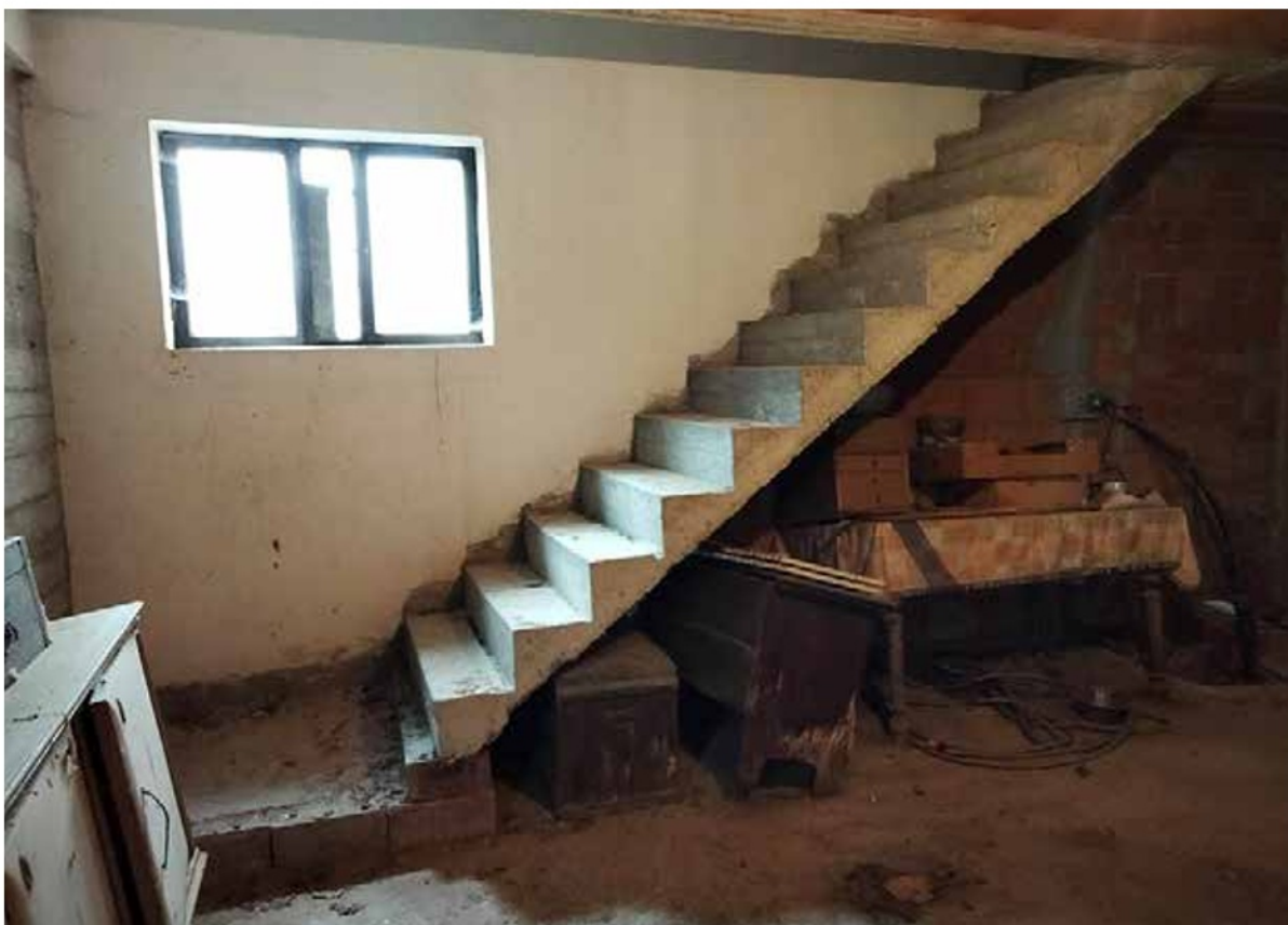
Riferimento 9 - Sub 9 - Scala di accesso dal seminterrato al piano rialzato
