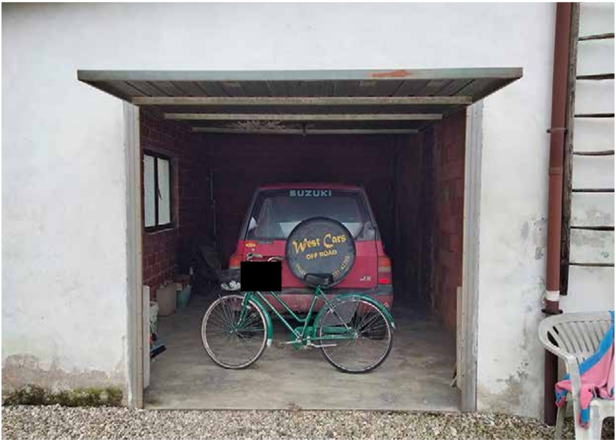
Riferimento 5 - Sub 5 - Autorimessa
