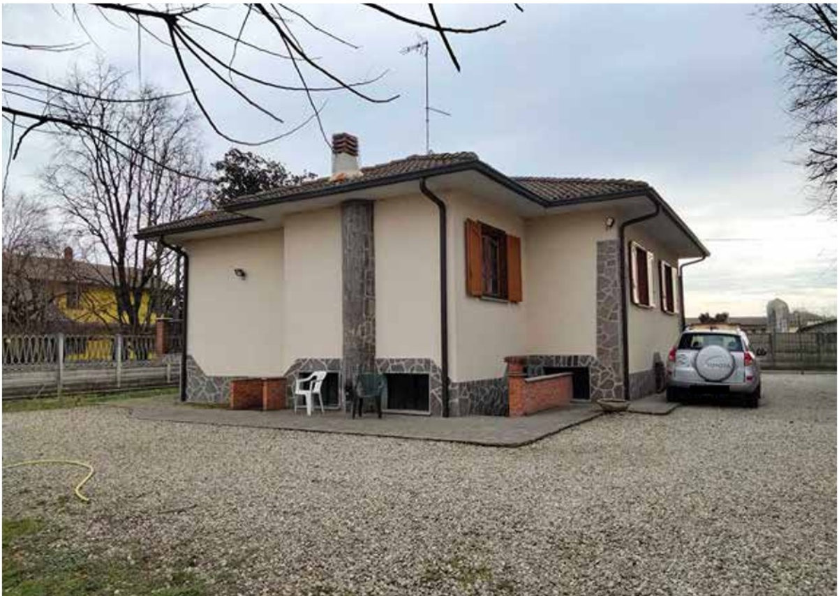
Riferimento 9 - Sub 9 - Esterno retro
