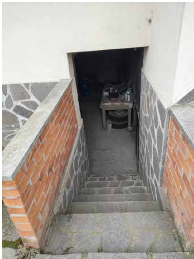
Riferimento 9 - Sub 9 - Scala di accesso al seminterrato
