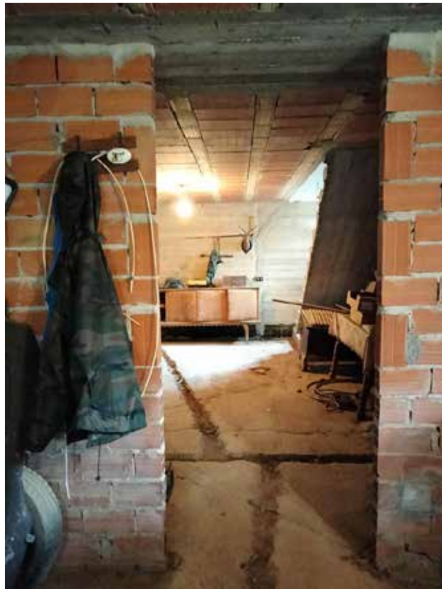
Riferimento 9 - Sub 9 - Seminterrato
