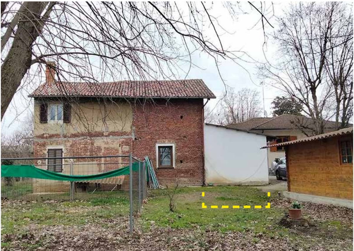
Riferimento 5 - Sub 5 - Esterno retro
