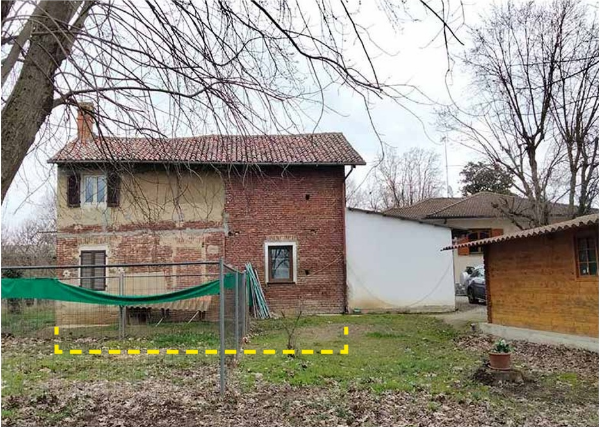
Riferimento 10 - Sub 10 - Esterno retro
