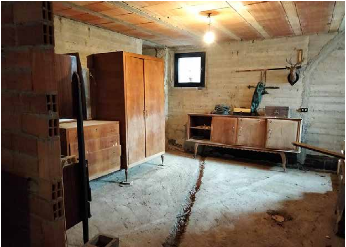
Riferimento 9 - Sub 9 - Seminterrato
