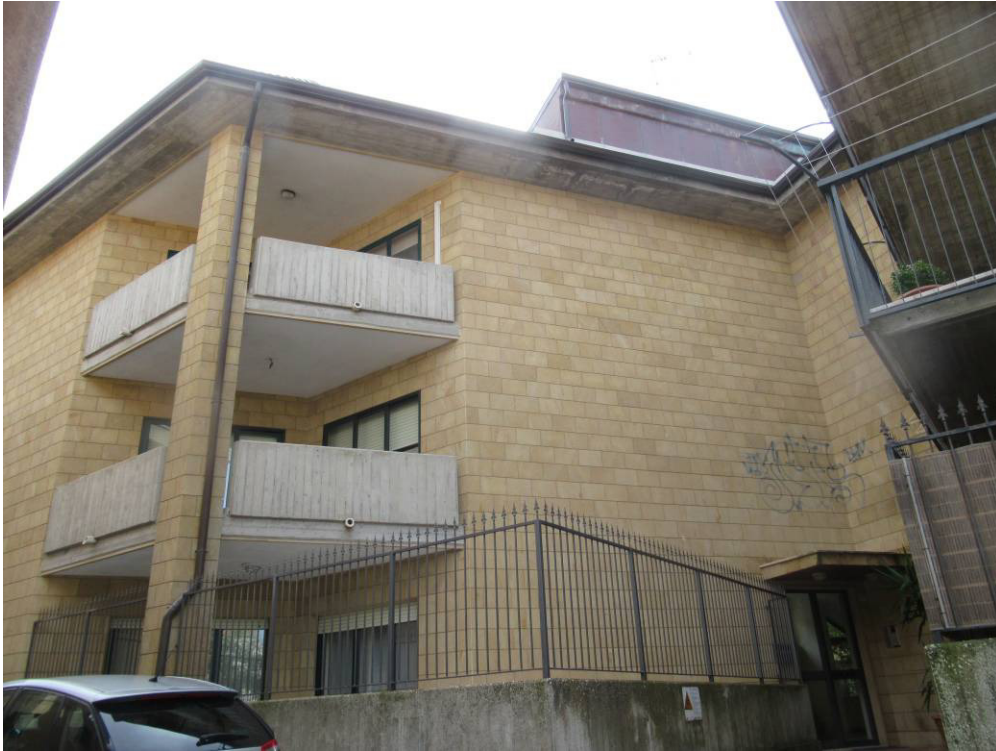
Foto n ° 1 – Prospetto della palazzina condominiale di Via Catena n ° 55 in Enna. –
