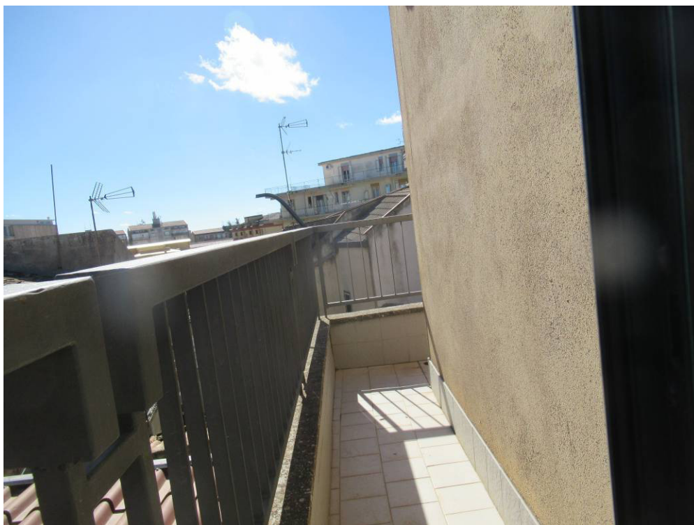
Foto n ° 45 – Idem foto n ° 44. –
