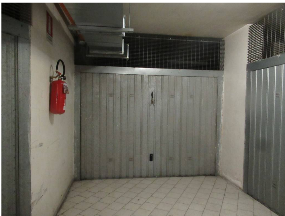
Foto n ° 46 – Ingresso del garage con saracinesca basculante. –
