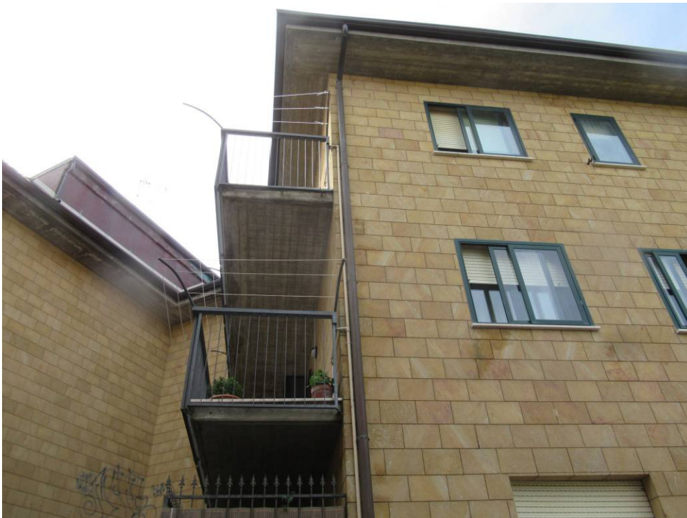
Foto n ° 2 – Idem foto n ° 1. –
