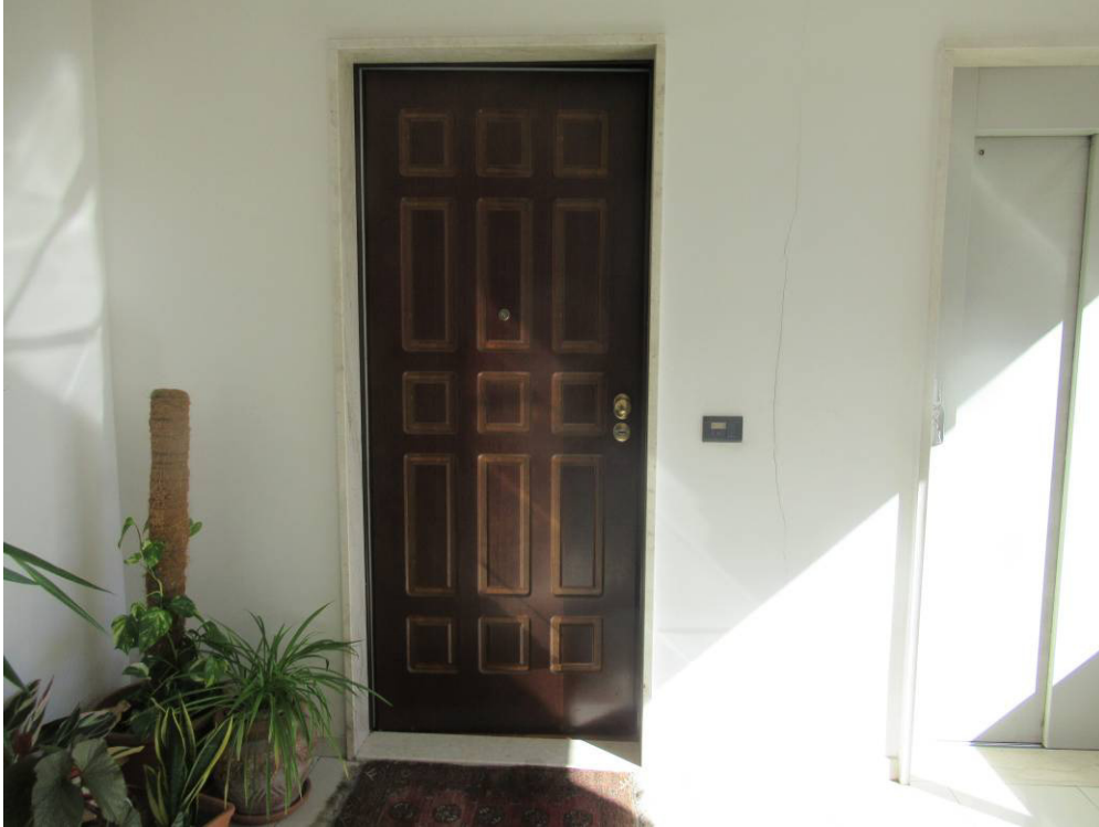
Foto n ° 11 – Porta d'ingresso corazzata dell'immobile di parte esecutata. –
