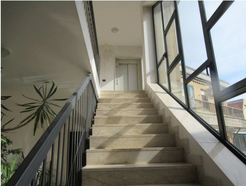
Foto n ° 9 – Rampa di scale conducente ai piani superiori ed all'ascensore. –
