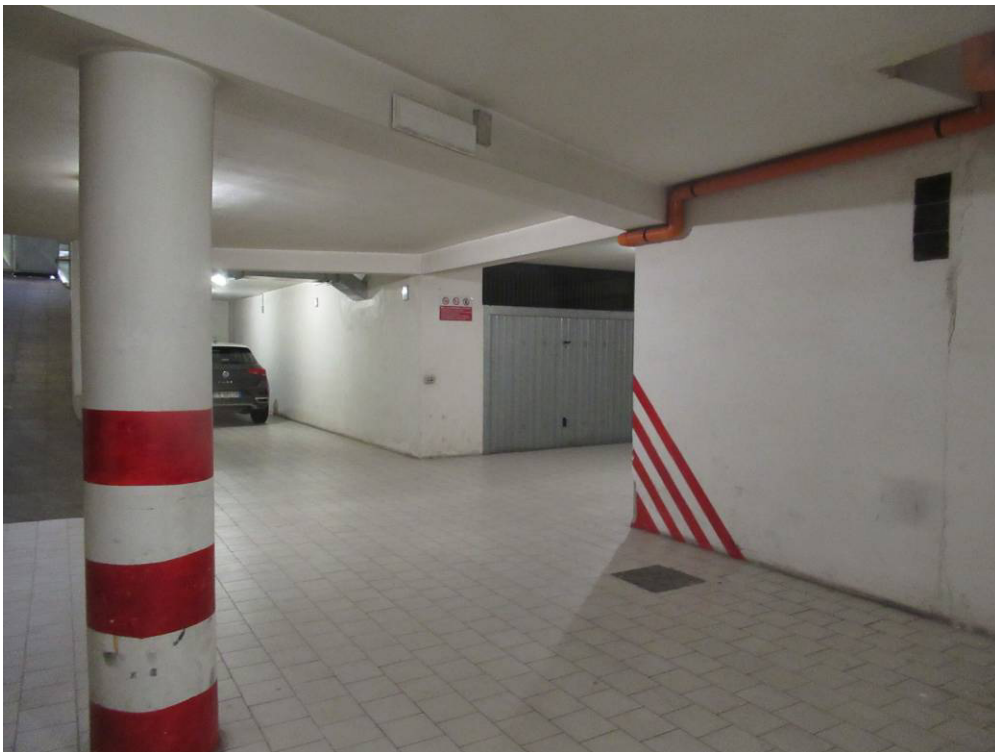
Foto n ° 48 – Idem foto n ° 47. –
