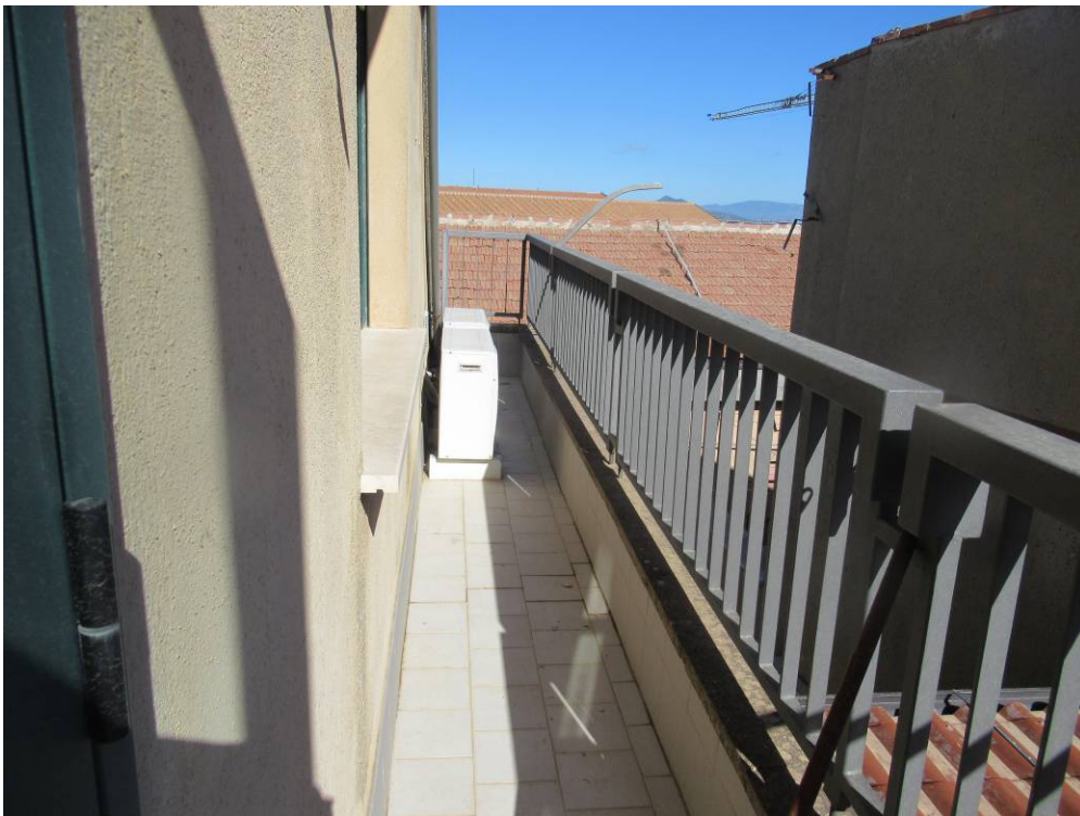
Foto n ° 44 – Balcone perimetrale al piano 3°. –
