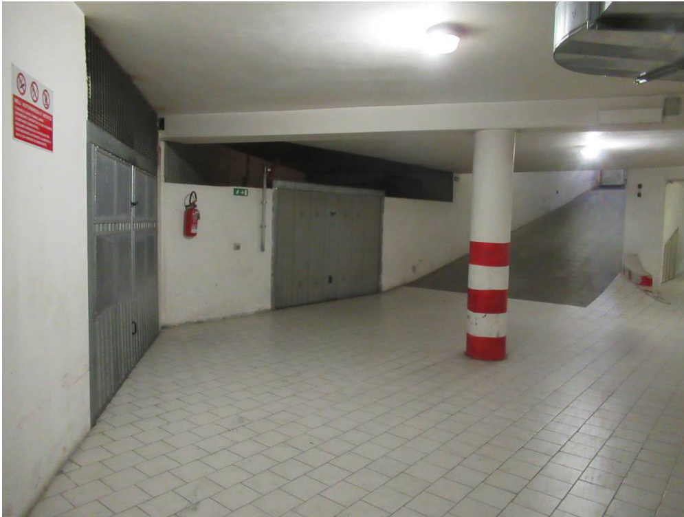
Foto n ° 47 – Spazi di manovra al piano S1. –
