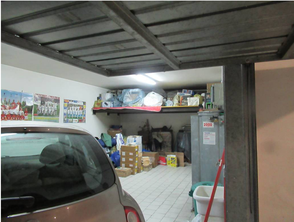
Foto n ° 49 – Interno del garage piastrellato ed intonacato. –
