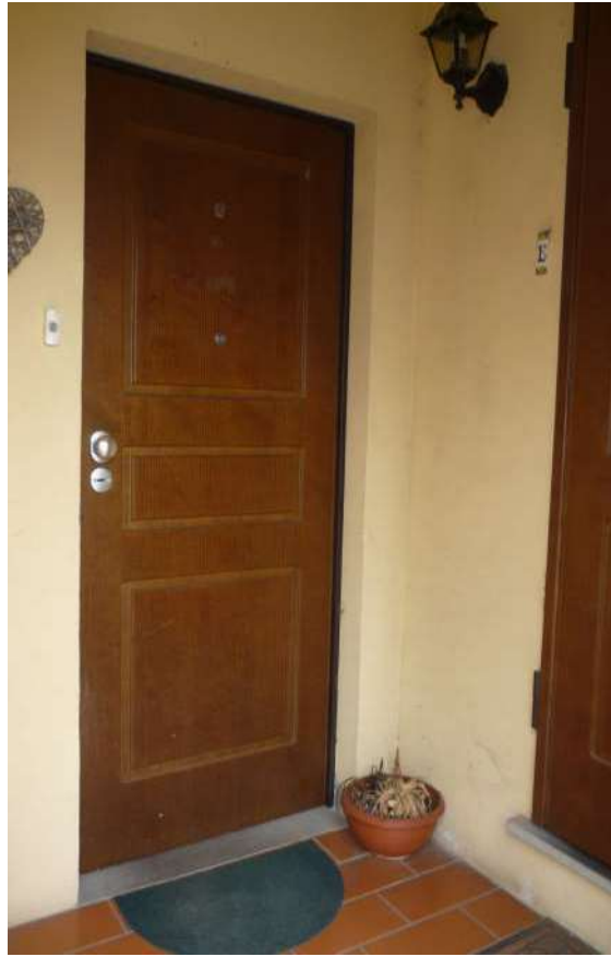
FOTO n. 1 – portoncino d'ingresso all'appartamento
