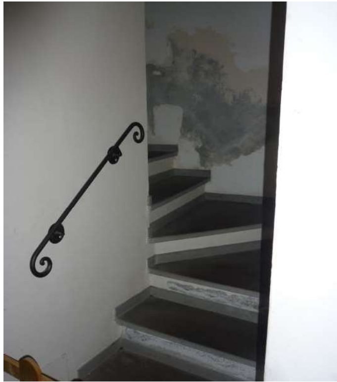
FOTO n.12 – rampa scala di accesso al piano primo
