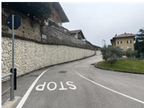
Parte di viabilità potenziata di accesso all'area edificabile
