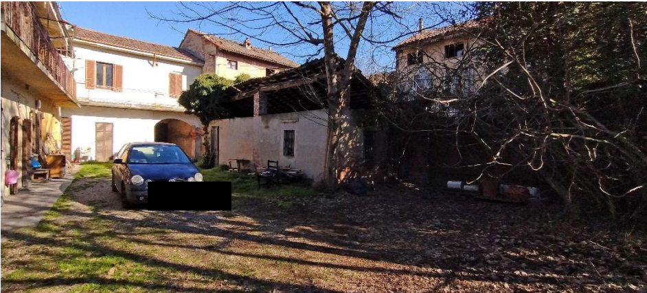
Cortile, locale cantina
