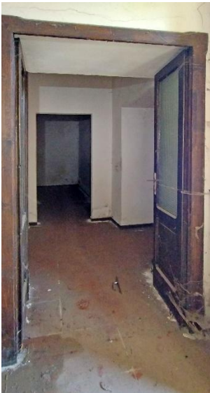
Ingresso dal vano scala
