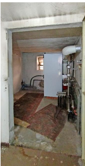
Ingresso al ripostiglio
