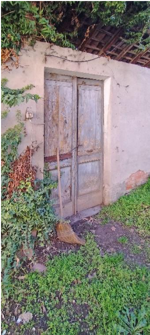
Porta locale cantina
