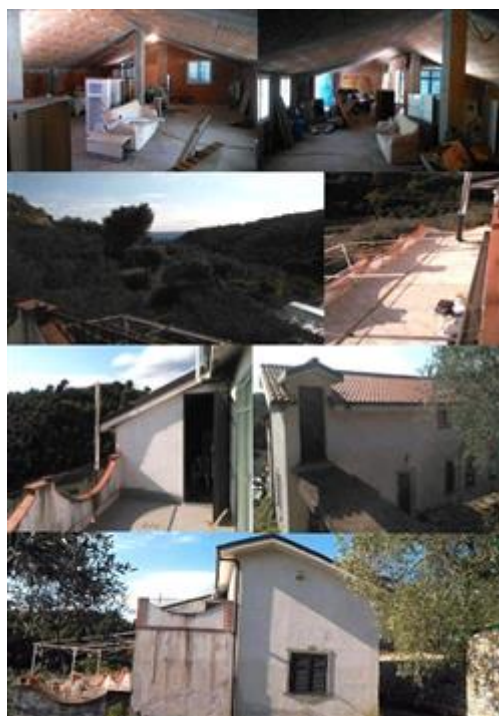
riprese fotografiche all'interno del piano sottotetto e riprese all'esterno dell'immobile
