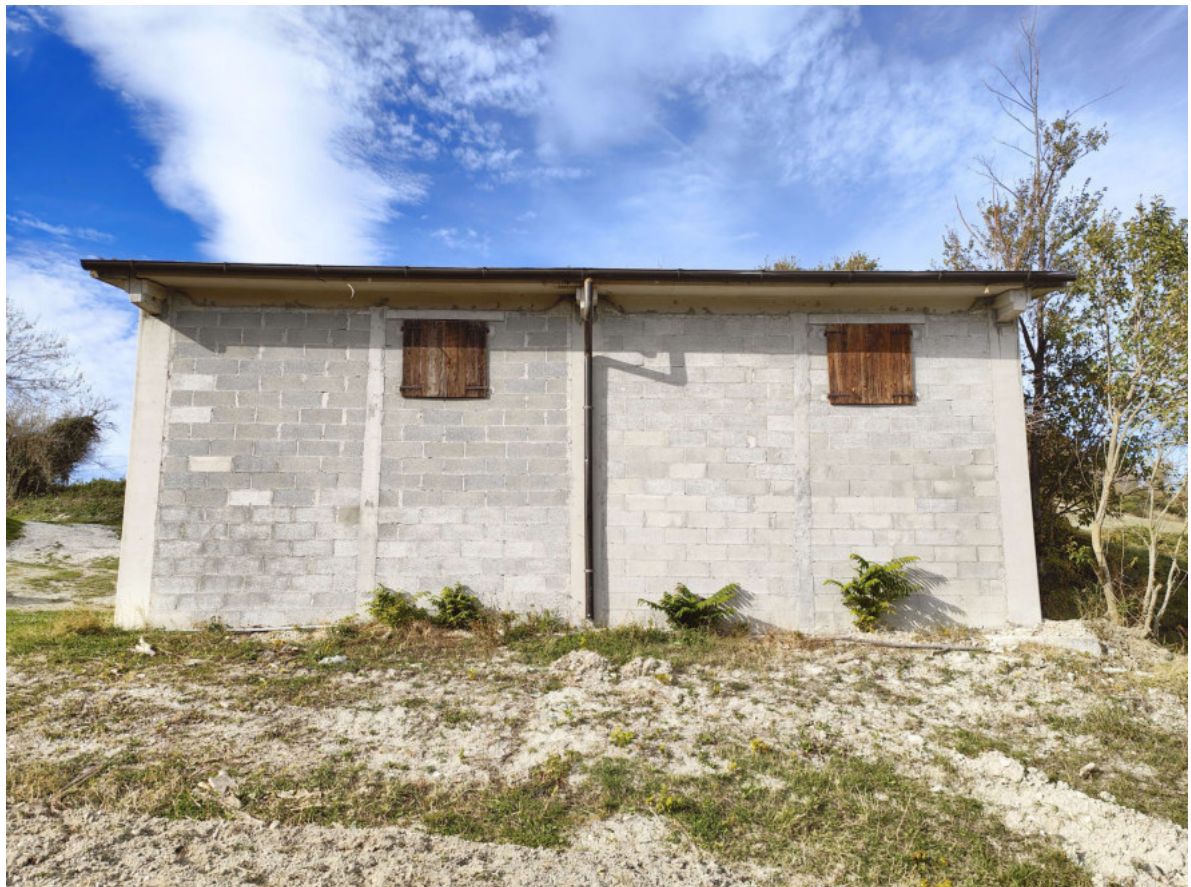
02) Fabbricato per usi agricoli - Fianco destro
