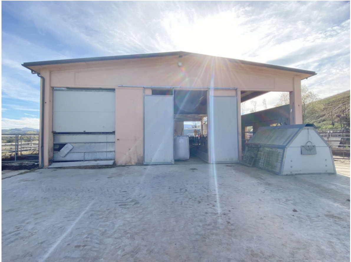
03) Stallone - Fabb. a) Retro - piazzale
