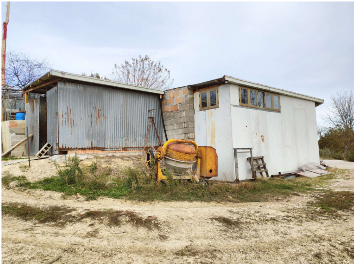
10) Struttura precaria (2-3) da rimuovere
