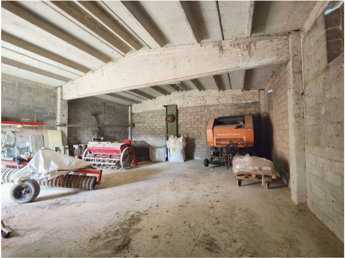
05) Fabbricato per usi agricoli - Vista interna
