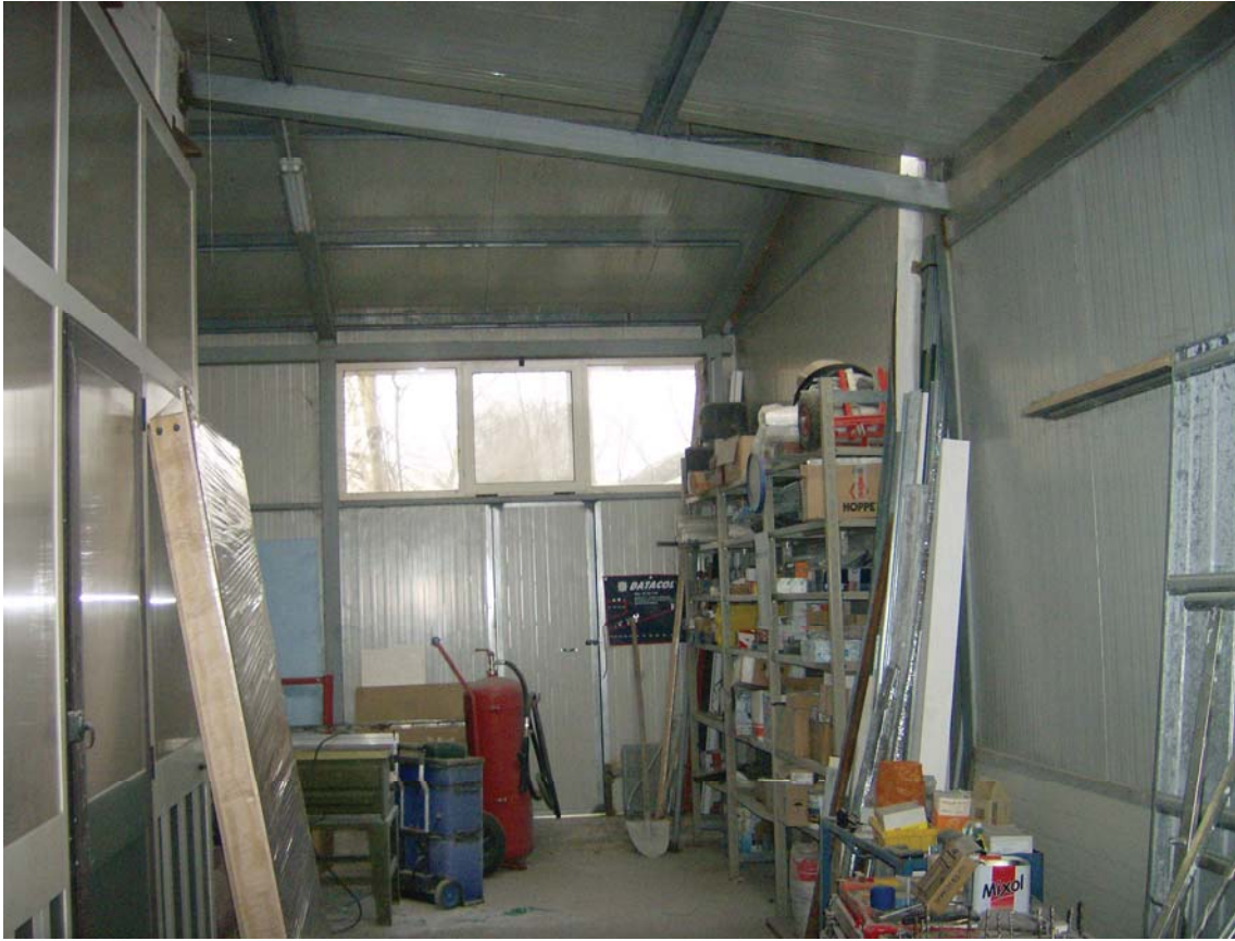
13- Scorcio pensilina a L su parete sud del pt.
