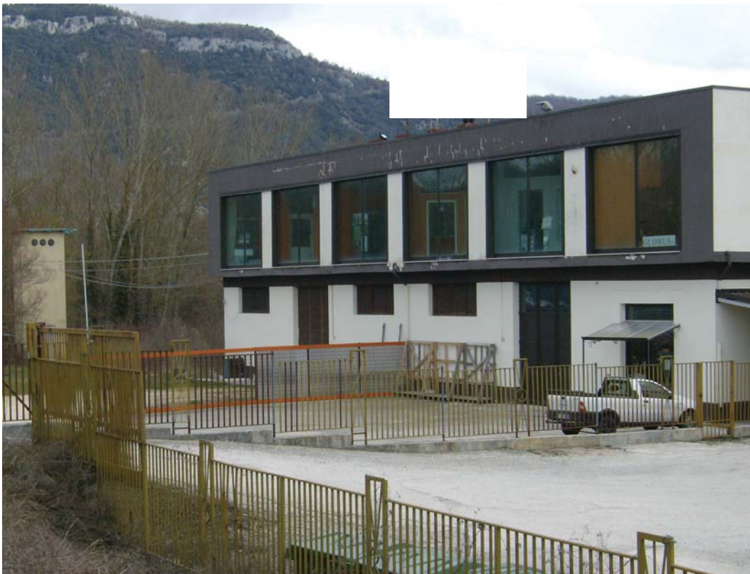
2-Vista ravvicinata; piano terra solo metà secondo la striscia rossa; 1° piano tutti i finestroni.
