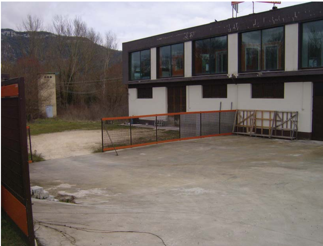
4- Cortile con lastrico in battuto di cemento; metà del pt oltre la recinzione è di altra ditta.
