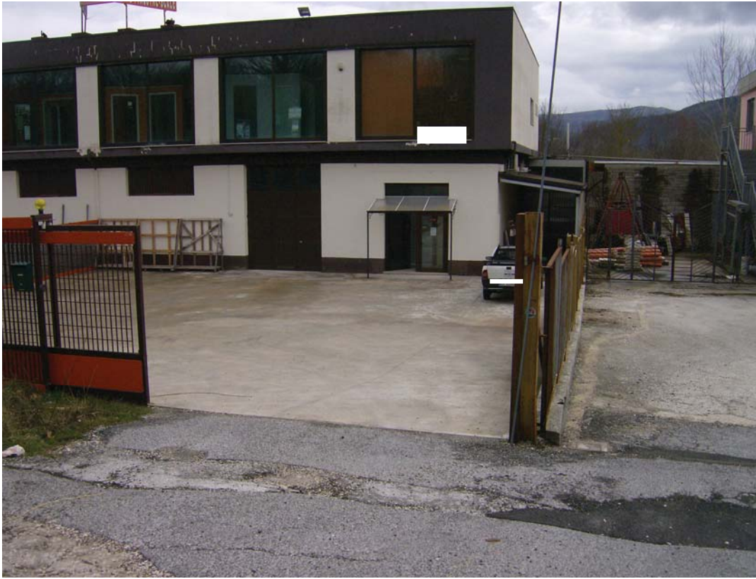
3- particolare del cancello, del piazzale e parte del prospetto. A dx visibile scorcio della tettoia che gira anche sul retro.
