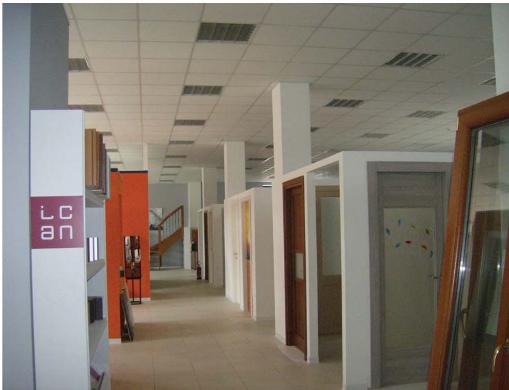
8- Interno locale 1°p, attualmente adibito ad esposizione commerciale; visibile contro soffittatura e plafoniere al neon;
