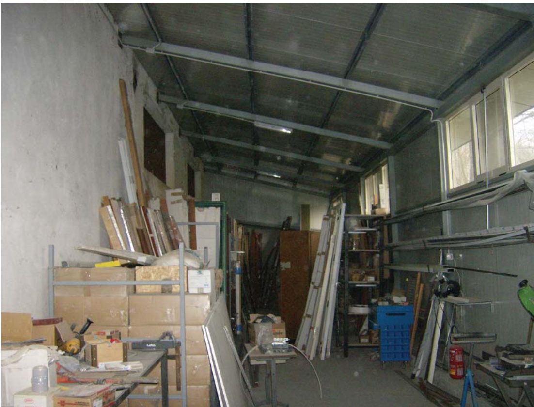
14-Prolungamento pensilina su parete est del pt (lato canale "Forma")
