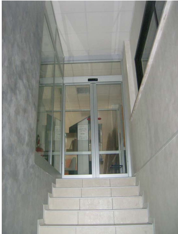
7- Vano scala c al 1°p; porta automatica in sommità.
