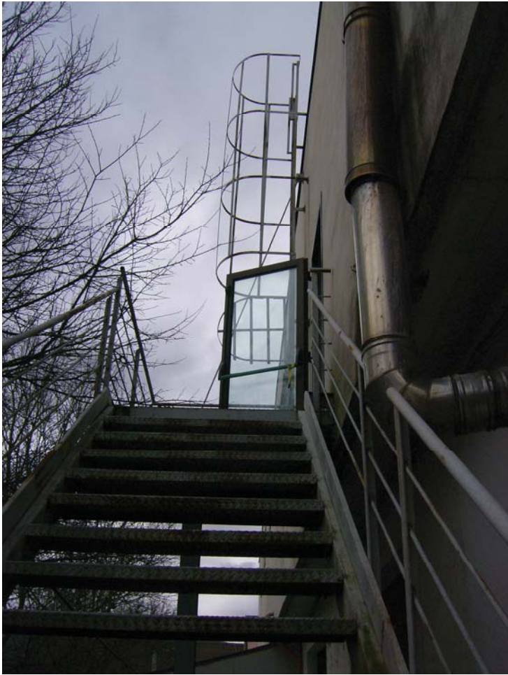
5-Scala esterna antincendio
