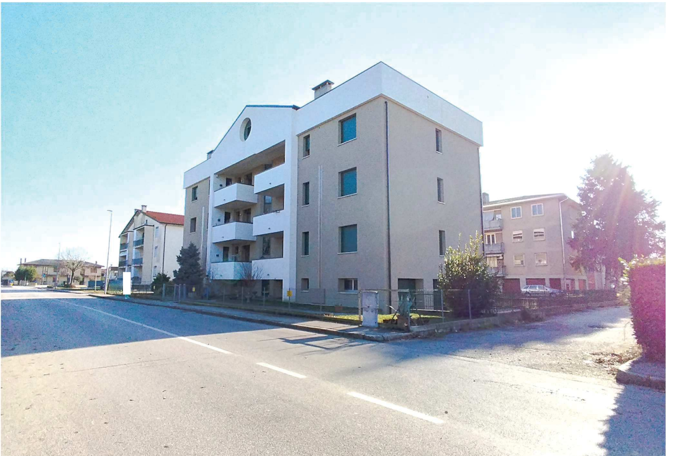
Veduta esterna del fabbricato condominiale
