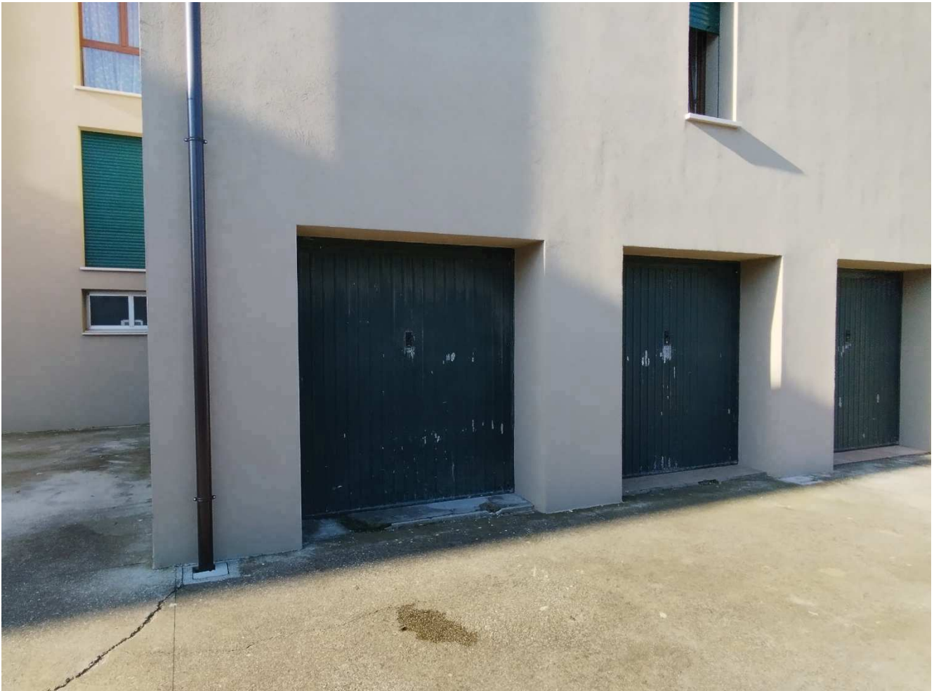
Scoperto condominiale verso i garage
