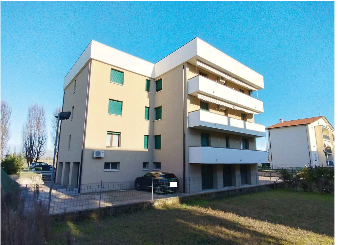
Veduta esterna del fabbricato condominiale
