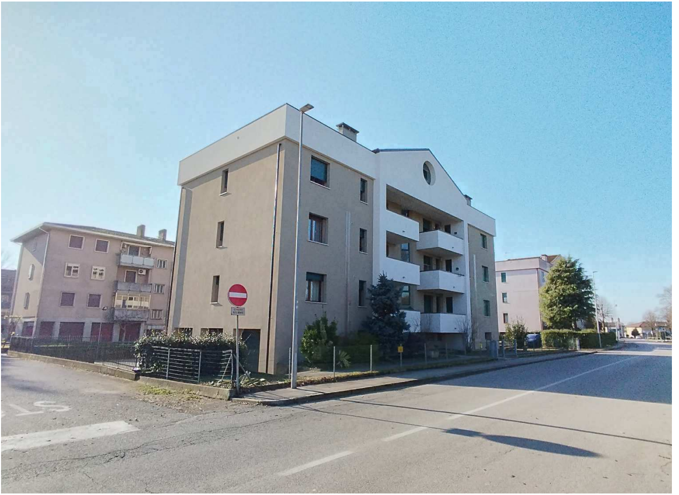
Veduta esterna del fabbricato condominiale
