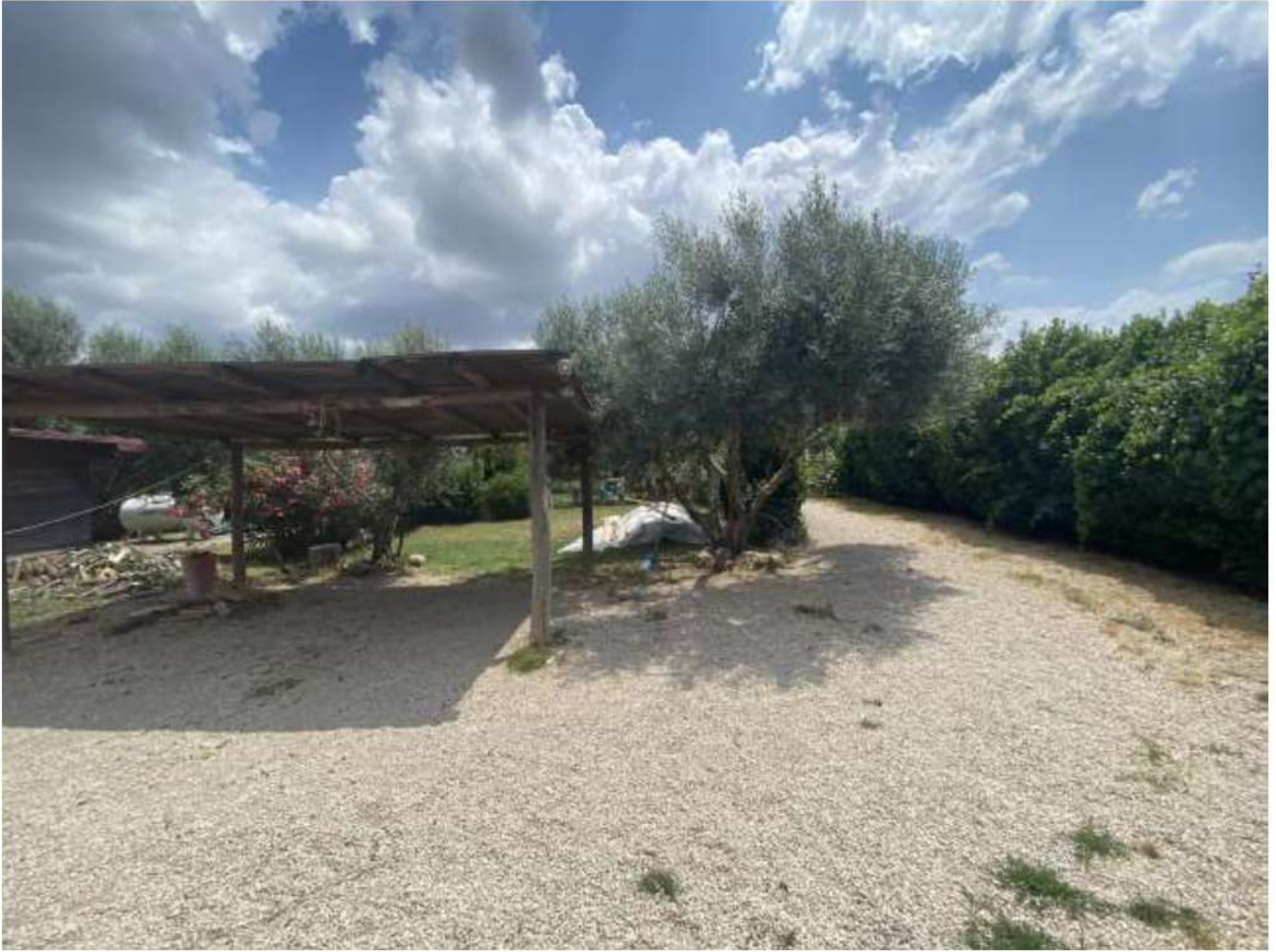
tettoie ed accessori esterni da demolire
