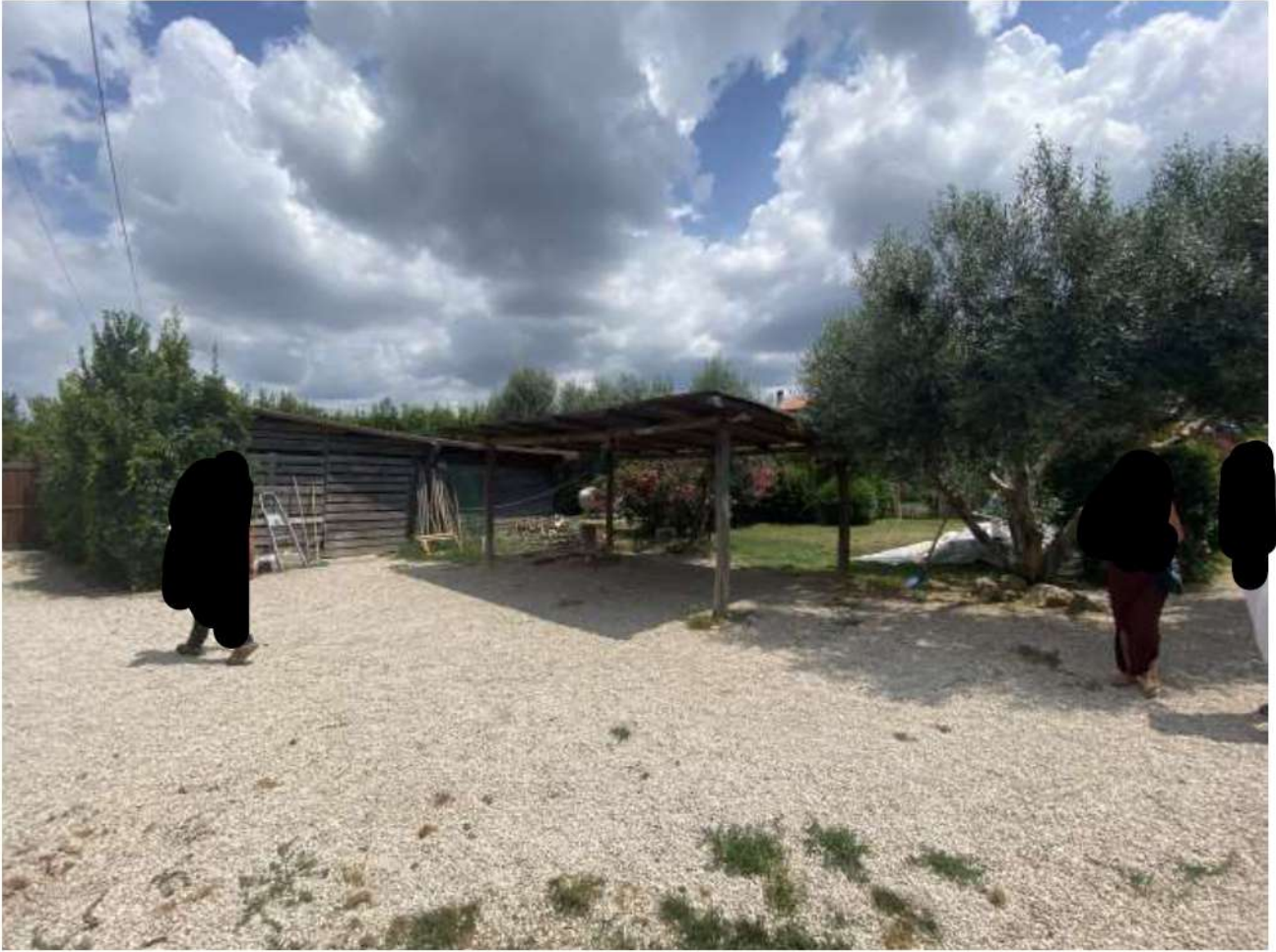
tettoie ed accessori esterni da demolire
