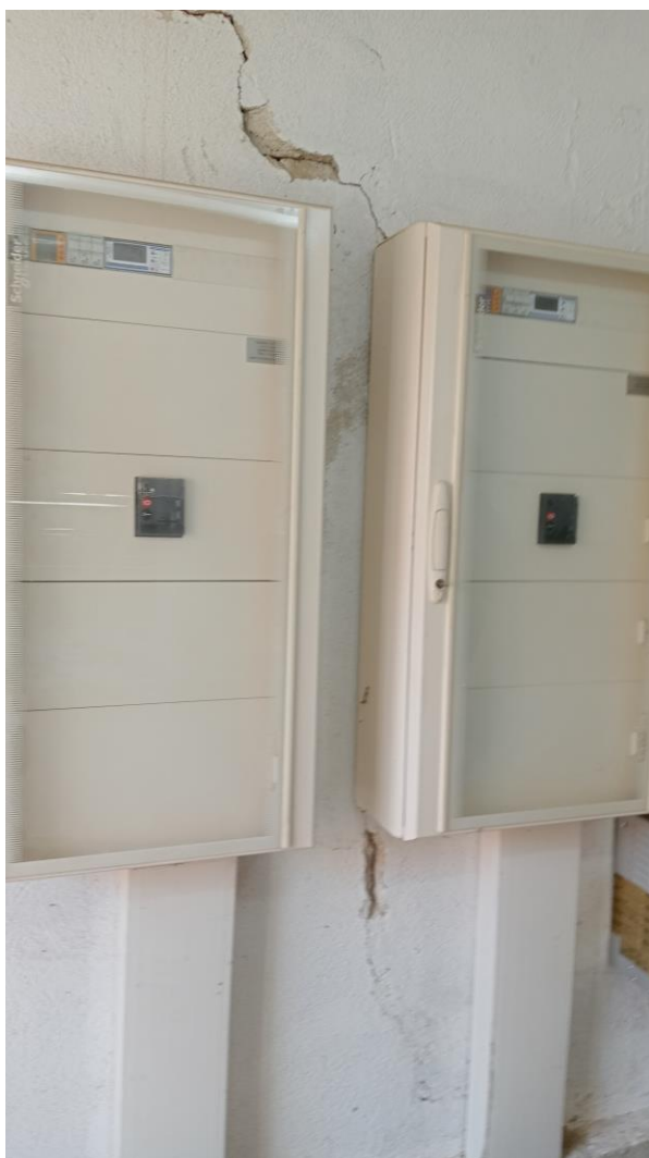
Foto 5-6-7. Particolari della lesione sul locale cabina Corpo B
