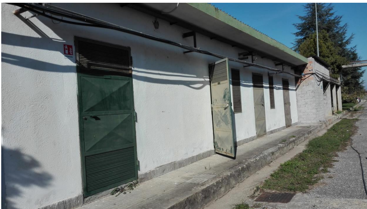
Foto 17. Porte d'ingressi dei locali corpo B
