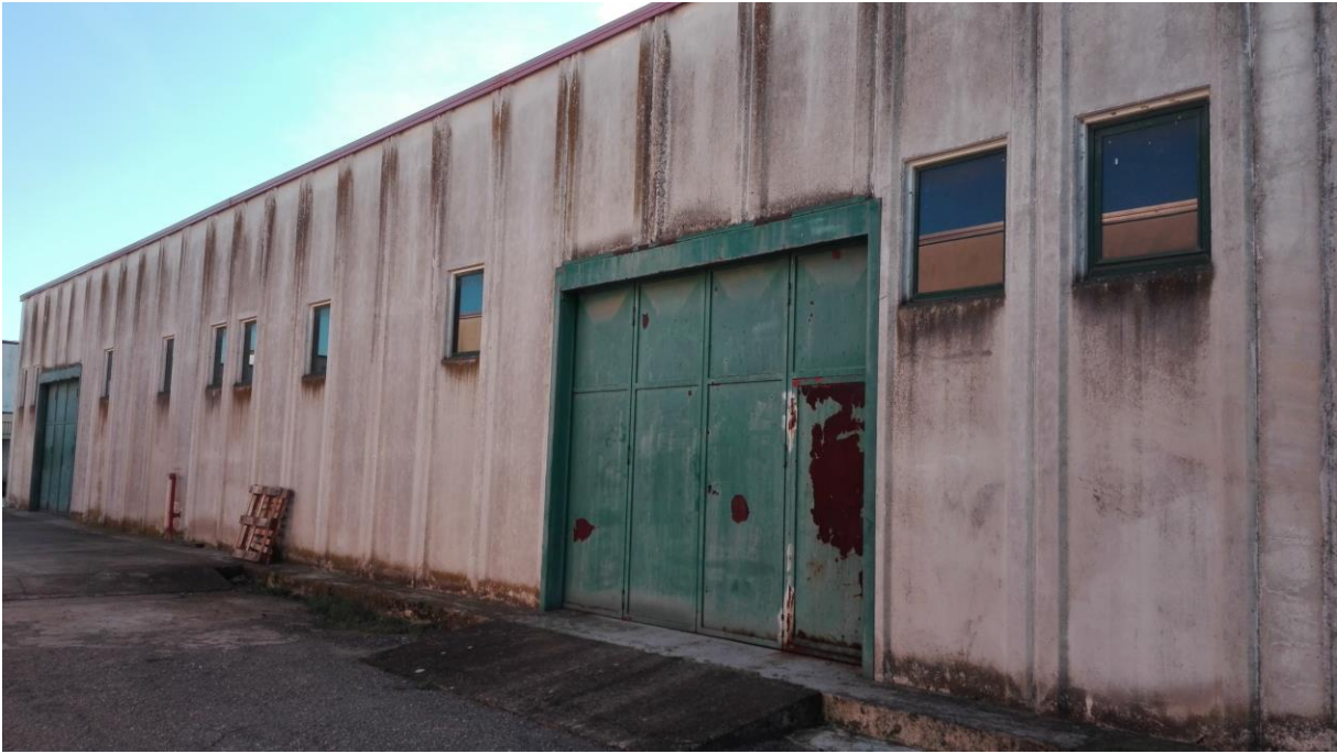
Foto 16. Porta d'ingresso scorrevole al capannone corpo A.
