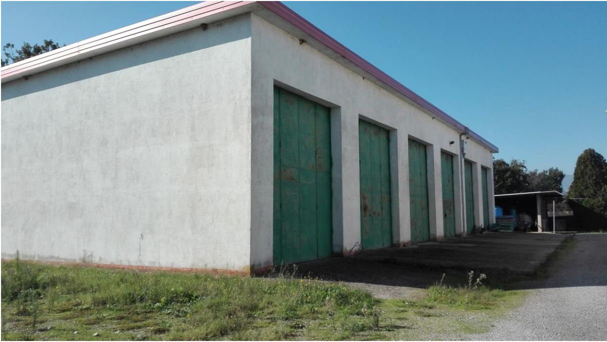
Foto 20. Il fabbricato corpo A.
