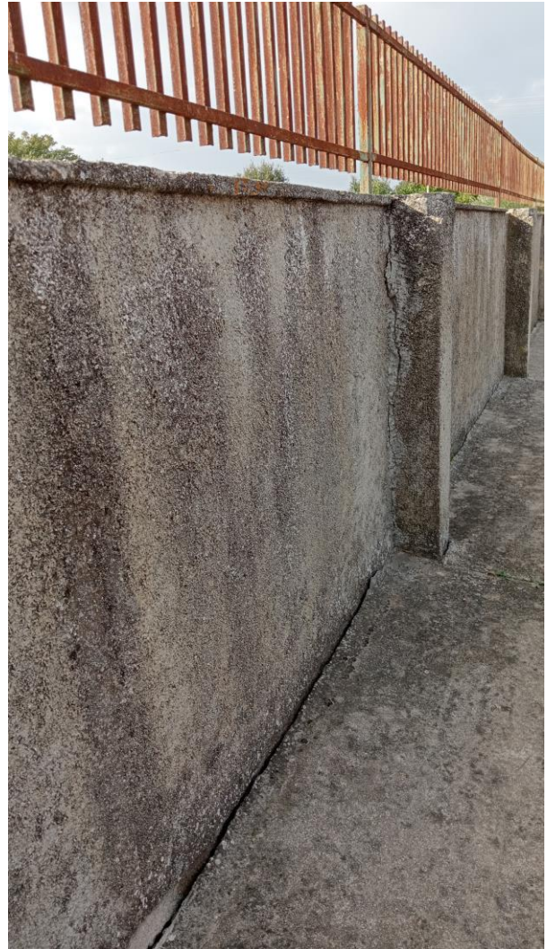
Foto 13-14. Particolari delle crepe sui muri perimetrali di recinzioni della proprietà.
