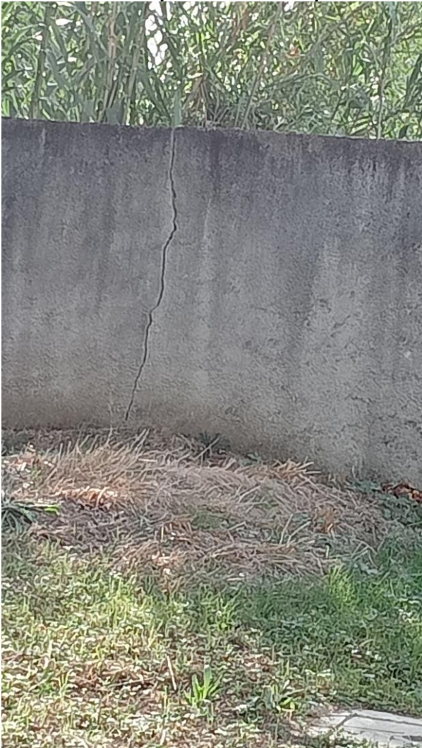
Foto 13-14. Particolari delle crepe sui muri perimetrali di recinzioni della proprietà.
