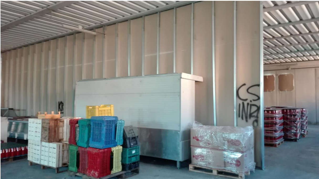
Foto 80-81. Particolari dell'interno del capannone corpo A.
