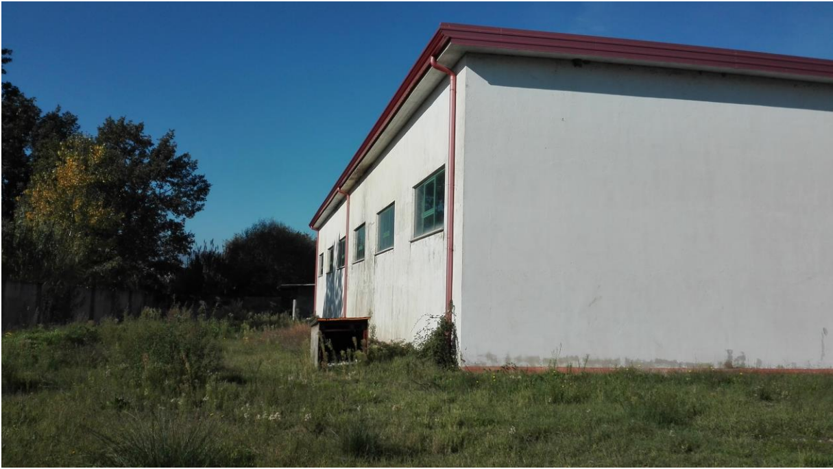
Foto 95. Corpo A lato sud est.
