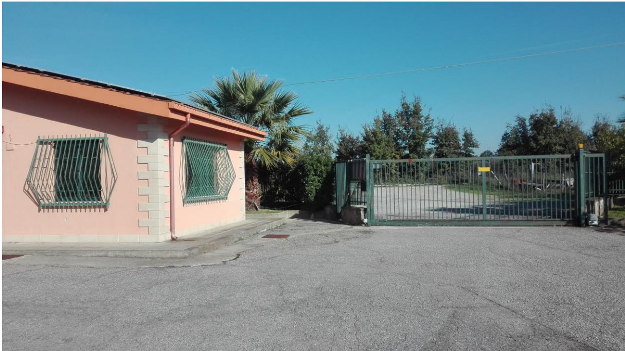
Foto 3-4. Particolari Unità immobiliare part. 62 sub 3 Corpo A
