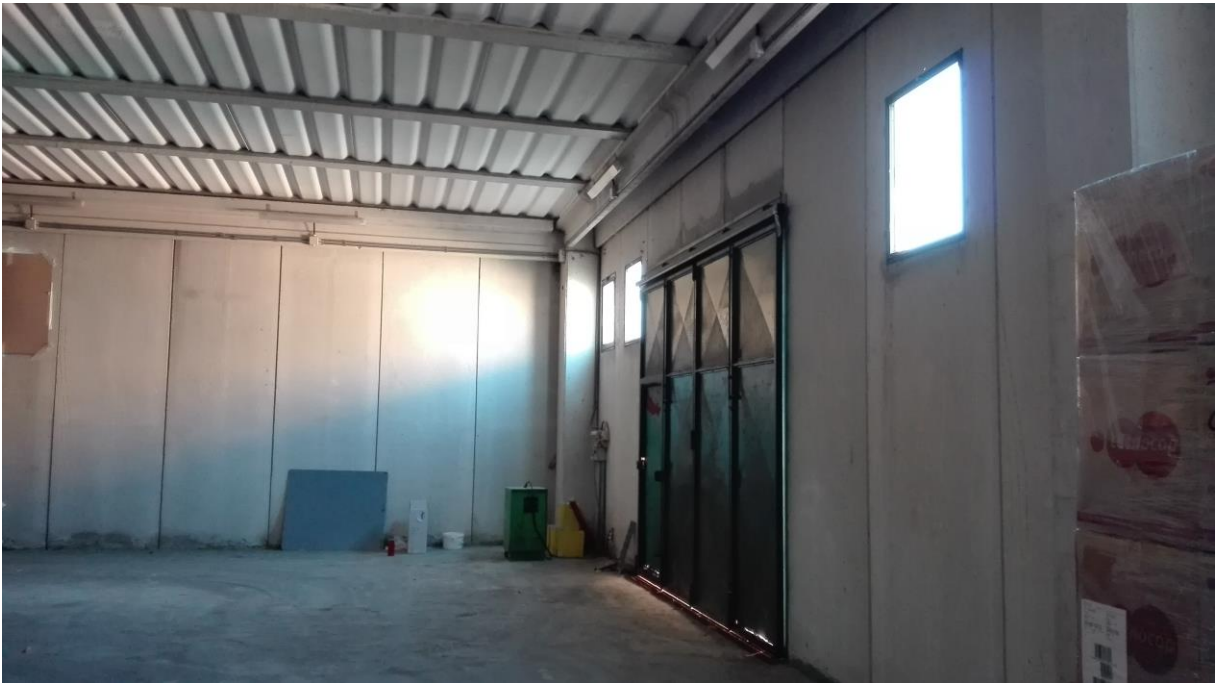
Foto 82-83. Interno del capannone.
