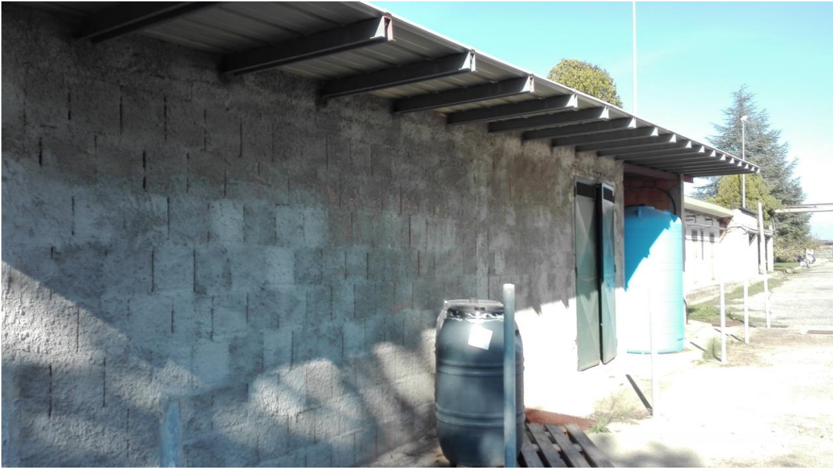
Foto 98. Facciata corpo B.
