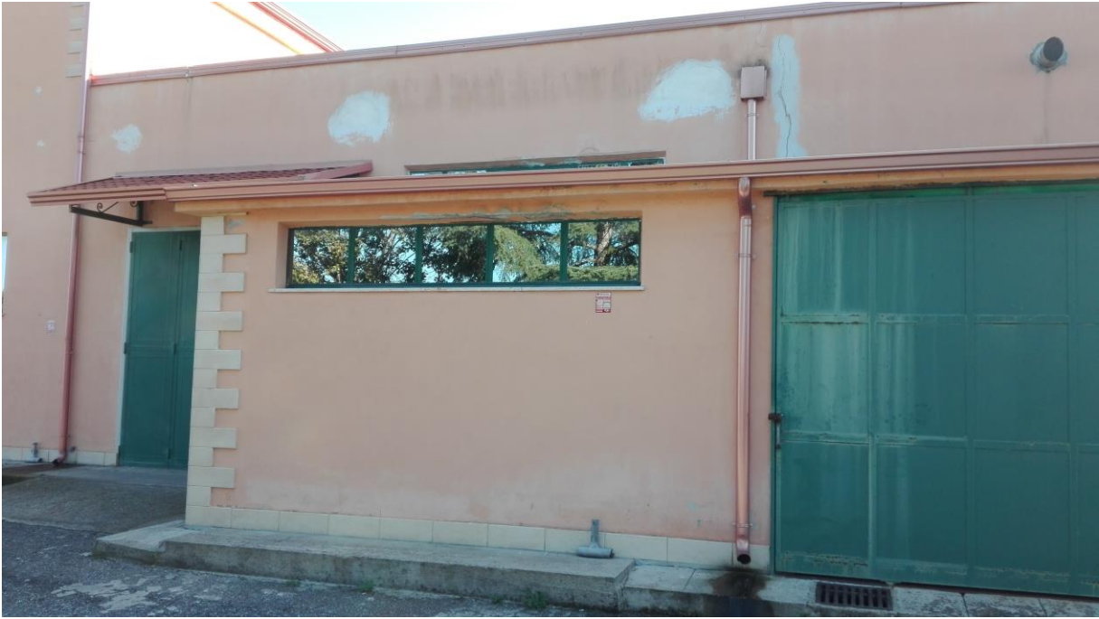
Foto 64. Corpo B lato ovest.
