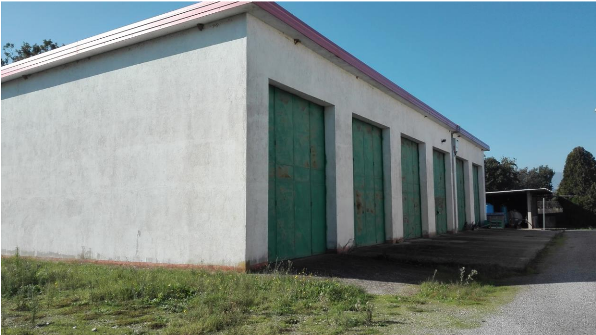
Foto 94. Il fabbricato lato nord est.
