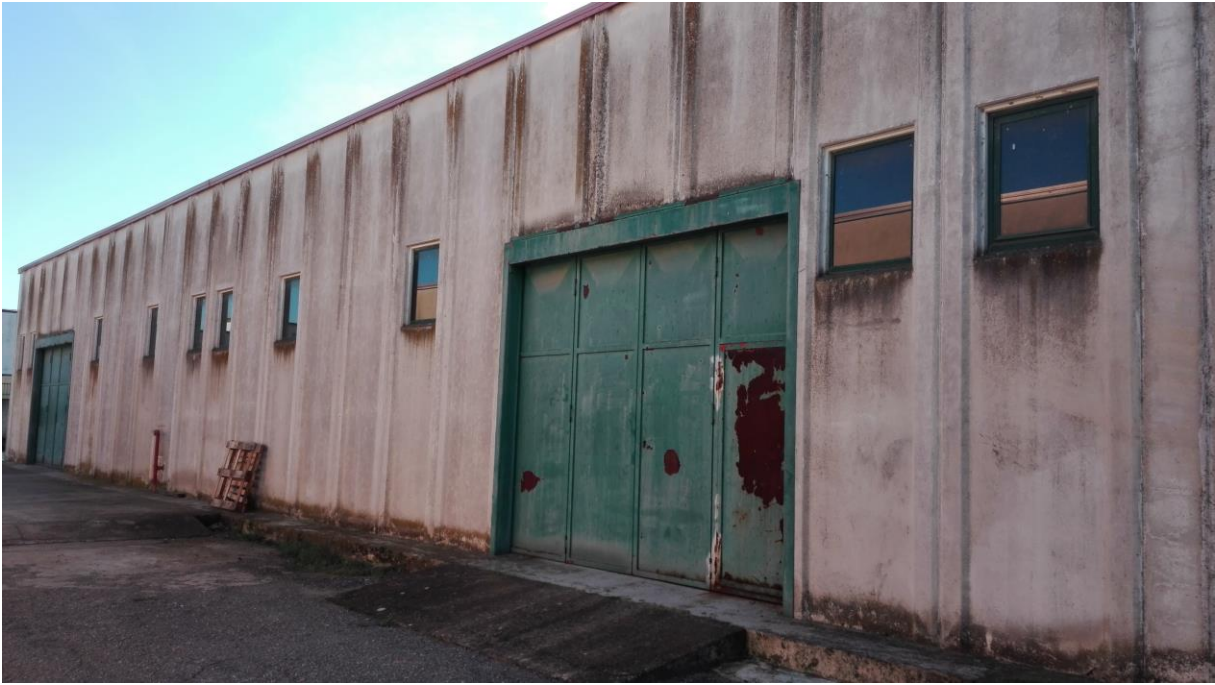
Foto 74. Porta d'ingresso scorrevole al capannone corpo A.
