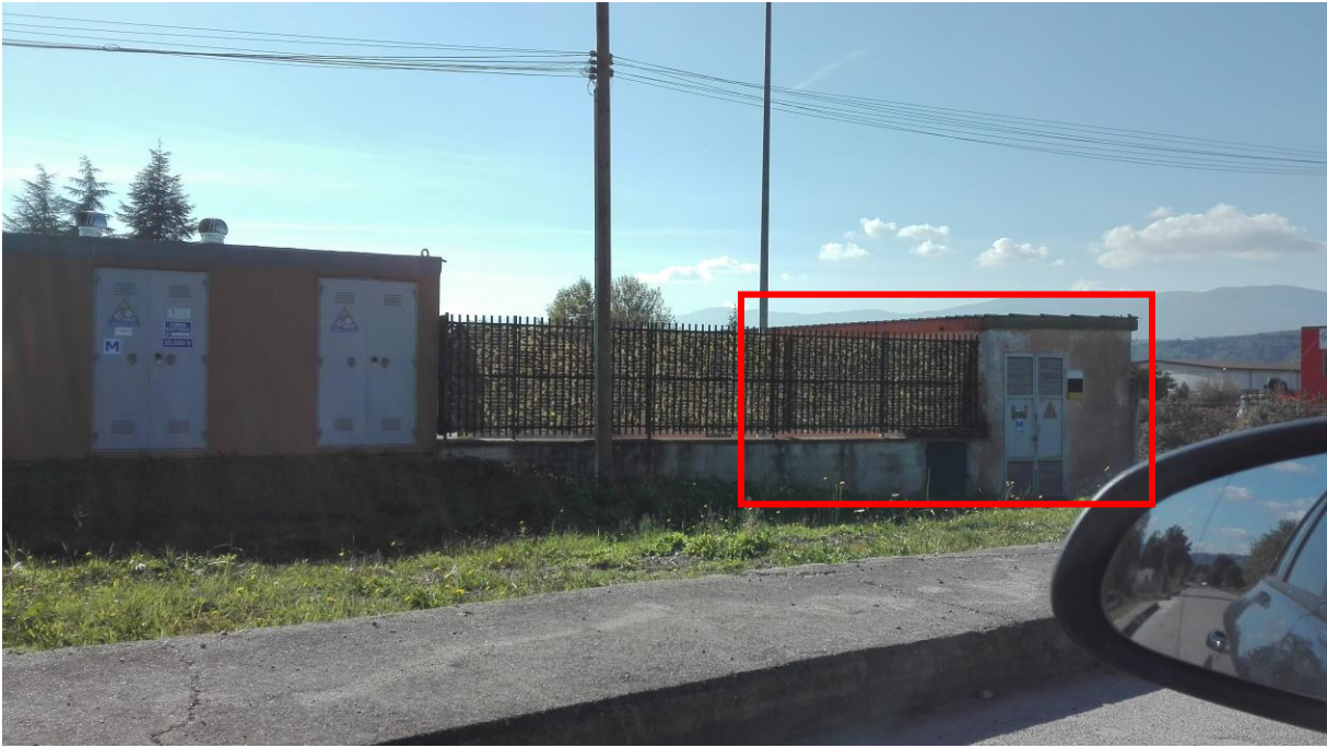
Foto 18. Particolare dell'ingresso dall'esterno del Corpo B in uso all'Enel lato nord.
