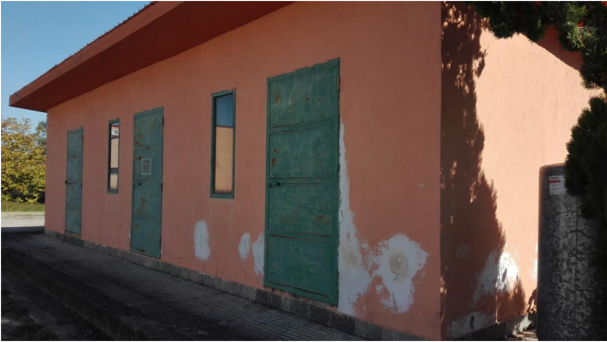
Foto 90. Facciata Corpo C.
