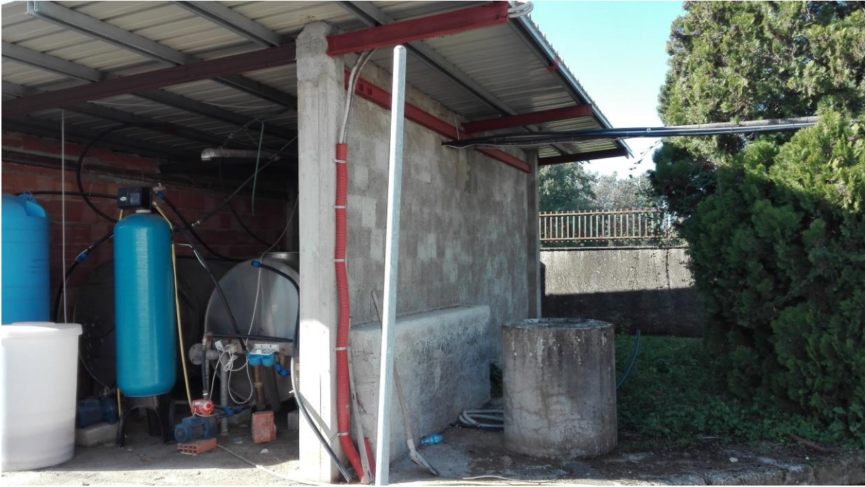
Foto 99. Particolare del fabbricato adibito a locale deposito caldaia.
