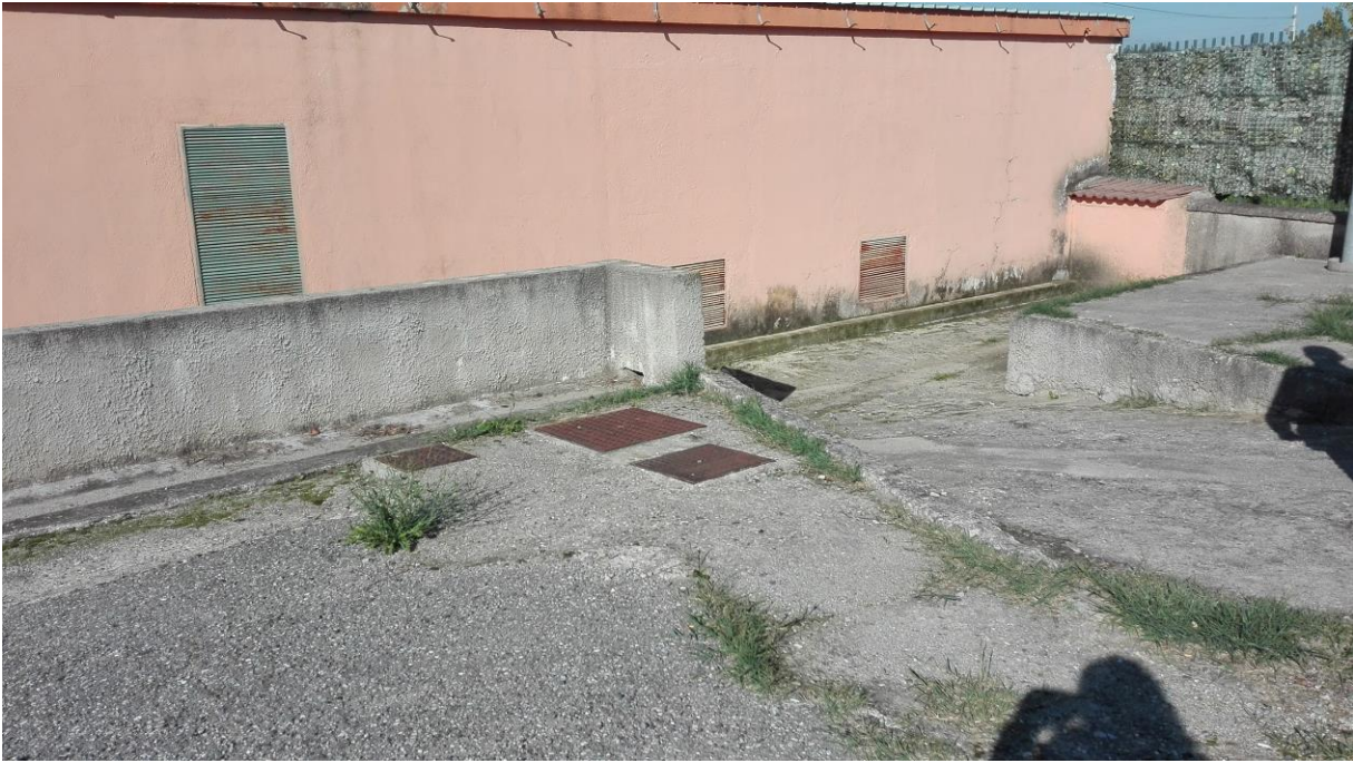
Foto 12-13. Facciata lato est immobile Corpo B
