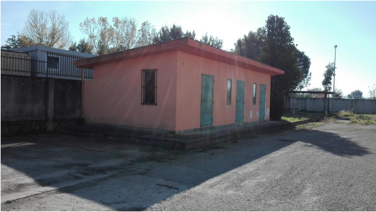
Foto 89. Fabbricato Corpo C.
