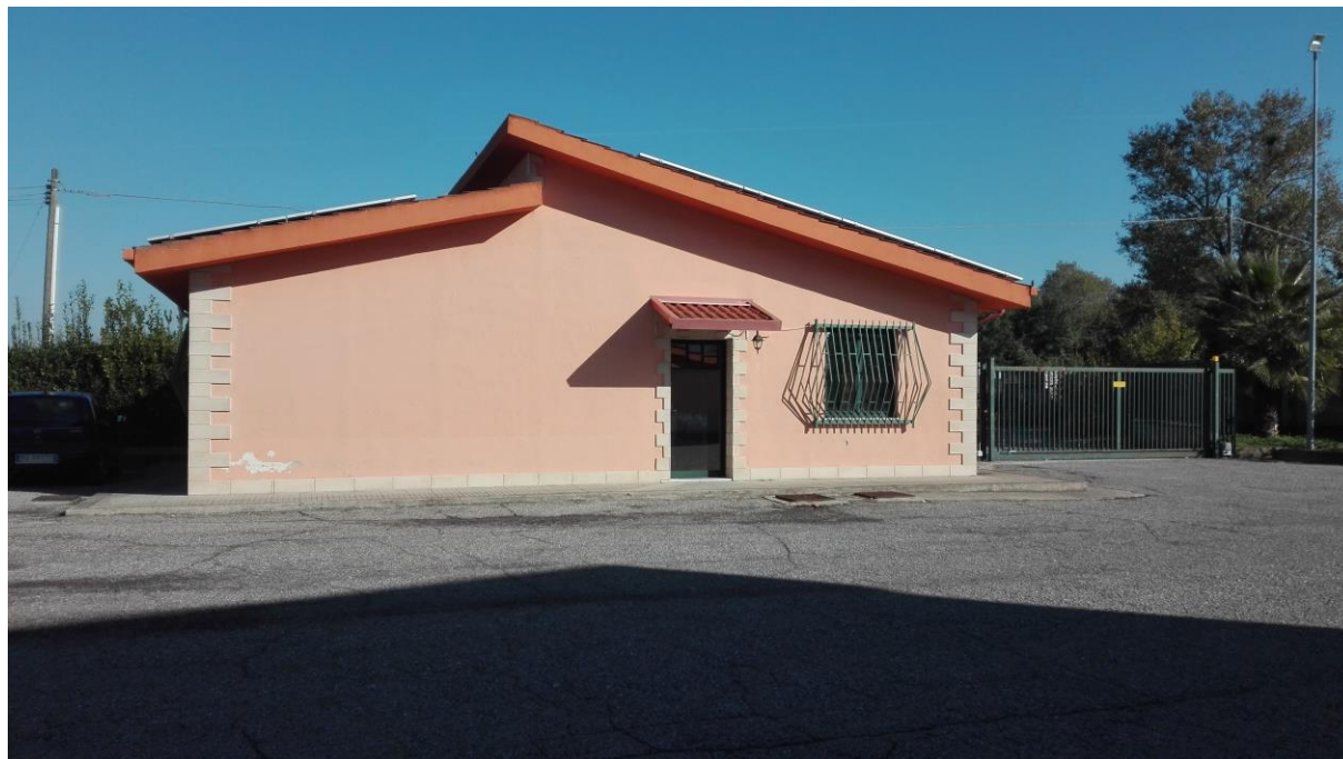
Foto 2. Prospetto frontale Unità immobiliare part. 62 sub 3 Corpo A
