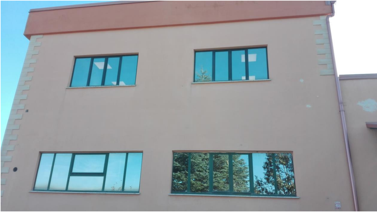
Foto 24. Particolare Lato ovest.
