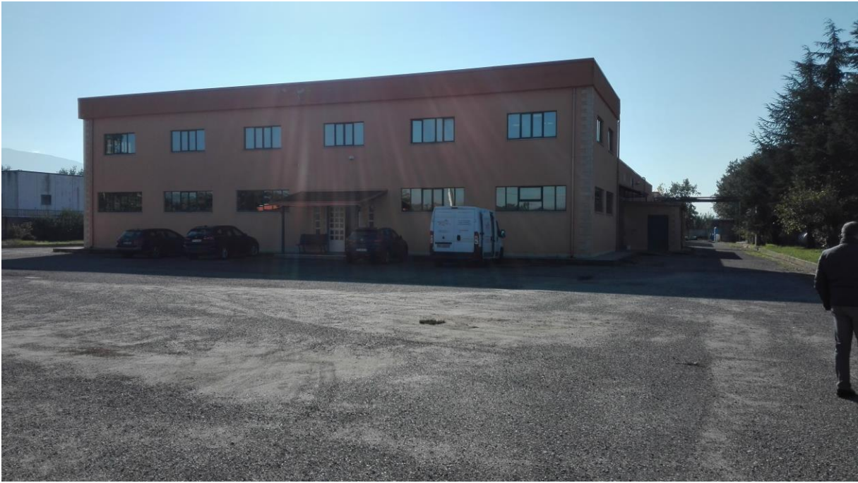
Foto 22. Prospetto lato nord.
