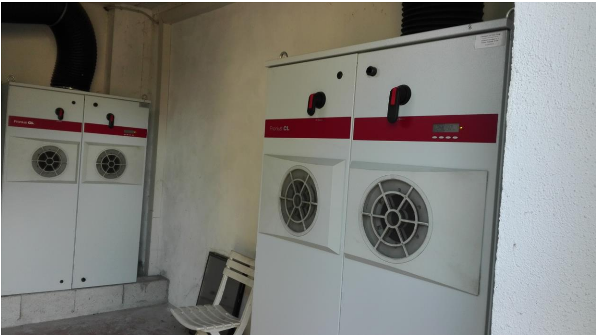
Foto 71-72-73. Locale deposito inverter dell'impianto tecnologico fotovoltaico.
