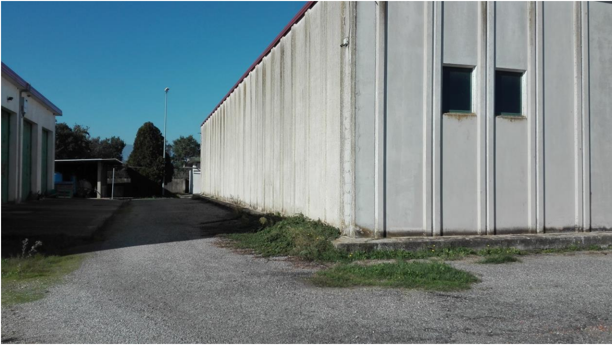
Foto 78. Facciata cieca lato sud.
