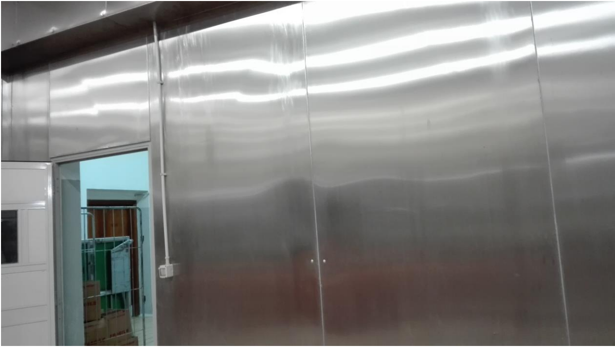
Foto 37-38. Stanza completamente rivestita con pannelli in acciaio.
