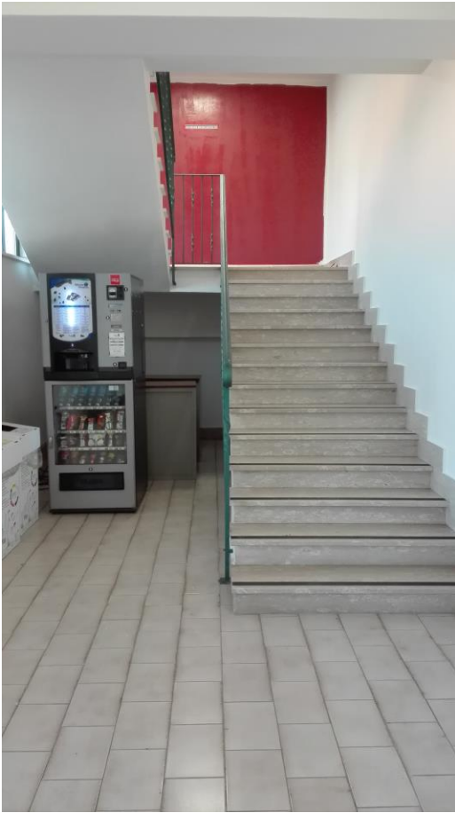
Foto 45. Androne d'ingresso Corpo A di accesso al piano terra e scale di accesso al primo piano.
