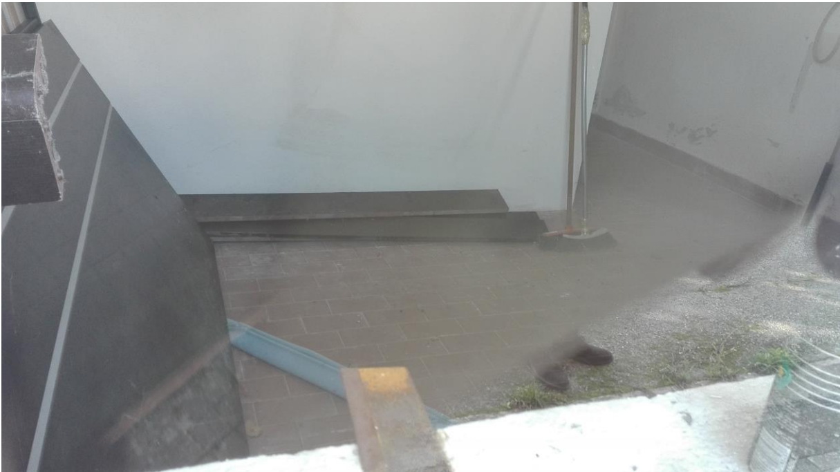
Foto 91-92. Interno del fabbricato.
