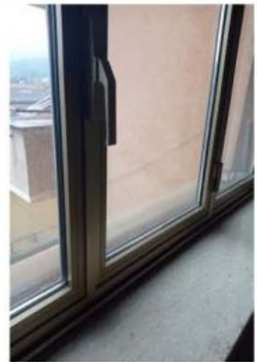
Foto n. 30: dettaglio degli infissi in alluminio.
