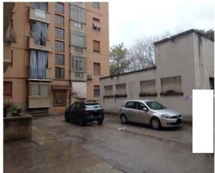
Foto n. 09-10: prospetto interno del fabbricato dal cortile.
