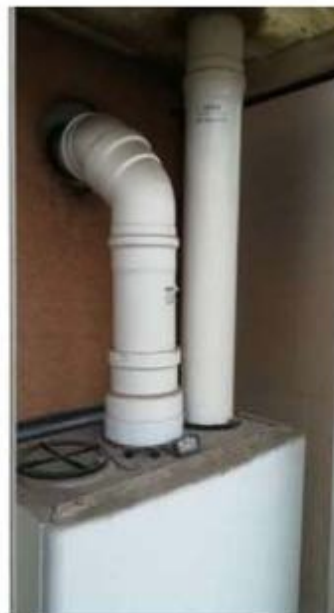
Foto n. 38-39: dettaglio della caldaia a gas posta dentro l'amadio esterno .
