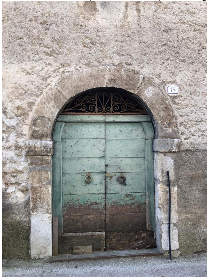
FOTO N°30: Vista esterna dell'U.I. al piano seminterrato, portone di ingresso al PS1.
