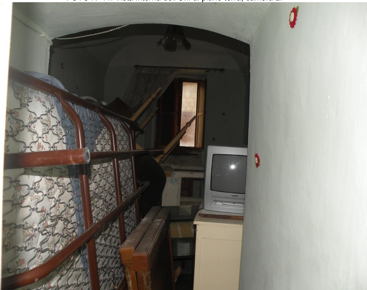
FOTO N°14: Vista interna dell'U.I. al piano terra, camera 2.
