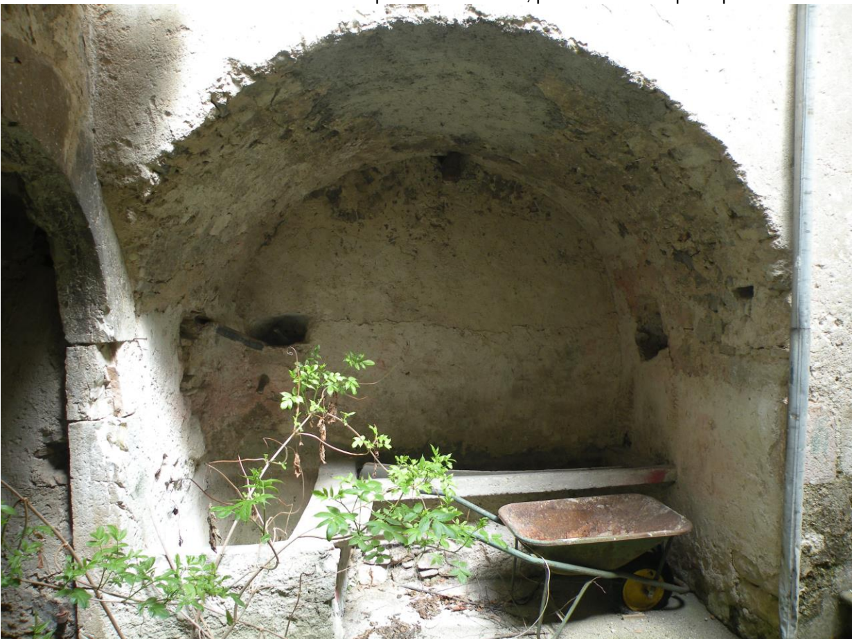
FOTO N°23: Vista esterna dell'U.I. al piano seminterrato, porzione corte coperta/portico.
