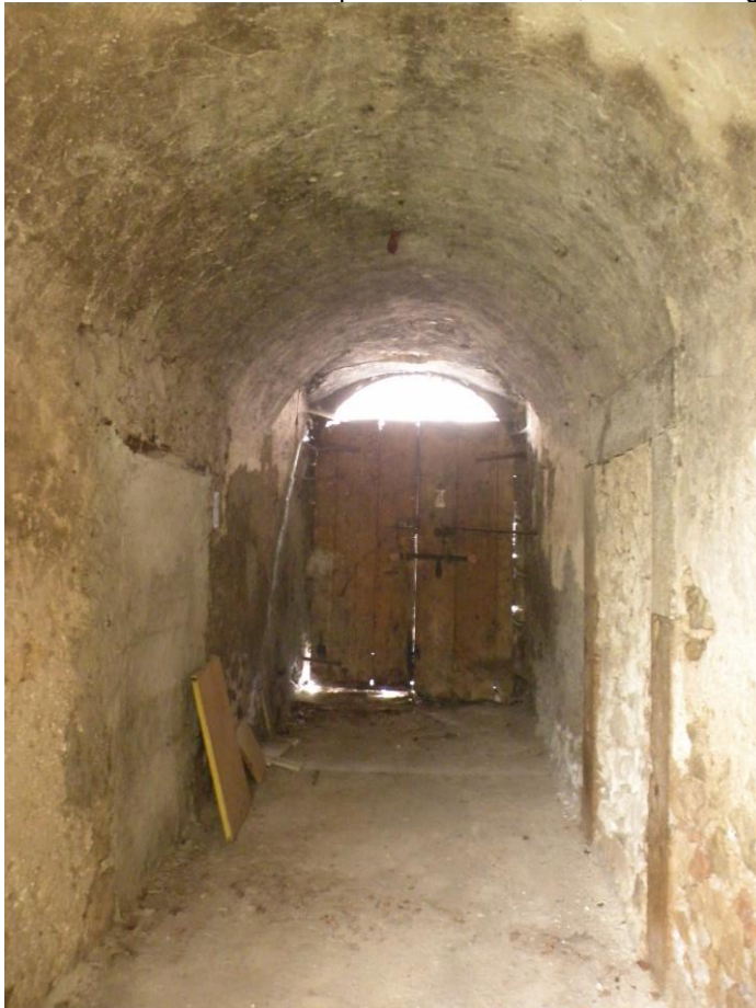
FOTO N°29: Vista interna dell'U.I. al piano seminterrato, androne / ingresso PS1.
