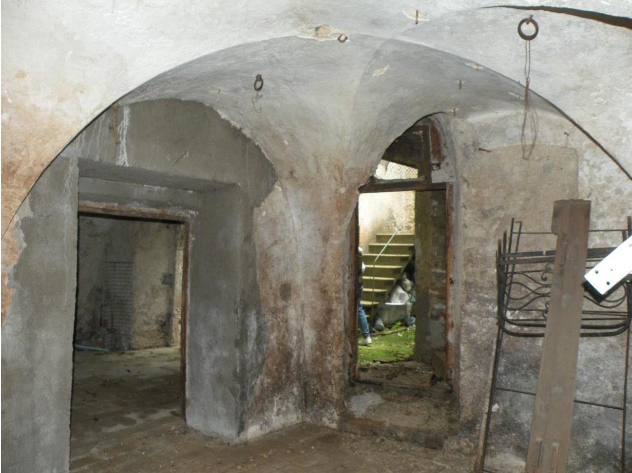
FOTO N°26: Vista interna dell'U.I. al piano seminterrato, cantina 1/1.
