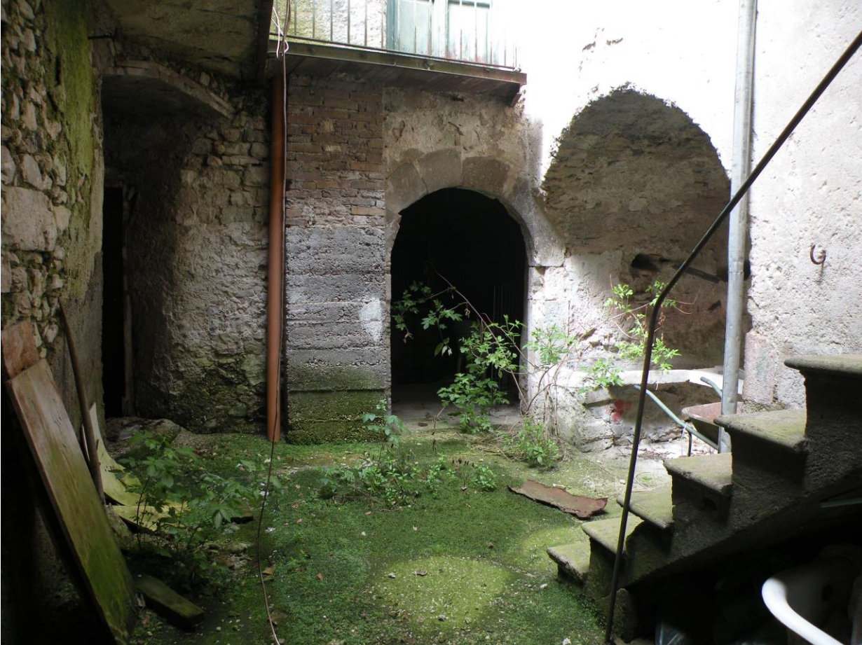
FOTO N°22: Vista esterna dell'U.I. al piano seminterrato, corte/3.
