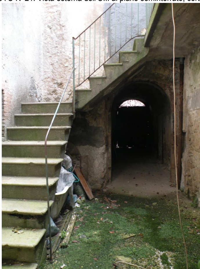
FOTO N°21: Vista esterna dell'U.I. al piano seminterrato, corte/2.
