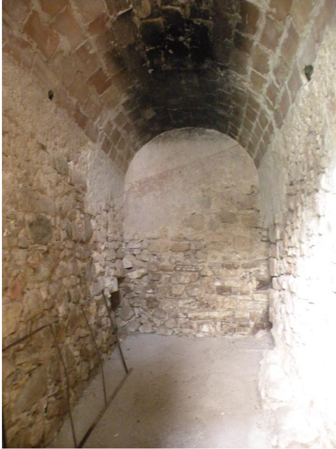
FOTO N°28: Vista interna dell'U.I. al piano seminterrato, cantina 2.
