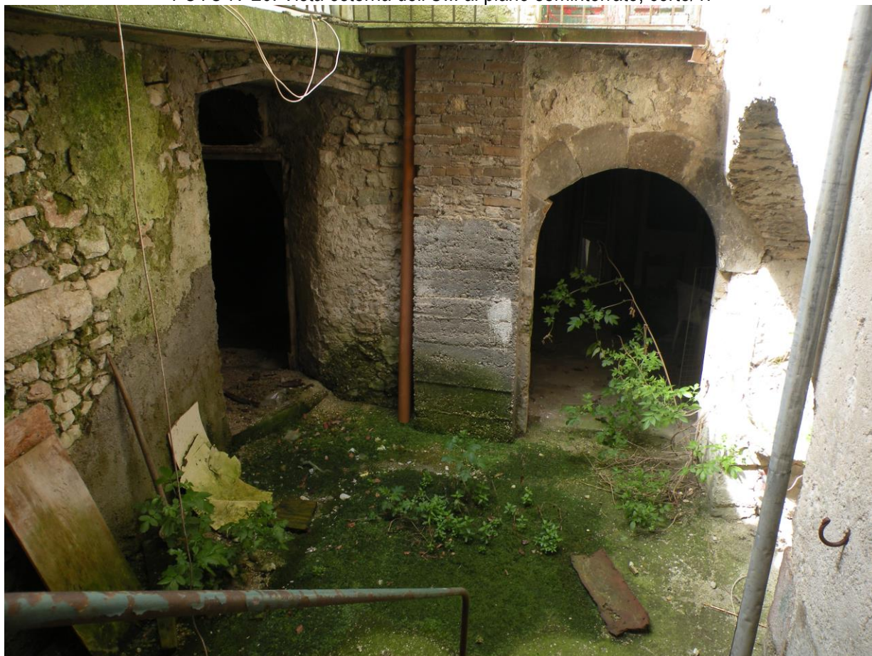
FOTO N°20: Vista esterna dell'U.I. al piano seminterrato, corte/1.
