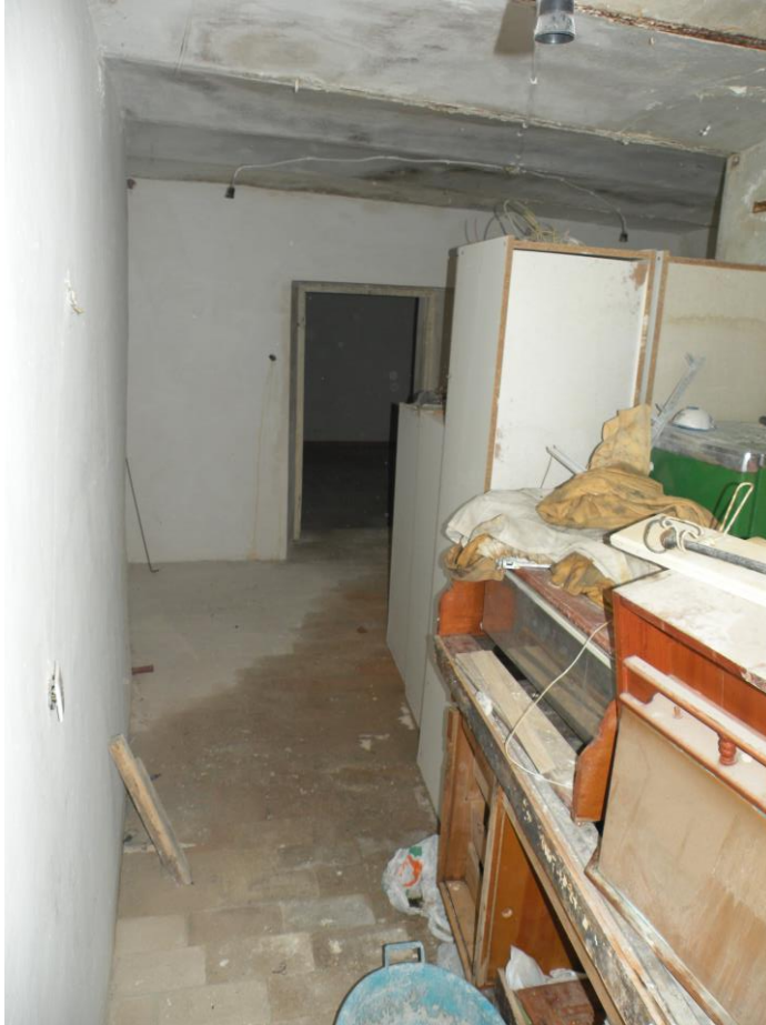
FOTO N°13: Vista interna dell'U.I. al piano terra, disimpegno/3.
