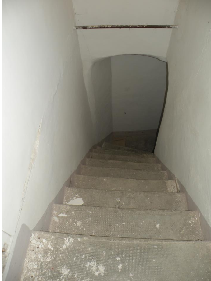
FOTO N°17: Vista interna dell'U.I. al piano primo, scala di accesso al P1.
