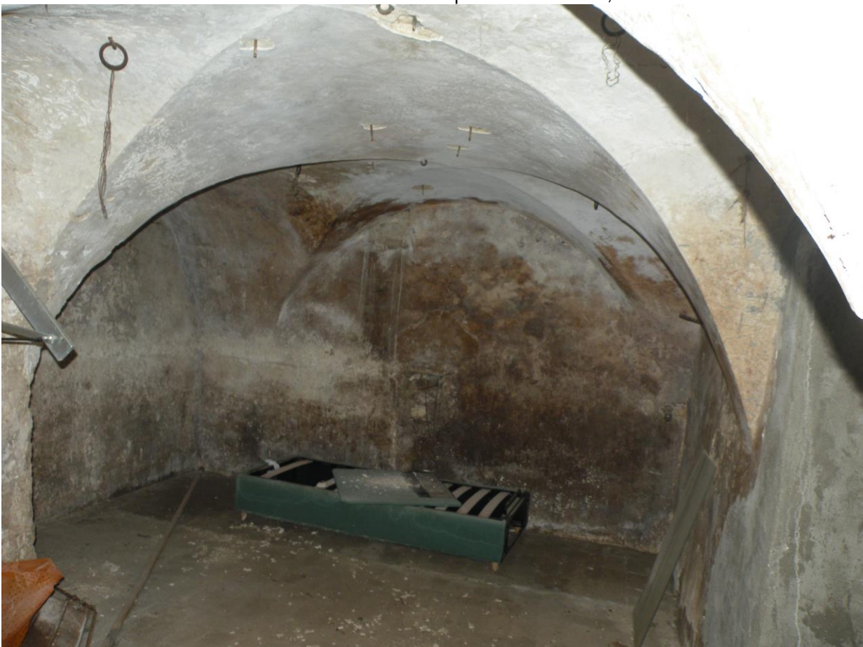
FOTO N°27: Vista interna dell'U.I. al piano seminterrato, cantina 1/2.
