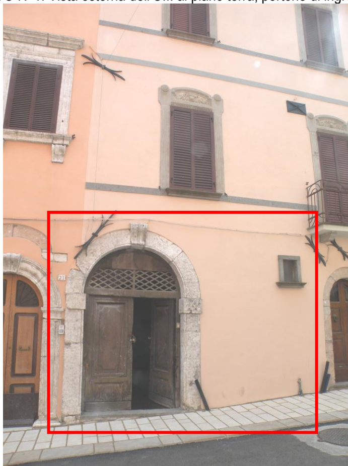
FOTO N°1: Vista esterna dell'U.I. al piano terra, portone di ingresso.
