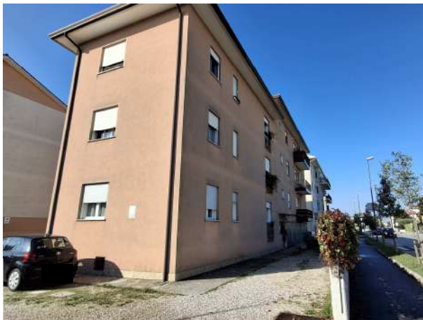
Foto 01 – accesso al compendio
