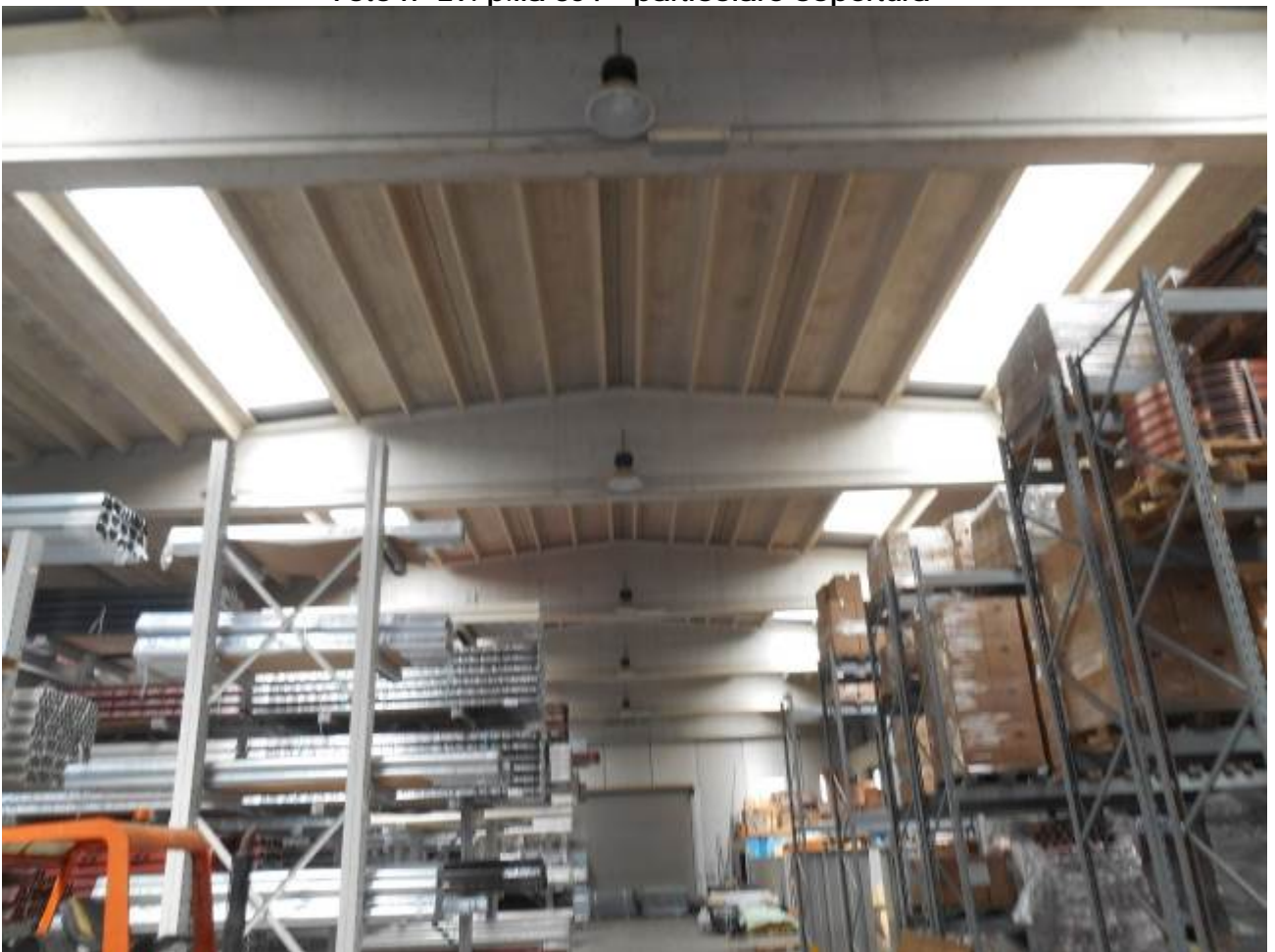
Foto n° 30: p.IIa 854 – particolare copertura
