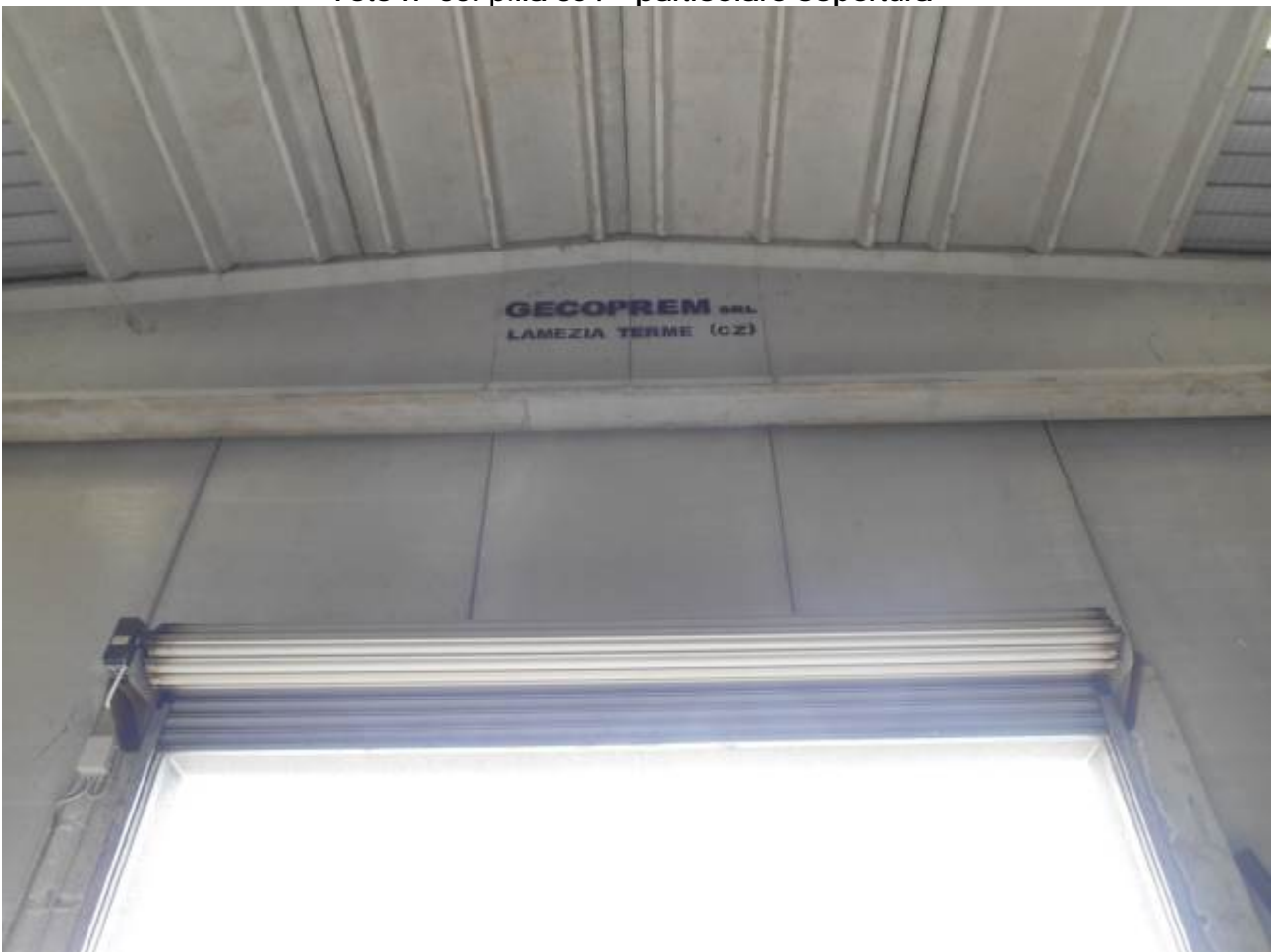
Foto n° 34: p.lla 854 – particolare copertura
