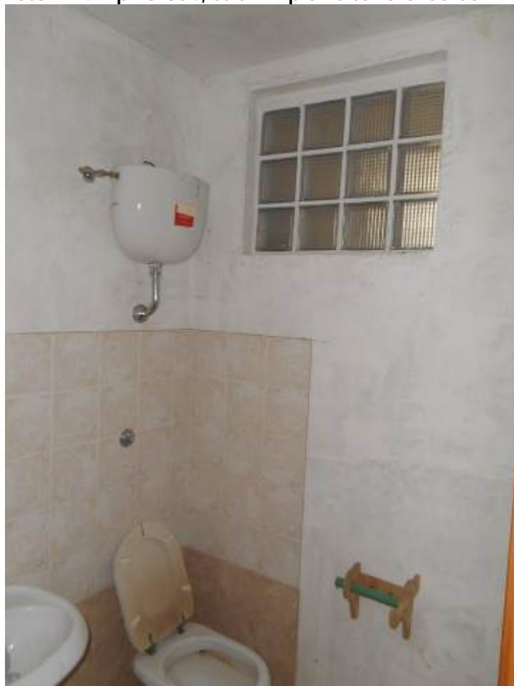
Foto n° 42: p.lla 854, sub 1 – piano terra area servizi
