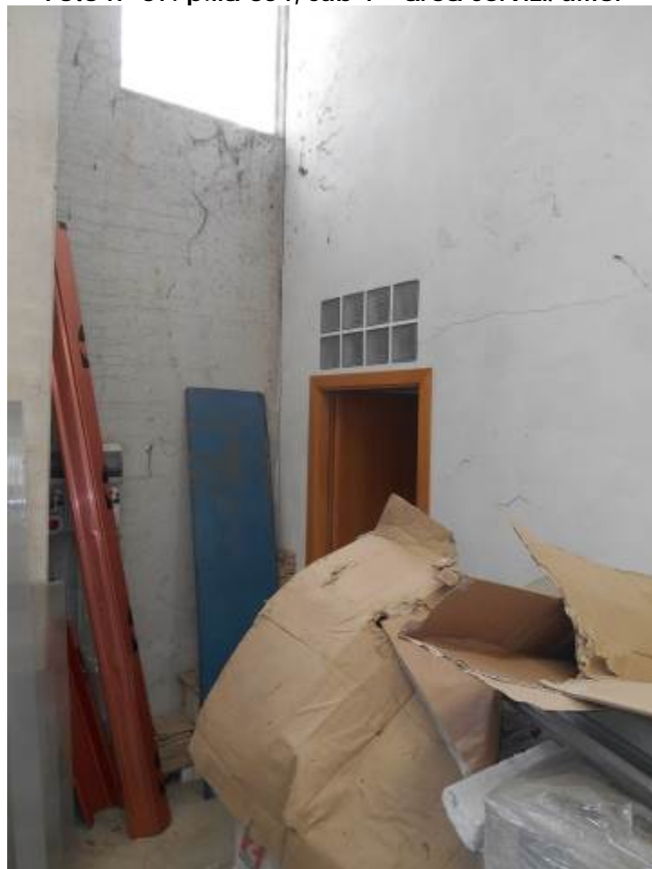
Foto n° 38: p.lla 854, sub 1 – piano terra area servizi
