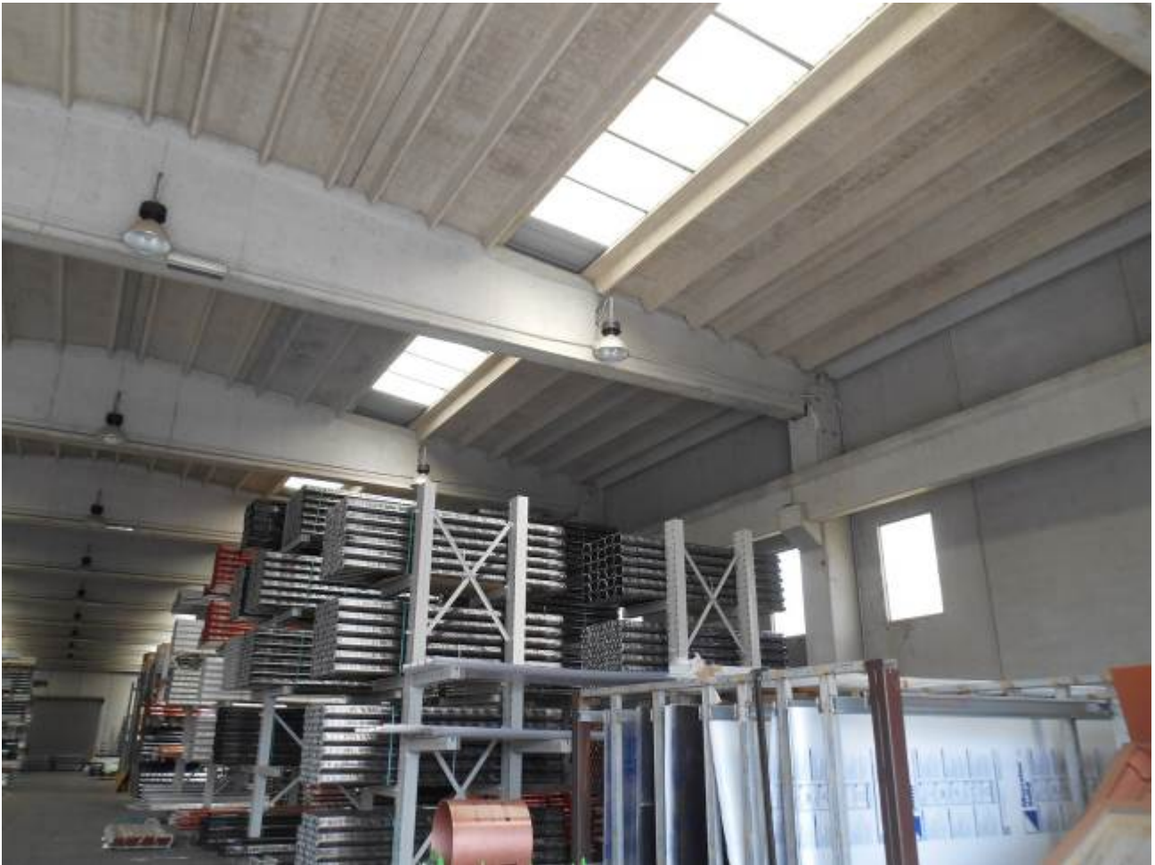
Foto n° 35: p.lla 854 – particolare copertura
