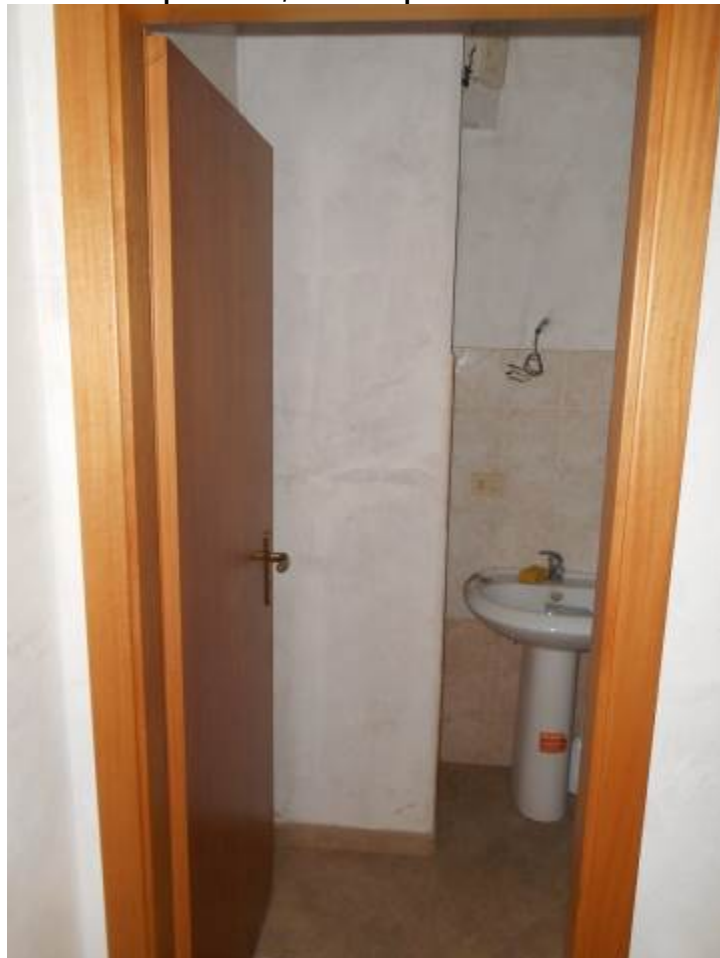
Foto n° 40: p.lla 854, sub 1 – piano terra area servizi
