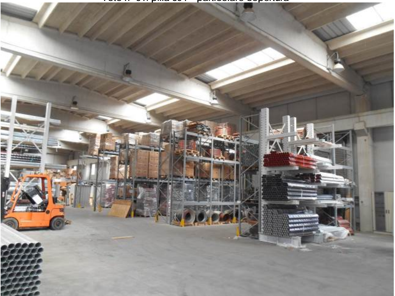
Foto n° 32: p.lla 854 – particolare copertura
