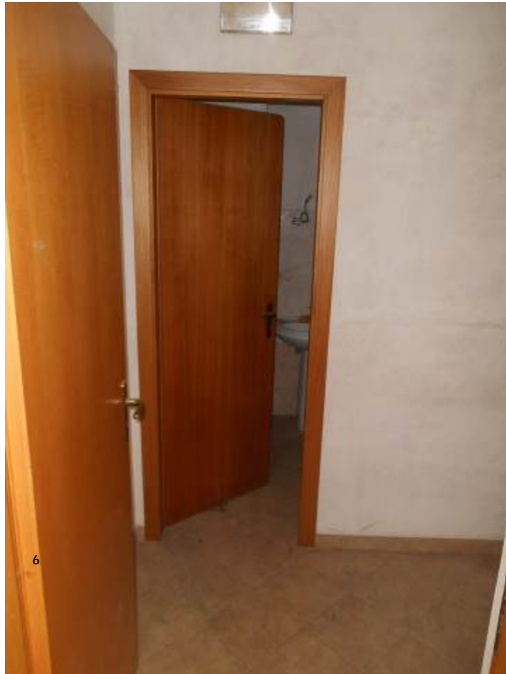
Foto n° 39: p.lla 854, sub 1 – piano terra area servizi
