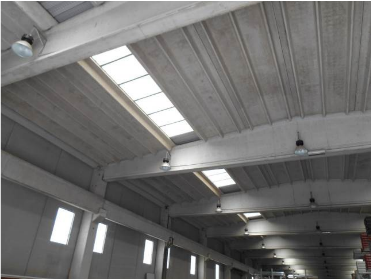
Foto n° 33: p.lla 854 – particolare copertura
