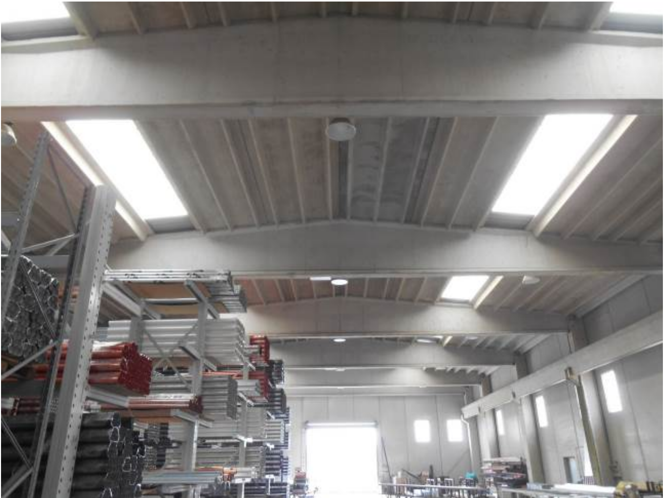
Foto n° 29: p.IIa 854 – particolare copertura
