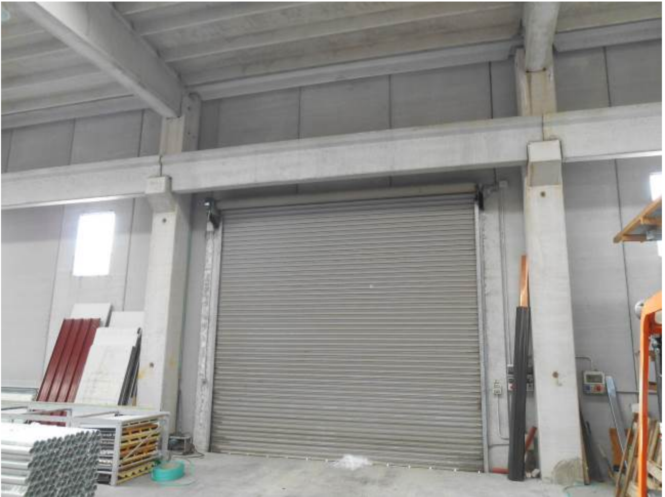
Foto n° 25: p.lla 854 dir. Capannone p.lla 858
