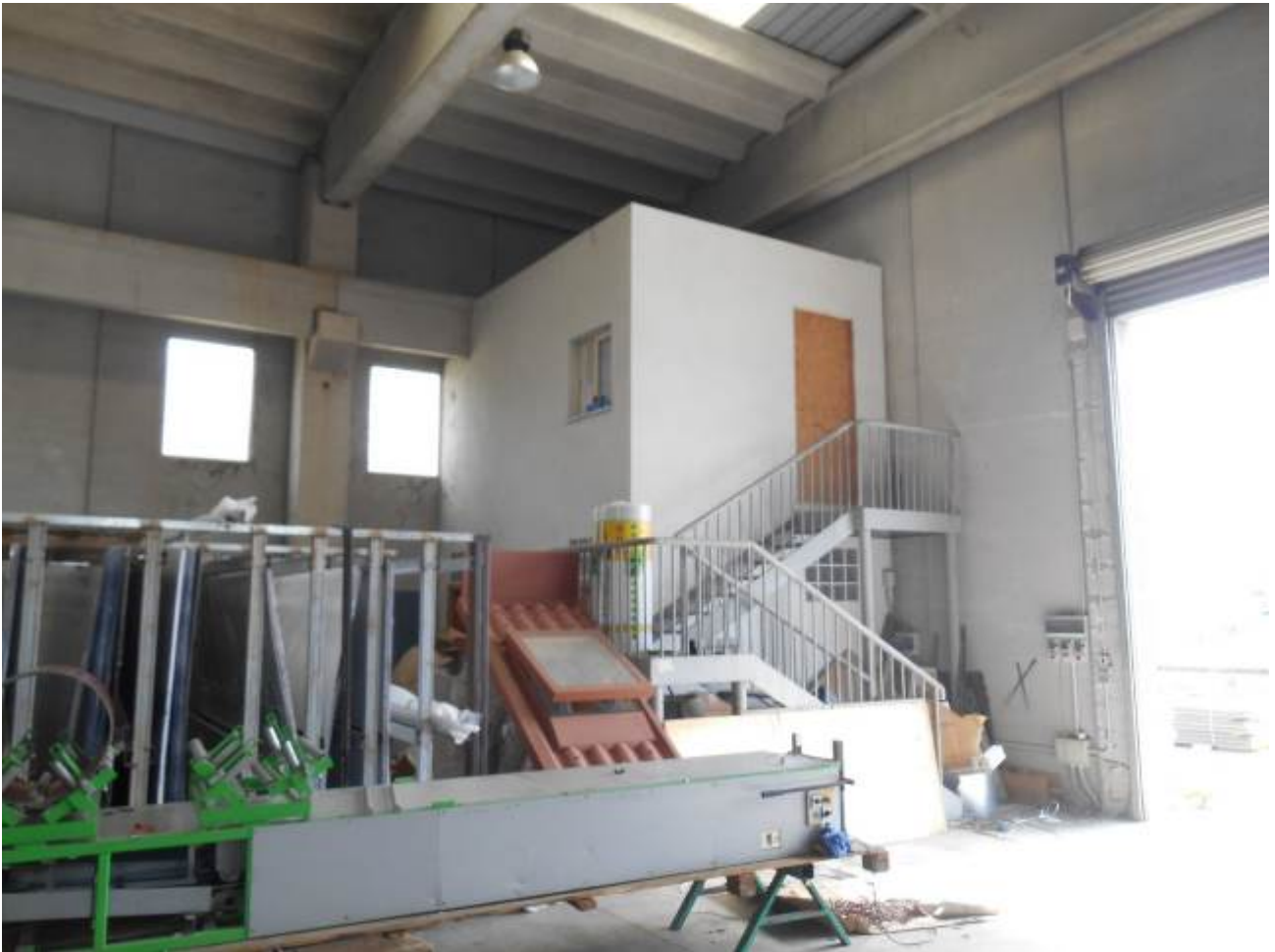
Foto n° 37: p.lla 854, sub 1 – area servizi/uffici
