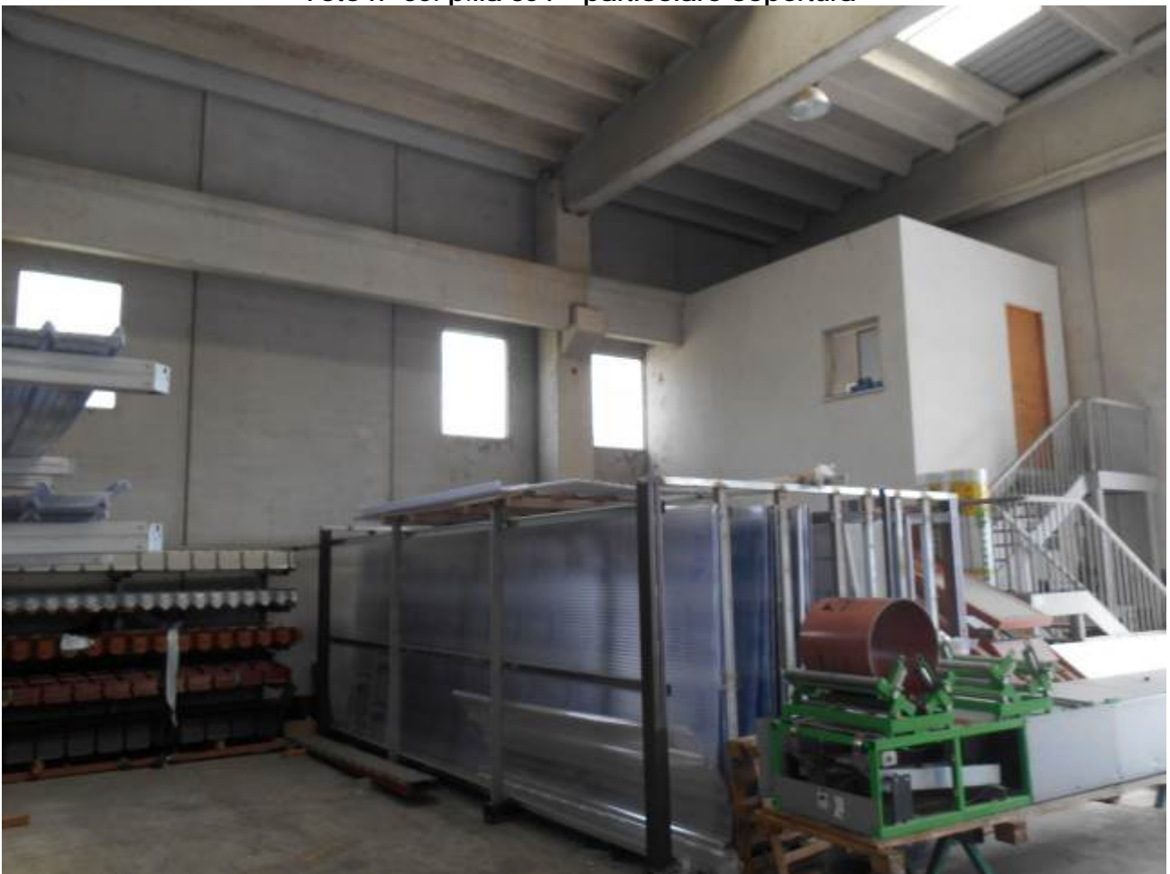
Foto n° 36: p.lla 854, sub 1 – area servizi/uffici
