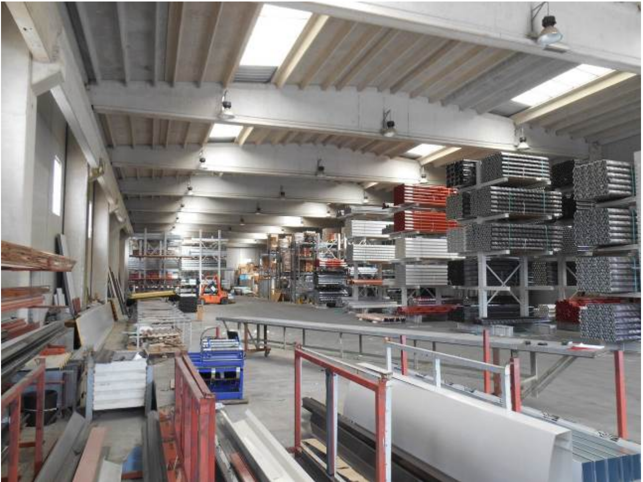
Foto n° 31: p.lla 854 – particolare copertura
