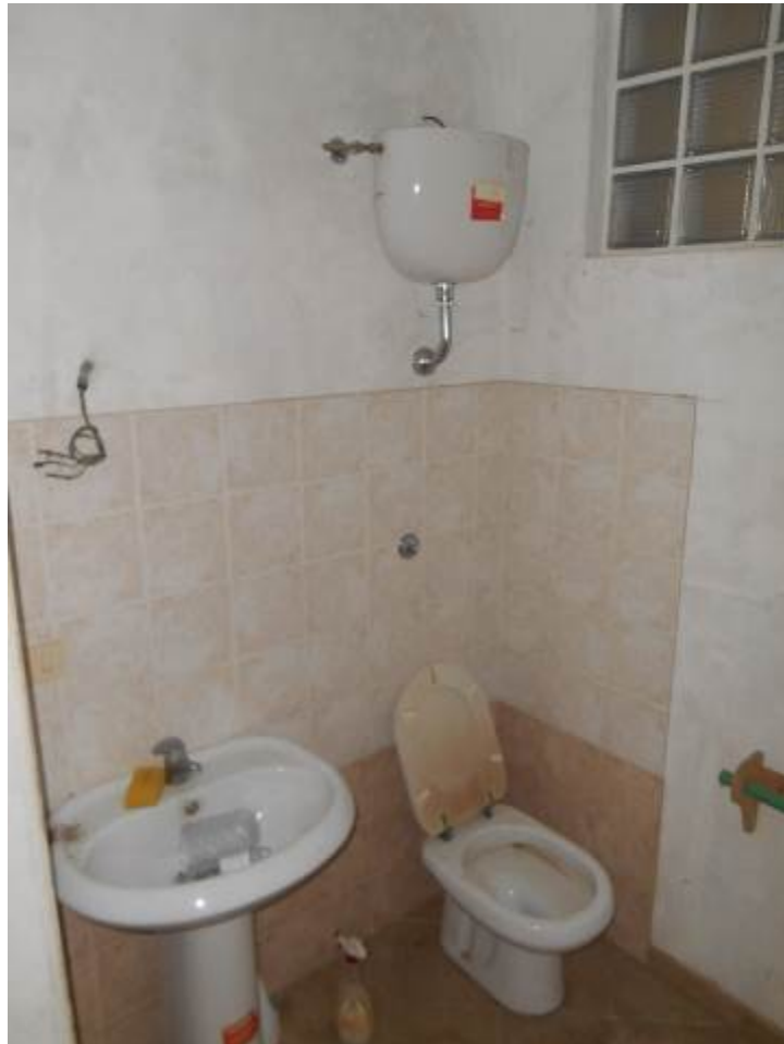
Foto n° 41: p.lla 854, sub 1 – piano terra area servizi
