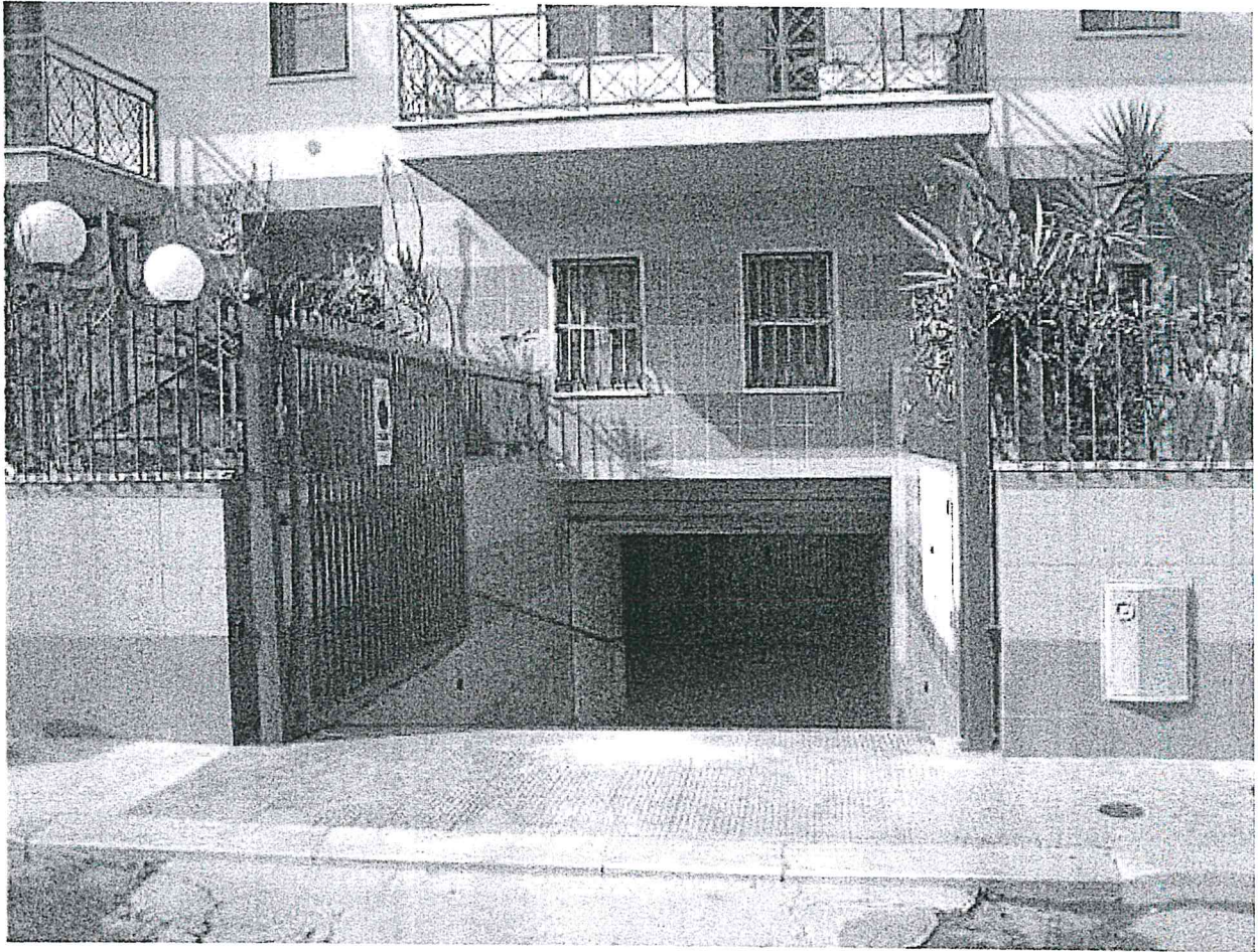
45 – Rampa di accesso ai box, dall'esterno.
