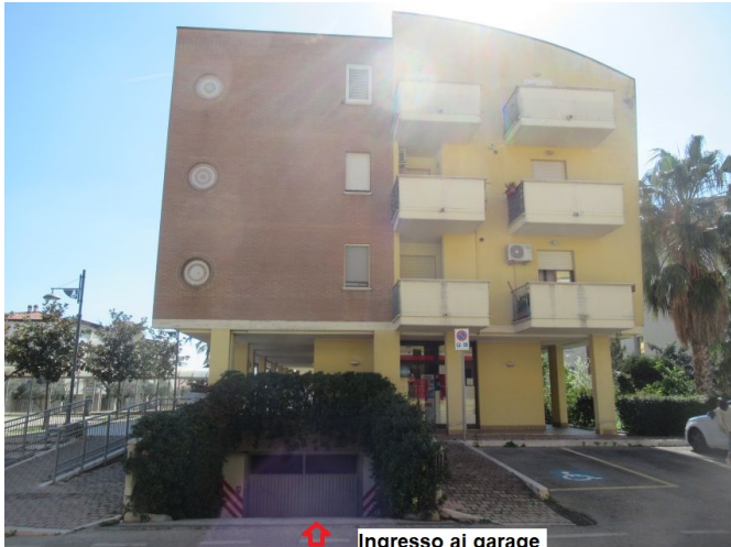
Foto 1 – Esterno fabbricato – ingresso ai garage
