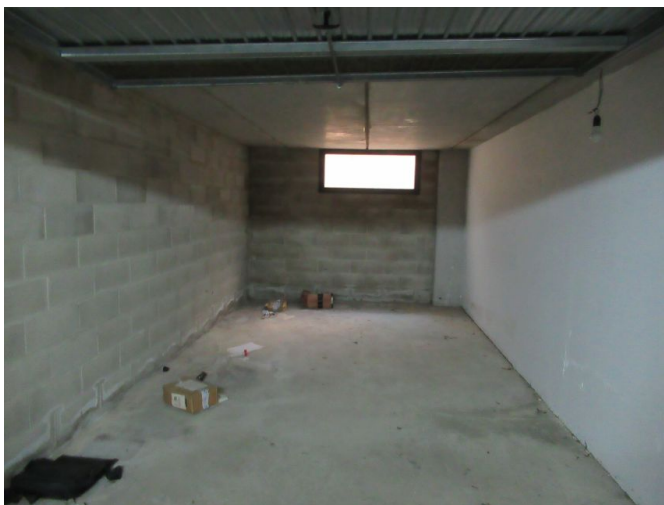
Foto 3 – Interno garage Sub. 19
