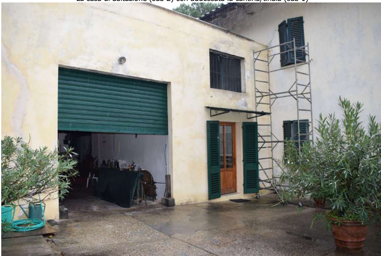
Foto n. 9_ Sopralluogo del 09/12/2019 A sinistra l'ingresso alla cantina/tinaia (sub 1) e a seguire la portafinestra dell'ufficio anch'esso accatastato sub 1
