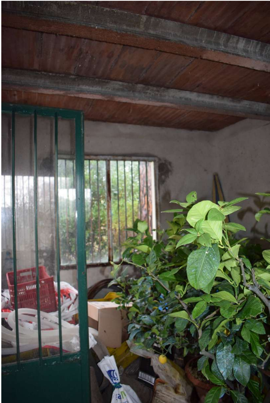
Foto n. 34_ Sopralluogo del 09/12/2019 Deposito part.lla 197
