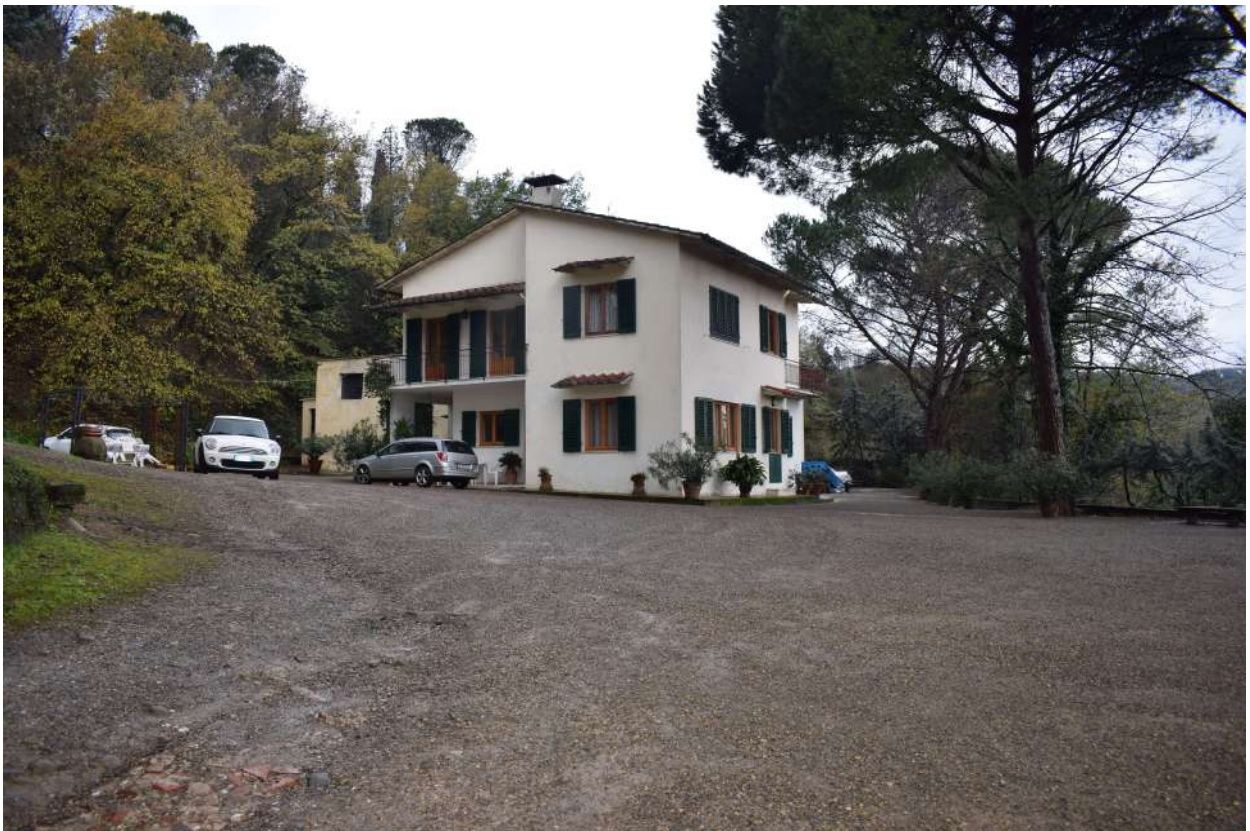
Foto n. 2_ Sopralluogo del 09/12/2019 Gli immobili oggetto di pignoramento e l'ampio piazzale antistante (sub 1) visti dalla stradella di accesso di cui alla foto precedente
