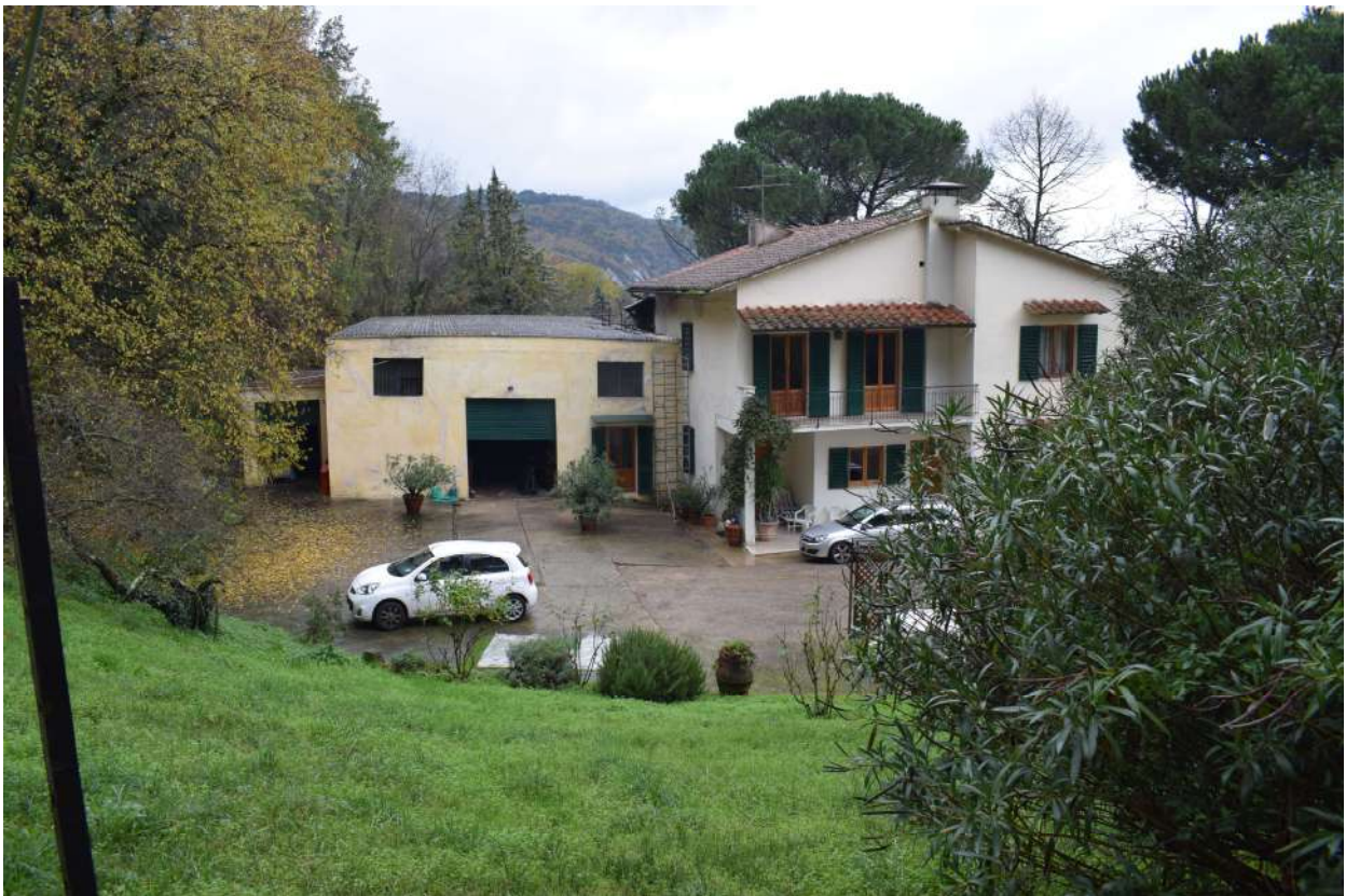
Foto n. 36_Sopralluogo del 09/12/2019 Dalla strada di accesso di cui alla foto precedente vista generale sugli immobili oggetto di perizia (a sx cantina sub 1 e a dx abitazione sub 2)
