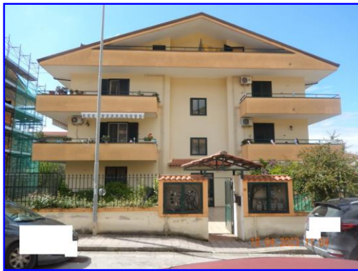
Immagine 1 – Prospetto fronte strada
