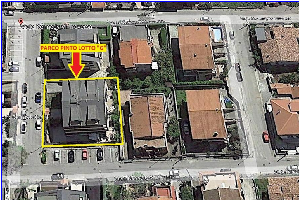
Complesso edilizio - Condominio Parco Pinto Lotto G - Vitulazio (CE) Viale Kennedy VI Trav. 21/B
