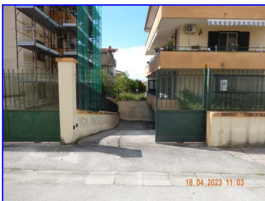
Immagine 3 – Ingresso carraio
