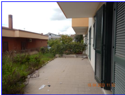
Immagine 7 – Corte esclusiva lato Sud
