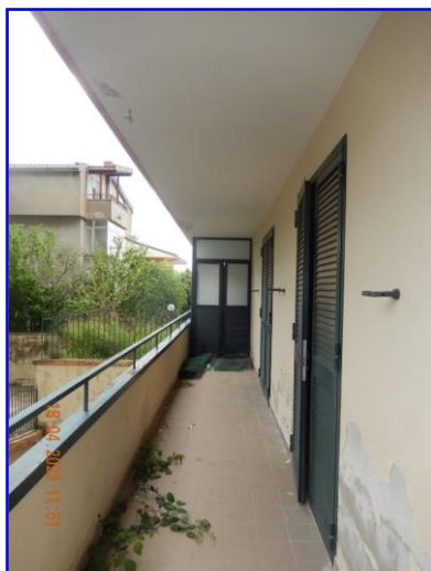
Immagine 9 – Balcone lato Est
