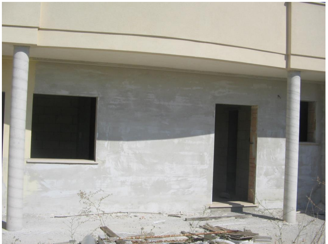
Facciata principale – piano terra
