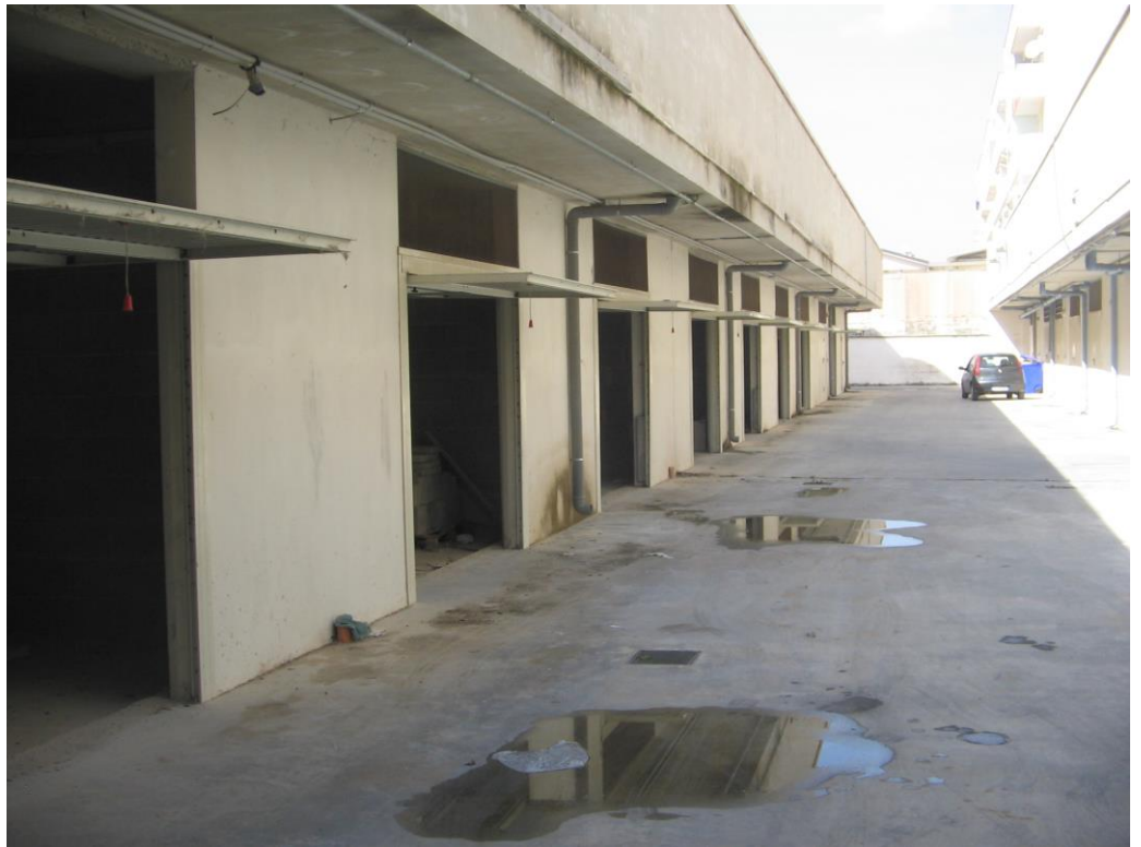
Corsia di manovra piano interrato 1
