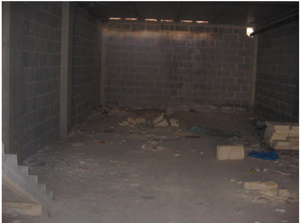
Cantina piano interrato 1
