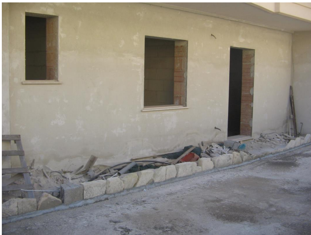
Scoperto retrostante piano terra
