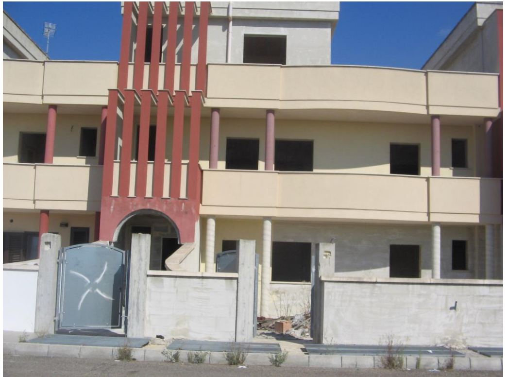
Prospetto ed ingresso dell'abitazione al piano terra
