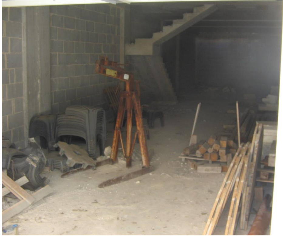
Box (sub. 46) con accesso da corsia di manovra indiviso da cantina
