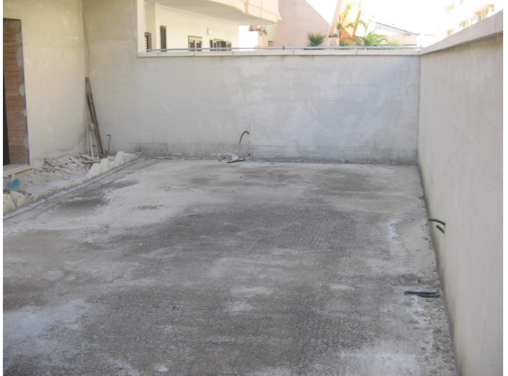
Scoperto retrostante piano terra
