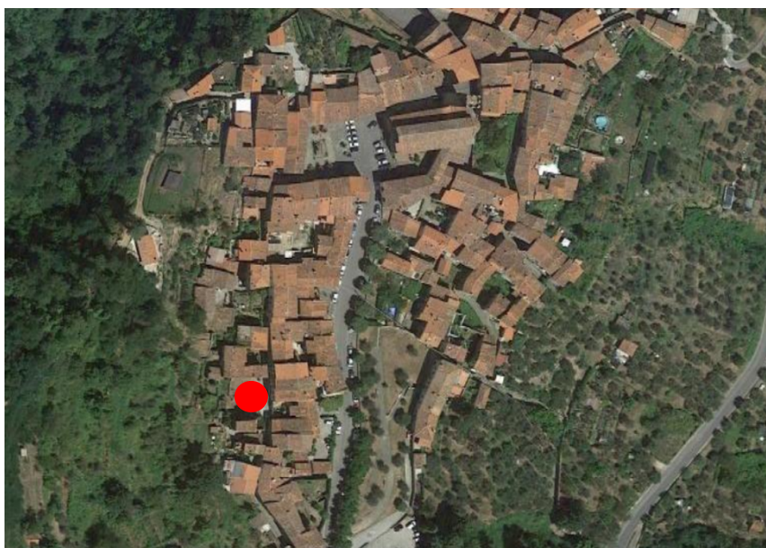
Fig. 4 – Localizzazione del fabbricato diruto
