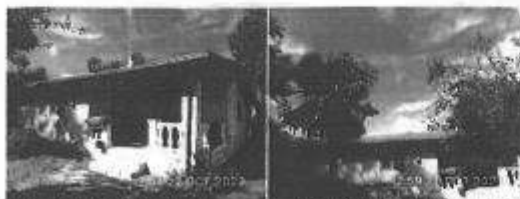
Foto 7 - Edificio "B" prospetto sud
