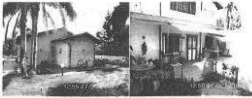
Foto 3 - Edificio "A" prospetto ovest
