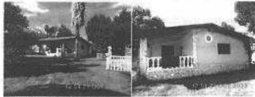
Foto 5 - Edificio "B" prospetto sud-est
