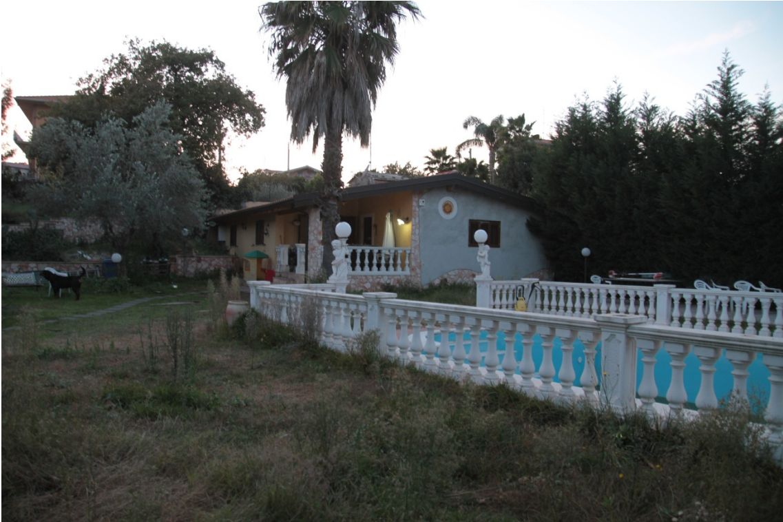
foto 16 vista d'insieme dei due manufatti abusivi
