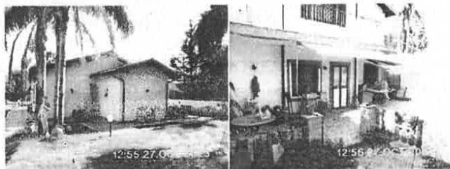
Foto 3 - Edificio "A" prospetto ovest
