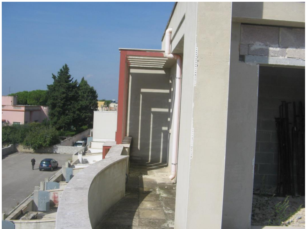
Vano tecnico piano secondo
