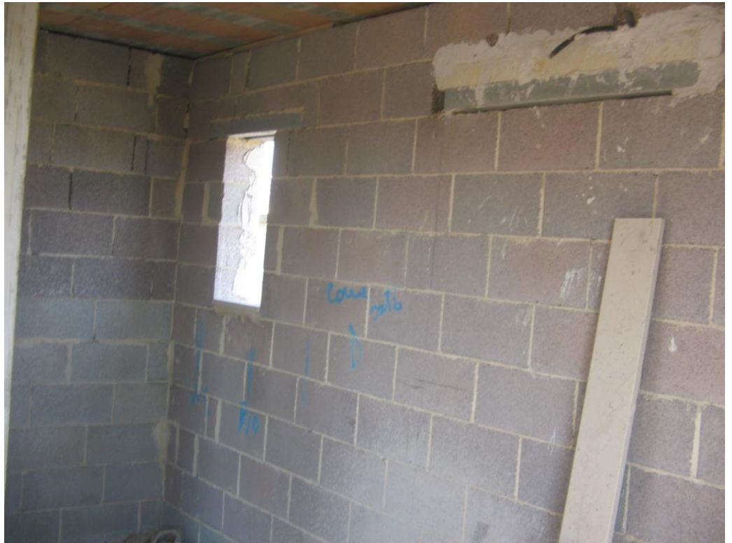
Vano tecnico piano secondo
