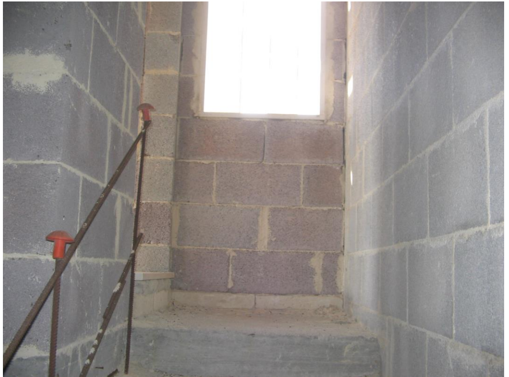
scala interna al piano secondo
