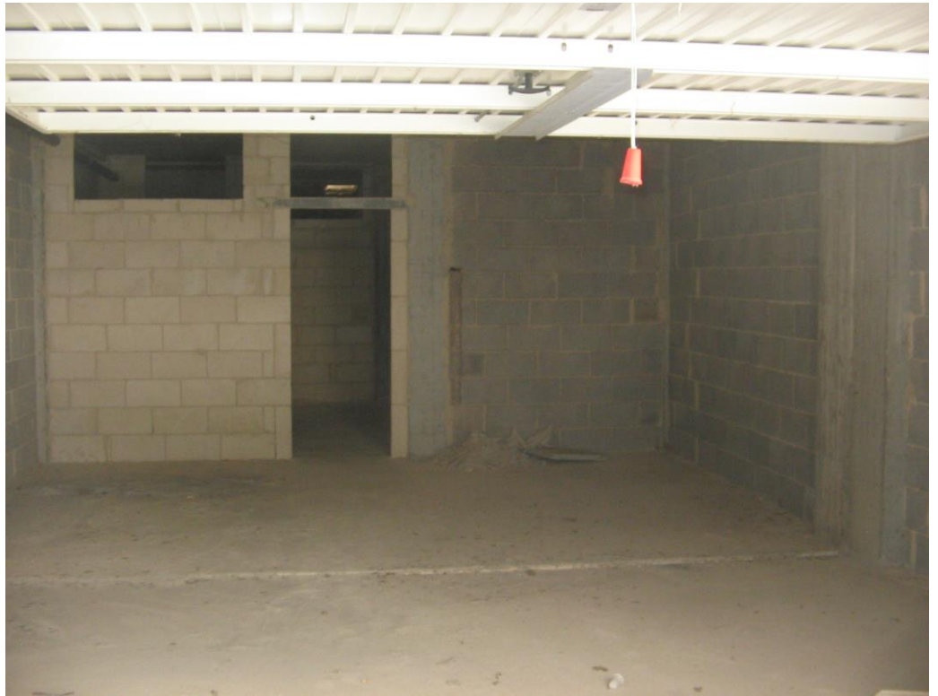
Box (sub. 41) indiviso con cantina piano interrato 1
