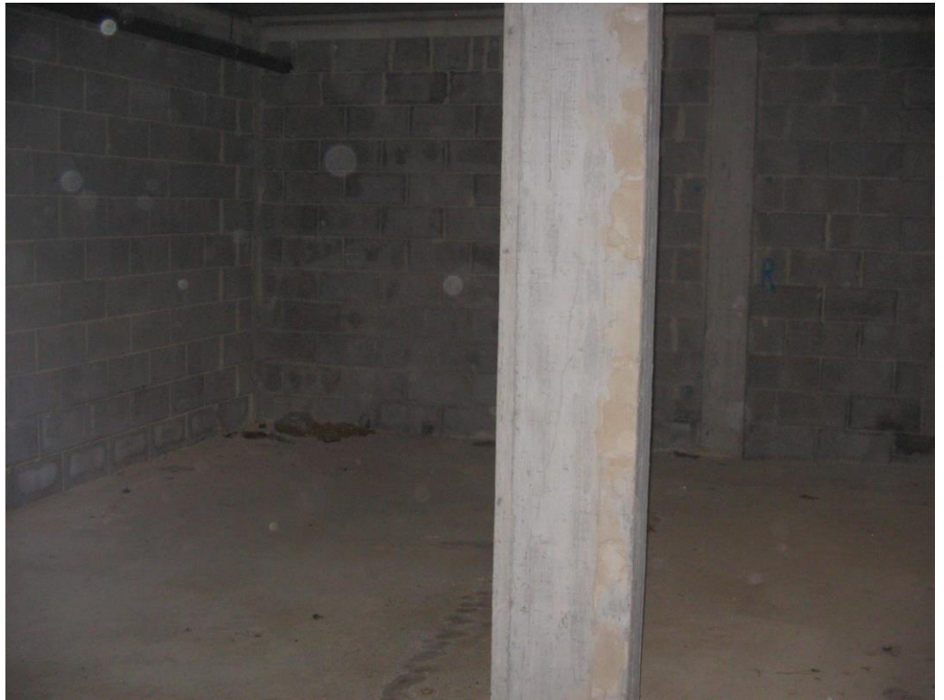
cantina piano interrato 1
