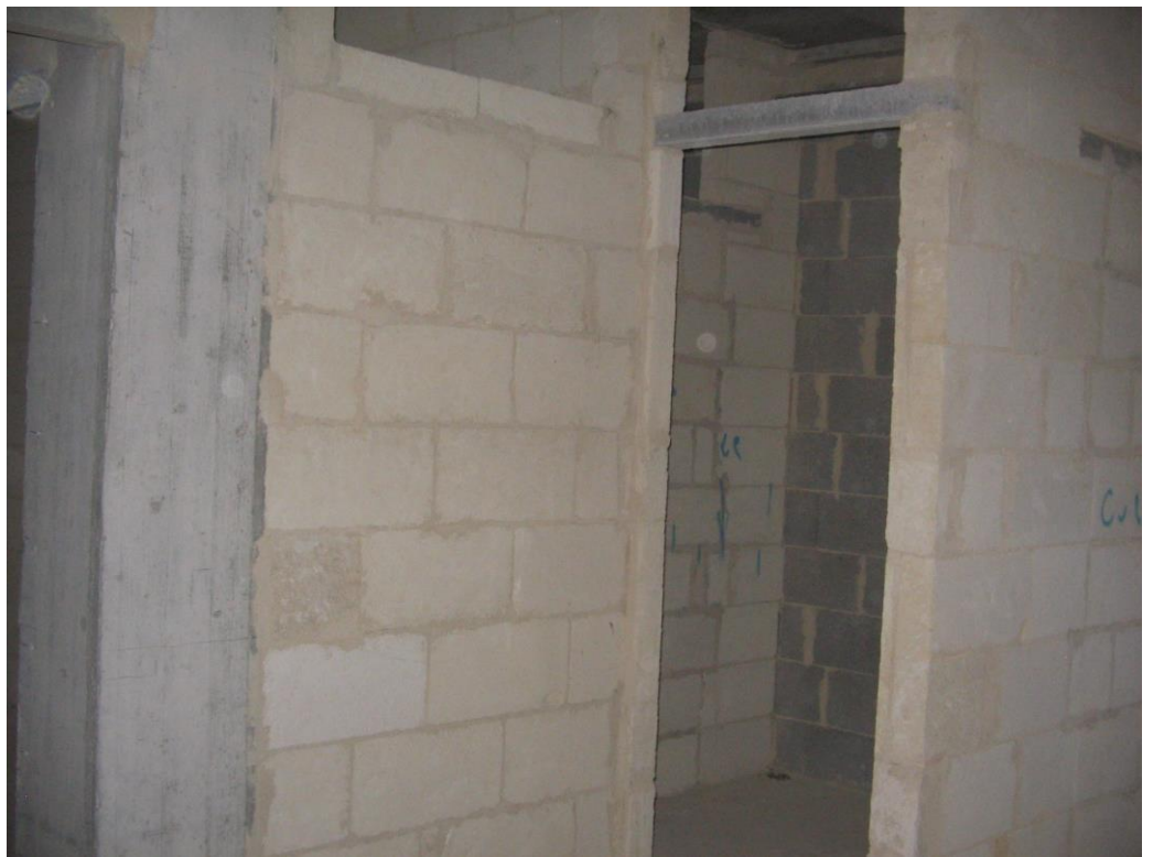
cantina piano interrato 1
