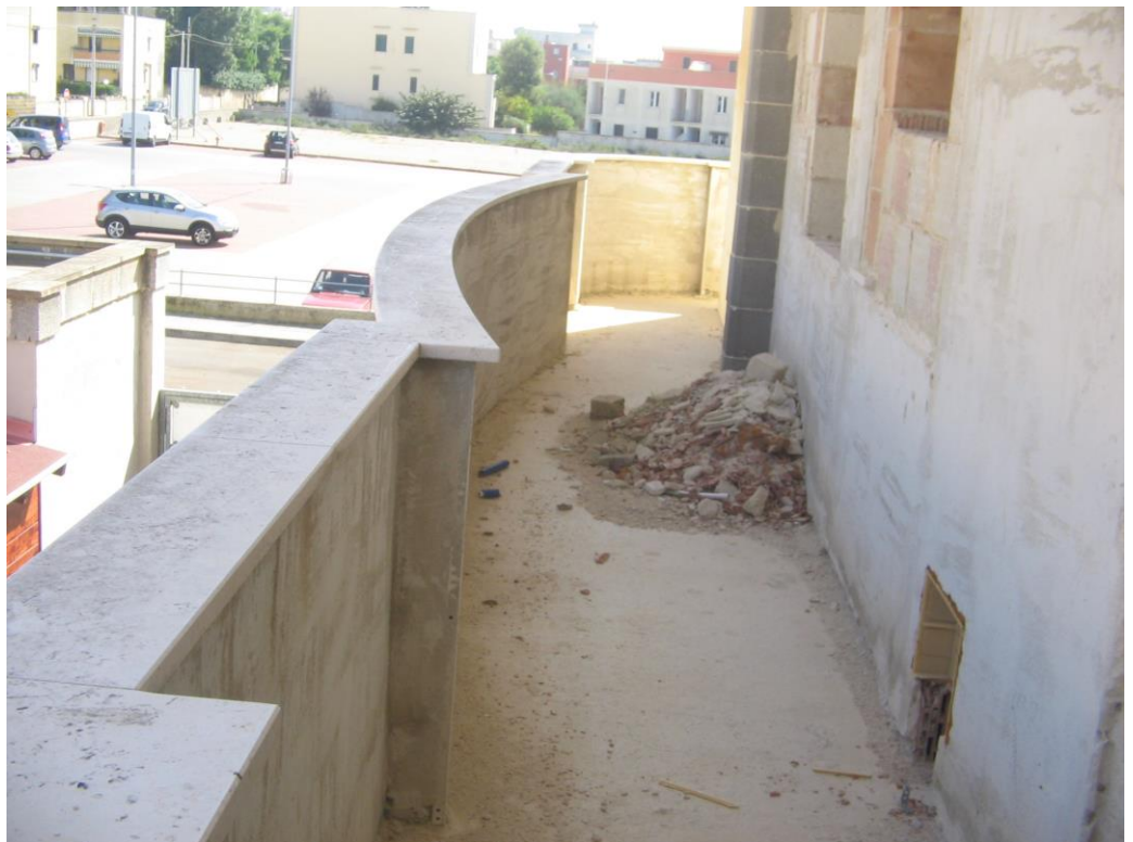
Balcone retrostante - piano primo
