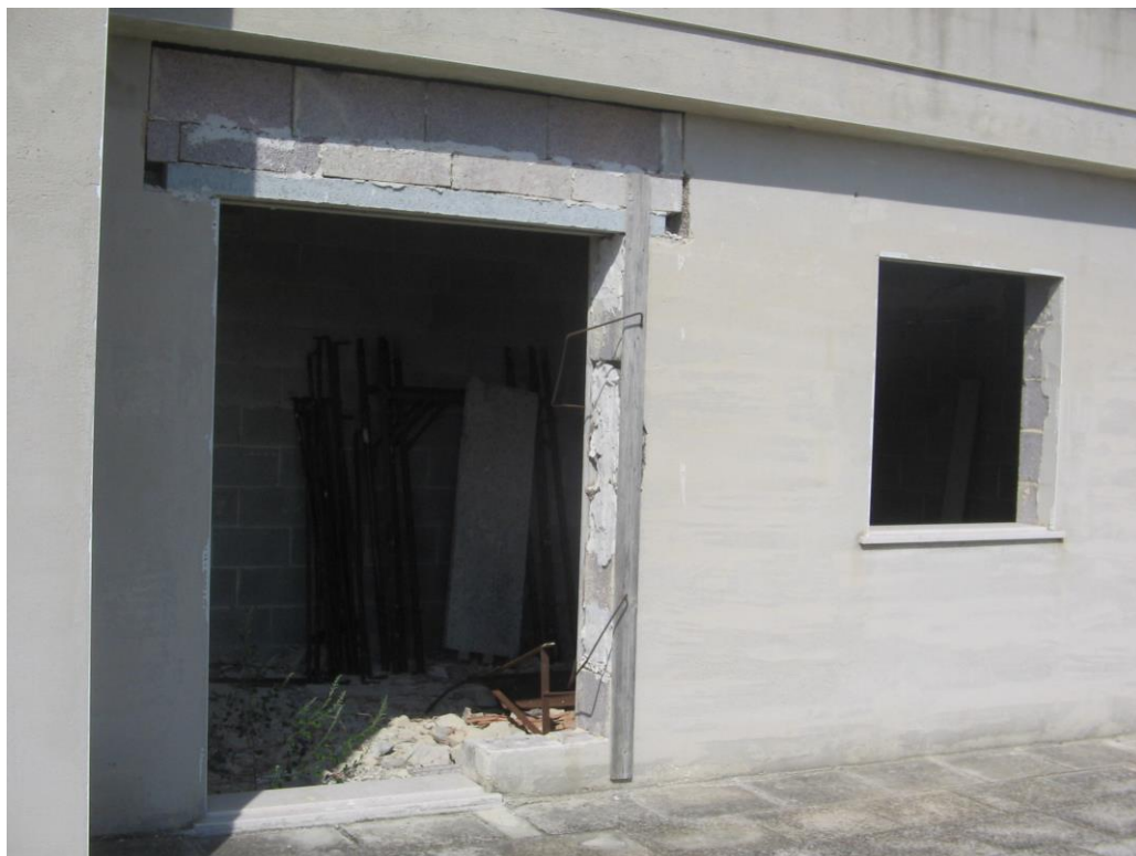
Vano tecnico piano secondo
