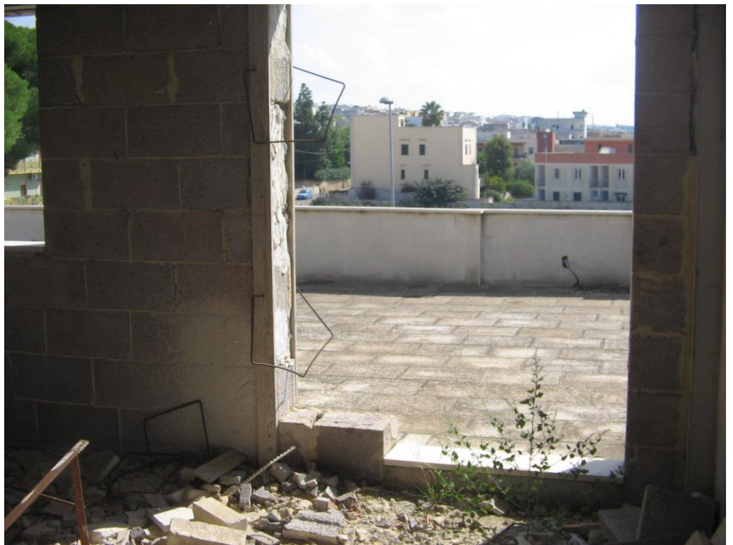
Vano tecnico piano secondo
