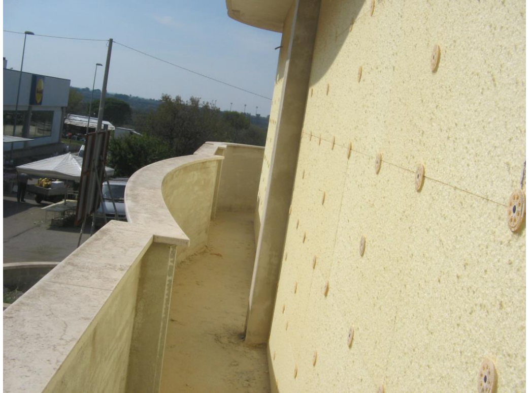
Balcone laterale – piano primo
