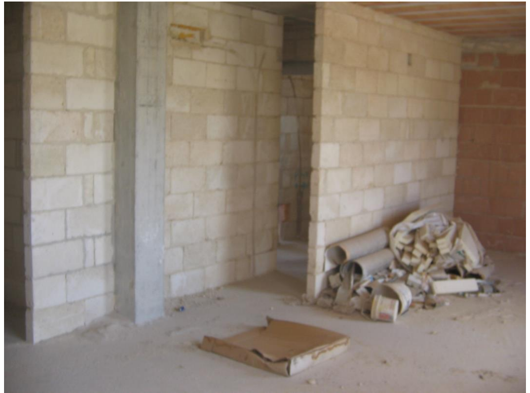
Abitazione con tramezzature incomplete – piano primo
