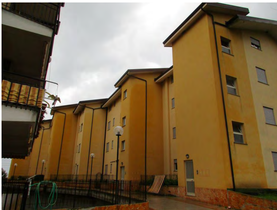
Foto n. 2 – Prospetto est – Fabbricato ospitante i lotti 1 e 2
