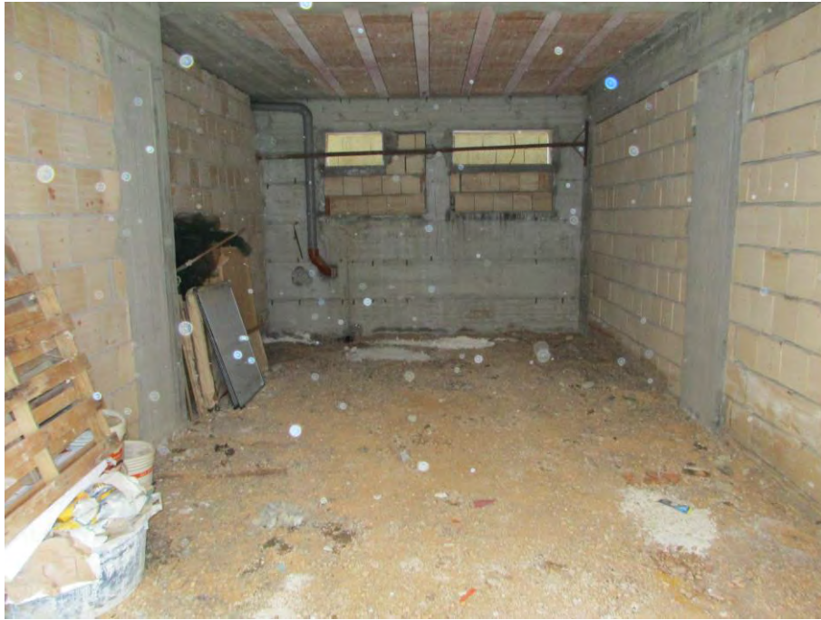
Foto n. 25 – Lotto n. 3 -Magazzino
