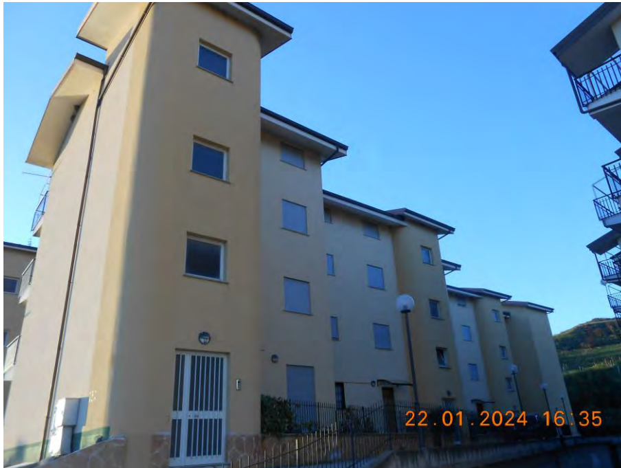
Foto n. 1 – Prospetto est – Fabbricato ospitante i lotti 1 e 2
