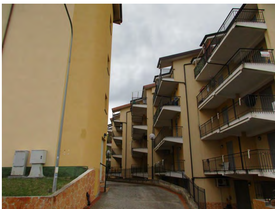
Foto n. 4 – Prospetto ovest – Fabbricato ospitante i lotti 1 e 2
