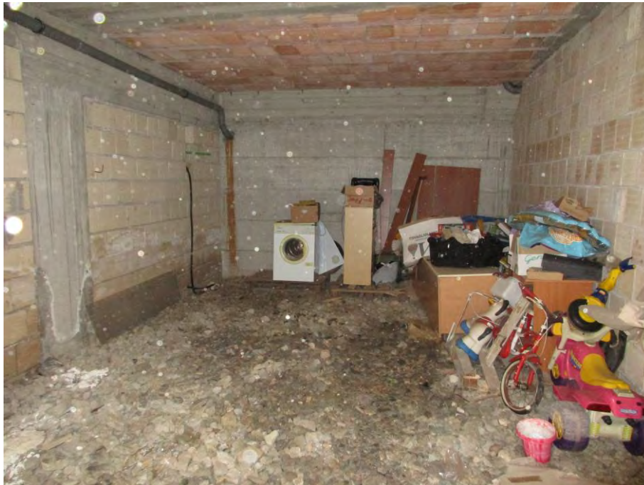
Foto n. 26 – Lotto n.4 - Magazzino
