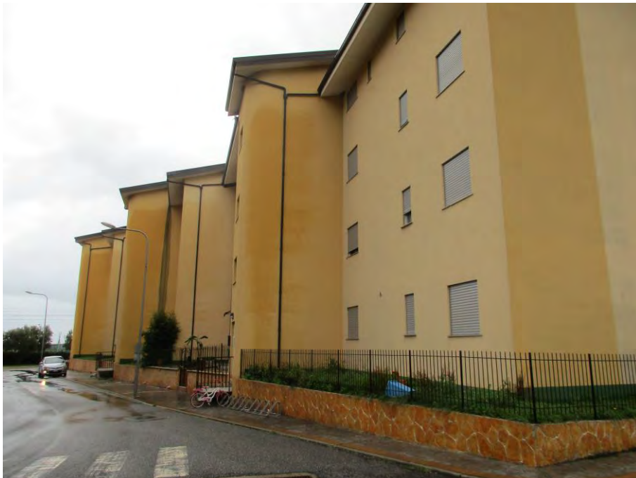
Foto n. 8 – Prospetto est- Fabbricato ospitante i lotti 3 e 4
