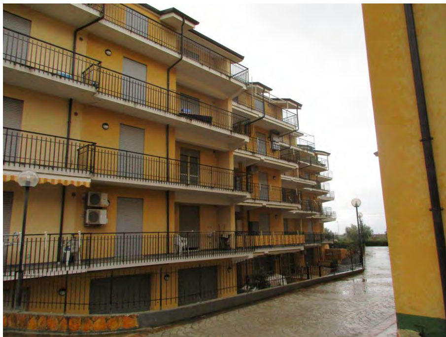
Foto n. 3 – Prospetto ovest – Fabbricato ospitante i lotti 1 e 2
