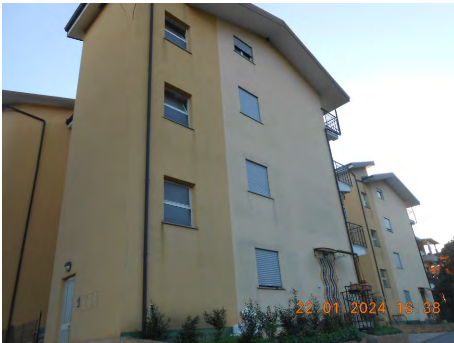
Foto n. 6 – Prospetto nord – Fabbricato ospitante i lotti 1 e 2
