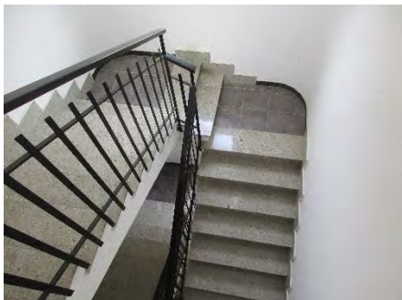
Foto n. 9 – Scala di collegamento
