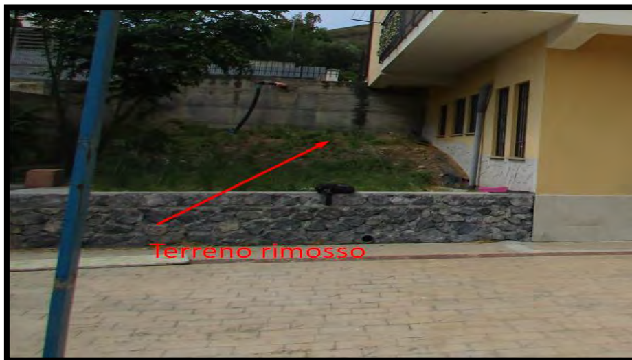
Foto n. 61 Prospetto ovest – Area in cui è stato rimosso il terreno
