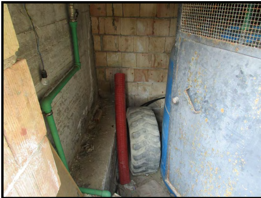
Foto n.62 Locale tecnico realizzato sul prospetto est
