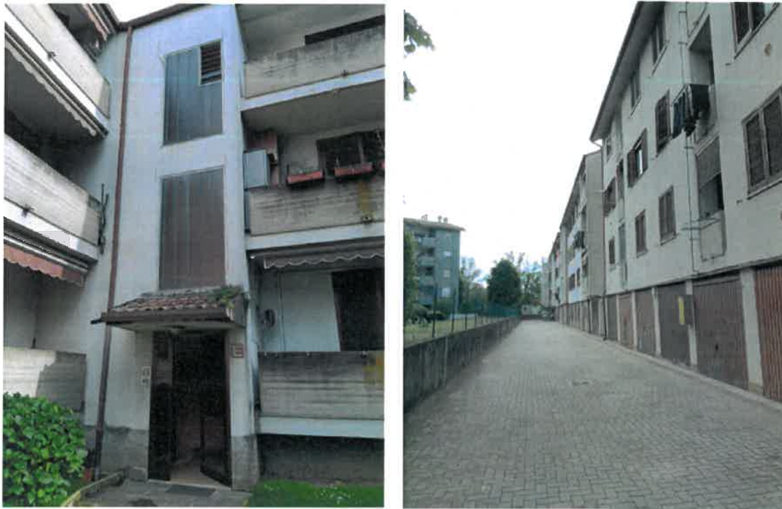
accesso fabbricato scala E - corso manovra box
