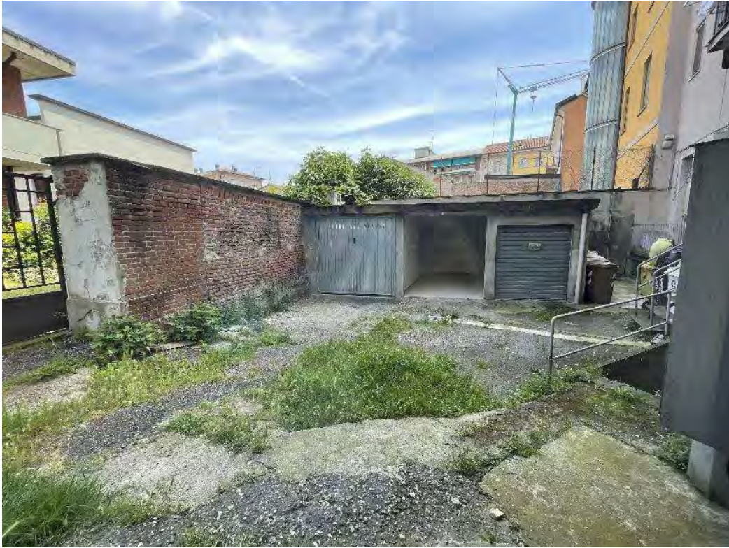
4. Cortile condominiale interno.
