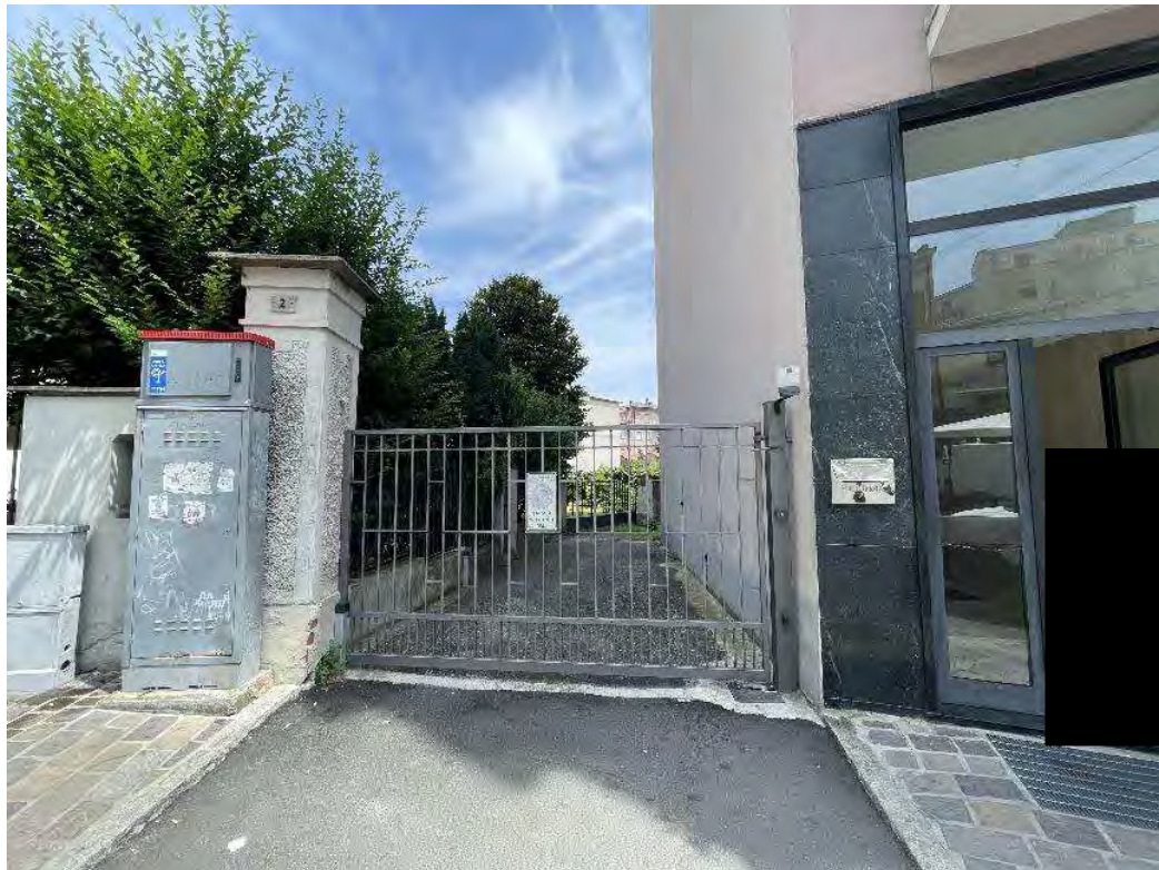
3. Accesso carrabile sul lato sud-ovest.
