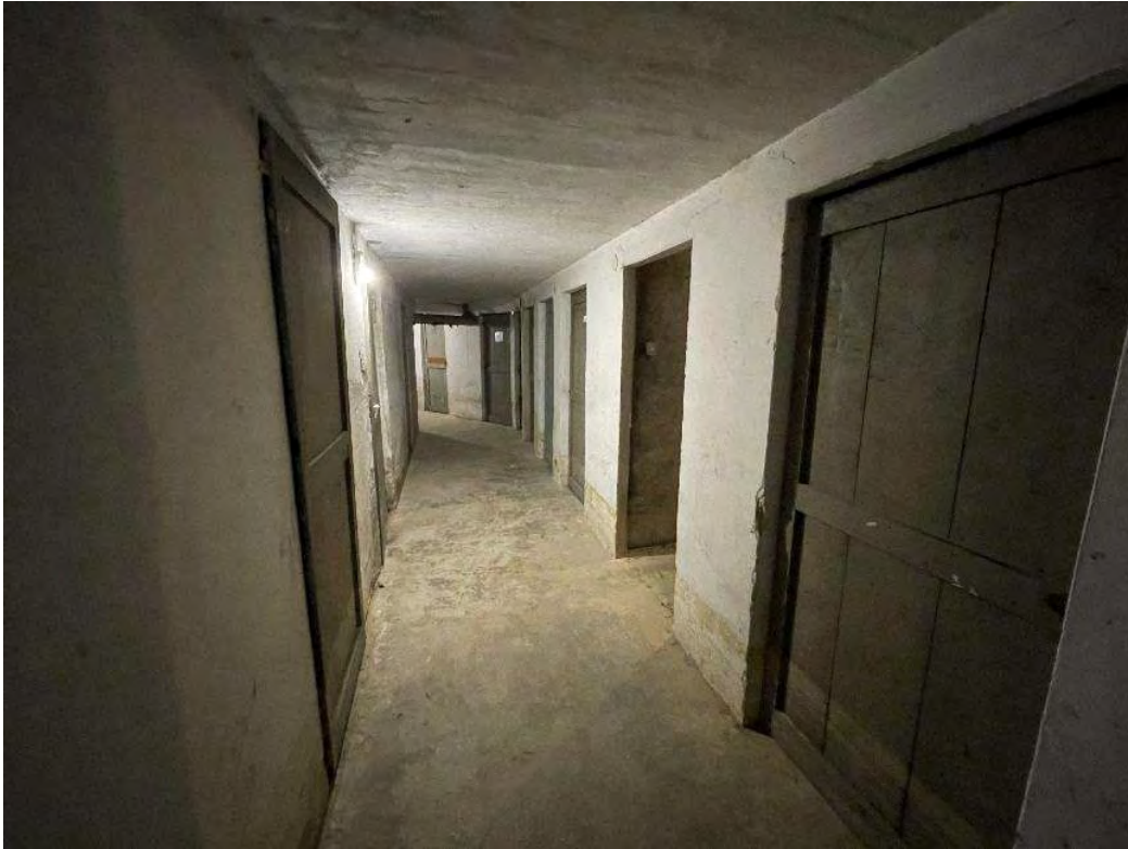
35. Corridoio di accesso alle cantine.
