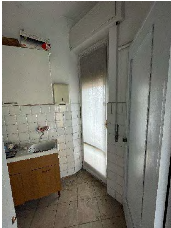
24. Locale di servizio.
