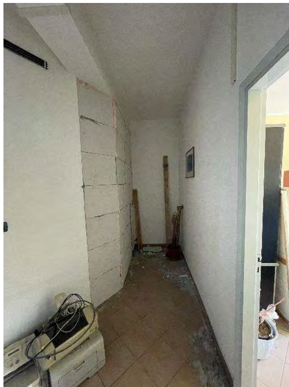
16. Disimpegno con muro di separazione dall'altra unità.
