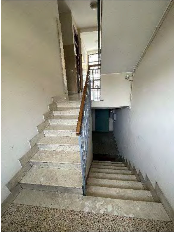
7. Scala condominiale al piano terra.
