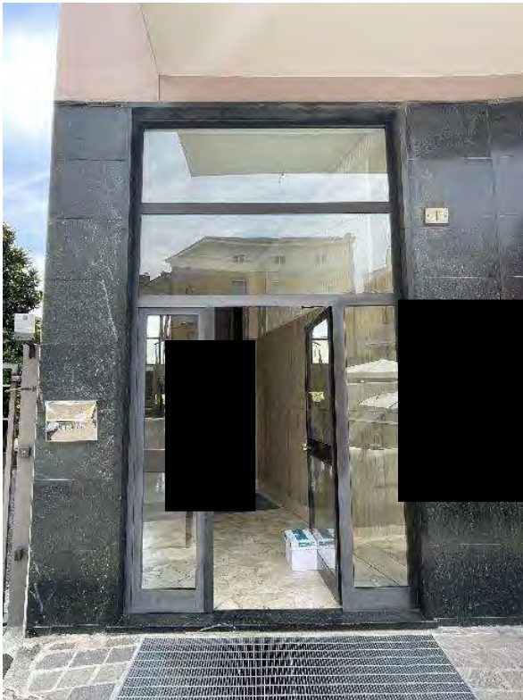
5. Portone di accesso al fabbricato.
