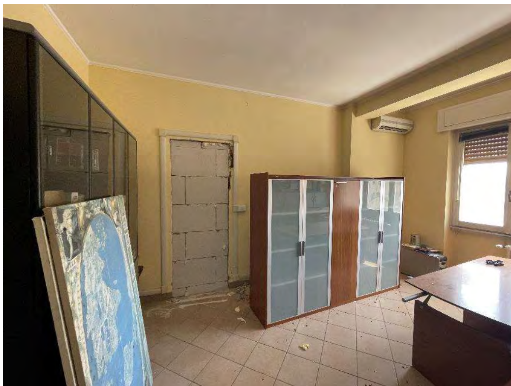
18. Locale ufficio 1 con chiusura vano di accesso ad altra unità.
