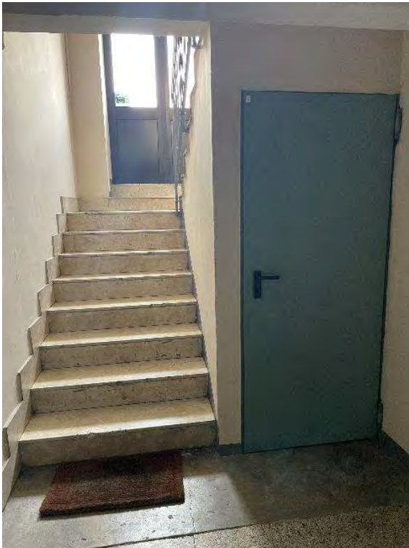
9. Porta di accesso alle cantine.
