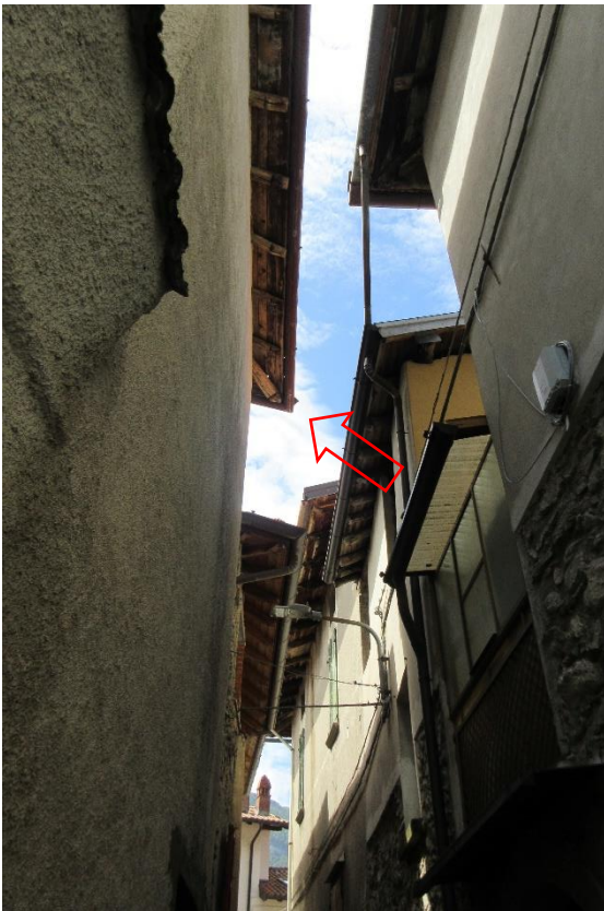
Vista della tegola pericolante sul tetto con affaccio sulla sottostante via pubblica Terragno
