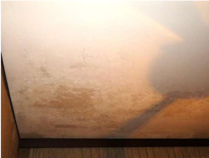
23. – Abitazione mappale 195 sub. 5: infiltrazioni presenti nei soffitti dei locali
