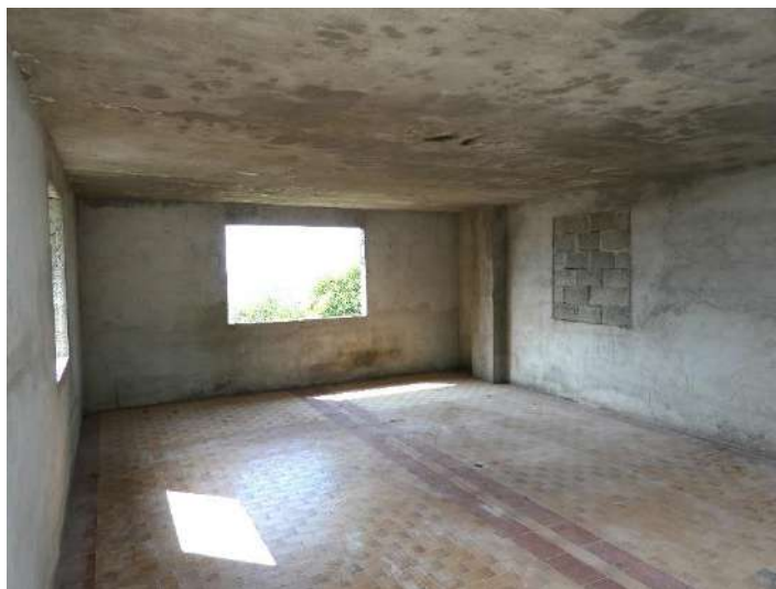
41. - Autorimessa Fg. 4 mappale 195 sub. 2 – Interno
