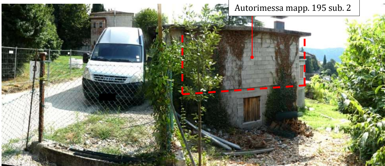
38. - Fabbricato Fg. 4 mappale 195 sub. 2 – lato Ovest fronte Via Paninsacco
