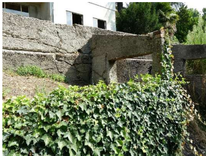
50. – Corte comune mappale 195 sub. 7: particolari murature di sostegno dei terrazzamenti
