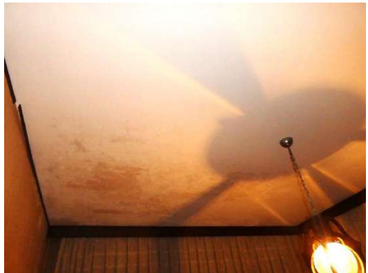
20. – Abitazione mappale 195 sub. 5: infiltrazioni presenti nei soffitti dei locali
