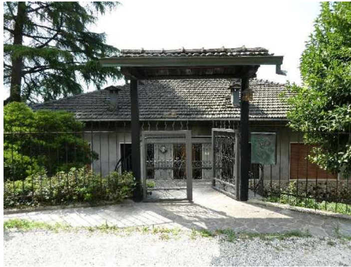
4. – Cancellone pedonale di accesso al Fabbricato Fg. 4 mappale 195 – lato Nord fronte Via Paninsacco
