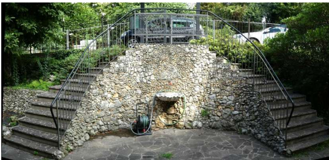
9. – scale di accesso dalla strada Via Paninsacco all'abitazione mappale 195 sub. 5
