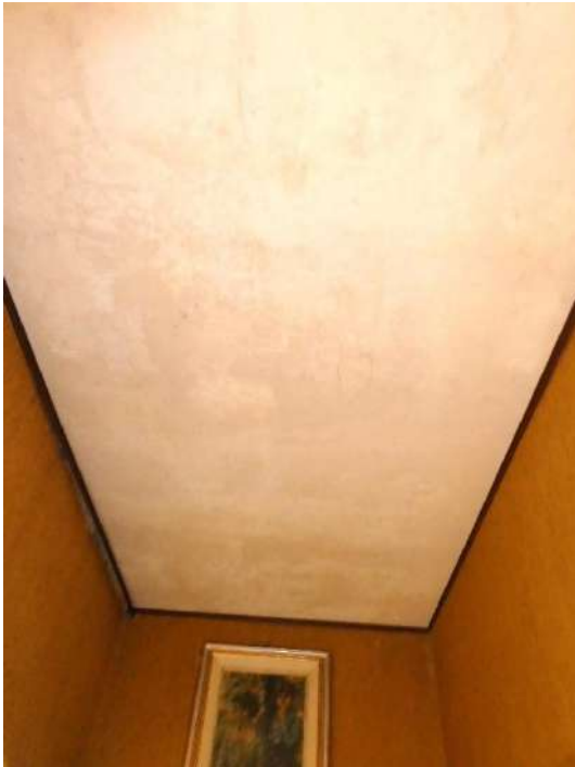
22. – Abitazione mappale 195 sub. 5: infiltrazioni presenti nei soffitti dei locali
