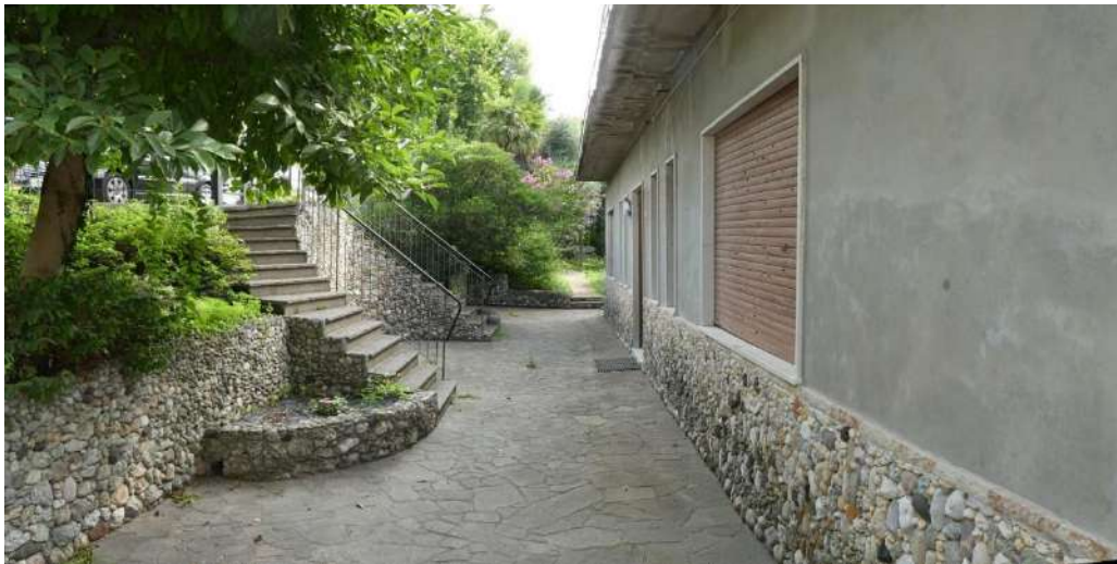
8. – scale di accesso dalla strada Via Paninsacco all'abitazione mappale 195 sub. 5
