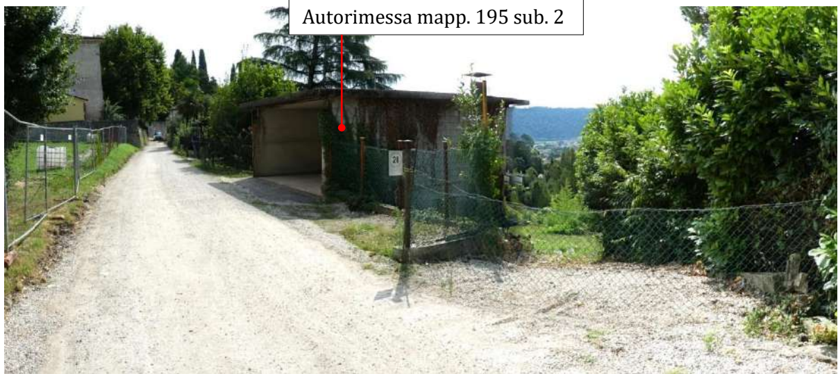
36. - Fabbricato Fg. 4 mappale 195 sub. 2 – lato Nord/Ovest fronte Via Paninsacco
