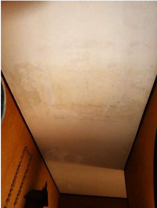
20. – Abitazione mappale 195 sub. 5: infiltrazioni presenti nei soffitti dei locali
