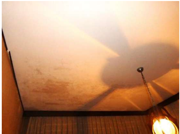
22. – Abitazione mappale 195 sub. 5: infiltrazioni presenti nei soffitti dei locali
