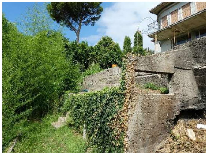
49. – Corte comune mappale 195 sub. 7: particolari murature di sostegno dei terrazzamenti
