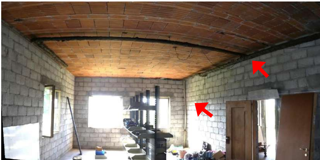
31. – Unità mappale 195 sub. 8-9 nel piano Interrato (non oggetto di pignoramento): presenza delle tubazioni degli impianti dell’Abitazione mappale 195 sub. 5
