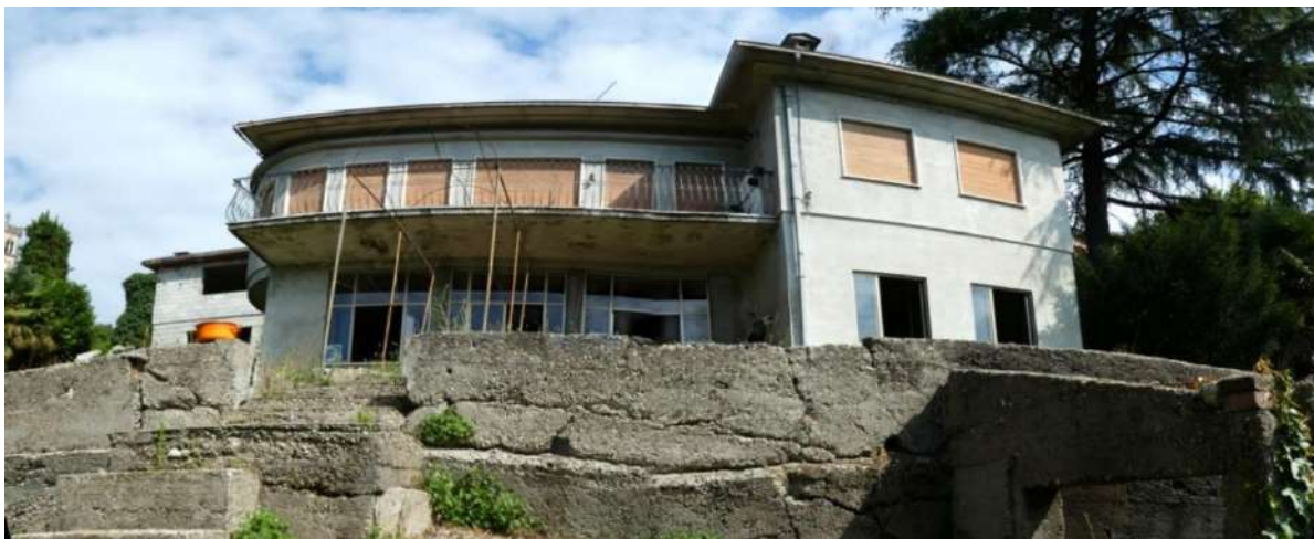
48. – Corte comune mappale 195 sub. 7: particolari murature di sostegno dei terrazzamenti
