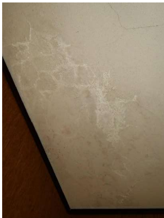
21. – Abitazione mappale 195 sub. 5: infiltrazioni presenti nei soffitti dei locali
