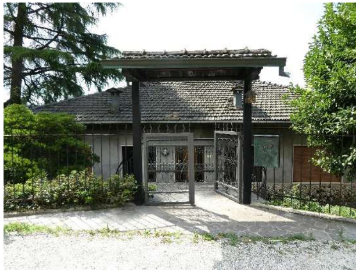
4. – Cancello pedonale di accesso al Fabbricato Fg. 4 mappale 195– lato Nord fronte Via Paninsacco
