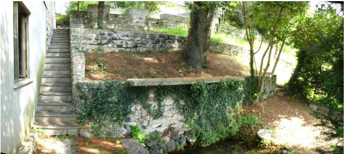
43. – Corte comune mappale 195 sub. 7: porzione lato Est con scale esterne di collegamento tra piano Terra ed Interrato
