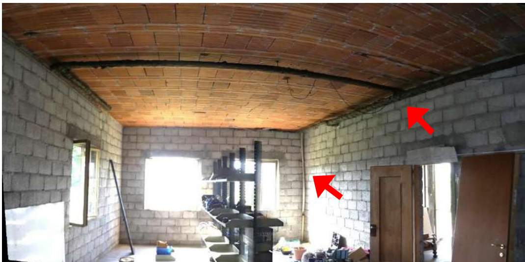
31. – Unità mappale 195 sub. 8-9 nel piano Interrato (non oggetto di pignoramento): presenza delle tubazioni degli impianti dell’Abitazione mappale 195 sub. 5
