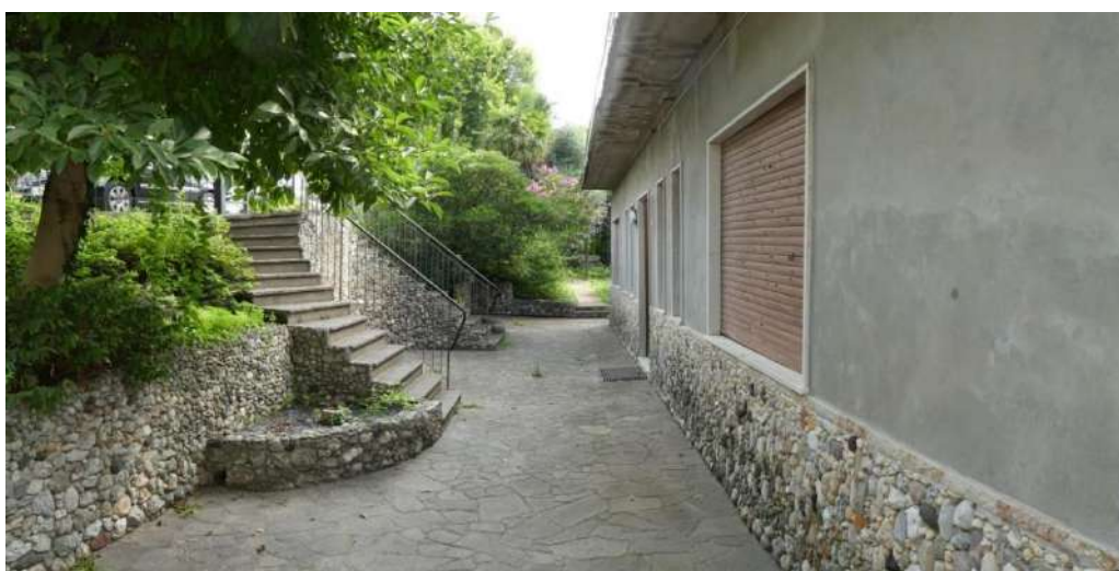
8. – scale di accesso dalla strada Via Paninsacco all'abitazione mappale 195 sub. 5
