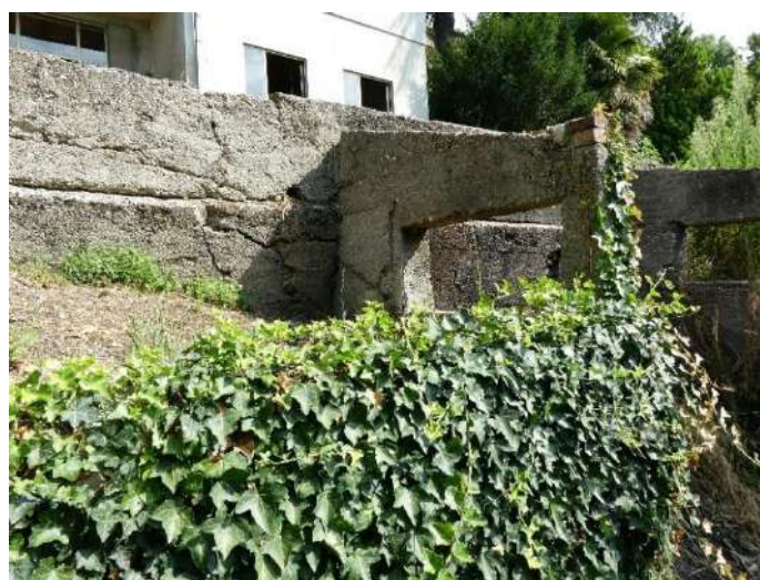
50. – Corte comune mappale 195 sub. 7: particolari murature di sostegno dei terrazzamenti
