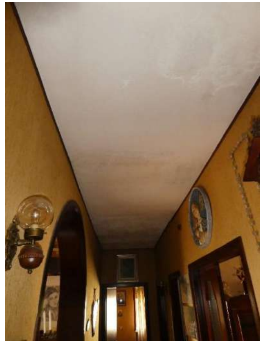
23. – Abitazione mappale 195 sub. 5: infiltrazioni presenti nei soffitti dei locali
