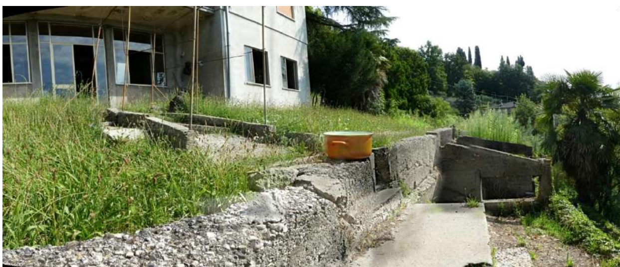
47. – Corte comune mappale 195 sub. 7: particolari murature di sostegno dei terrazzamenti
