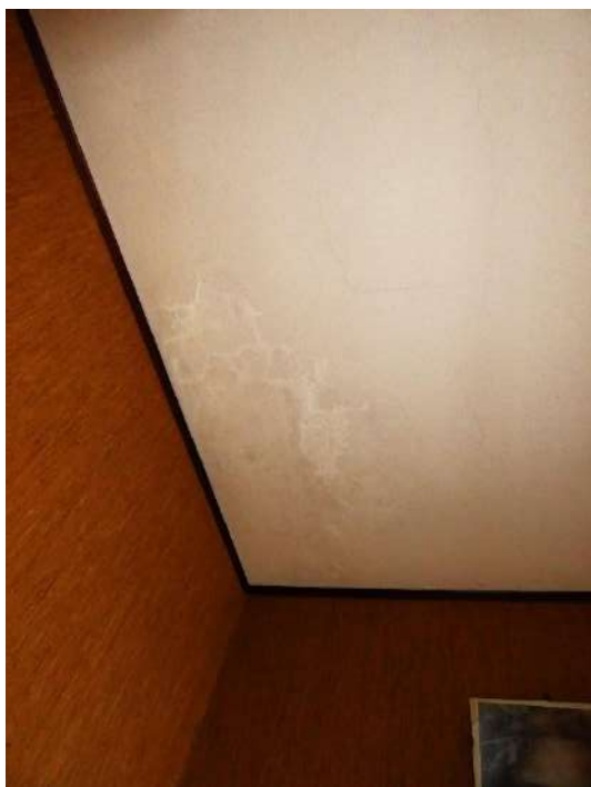
21. – Abitazione mappale 195 sub. 5: infiltrazioni presenti nei soffitti dei locali
