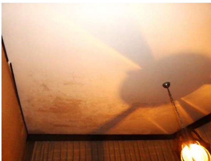
22. – Abitazione mappale 195 sub. 5: infiltrazioni presenti nei soffitti dei locali
