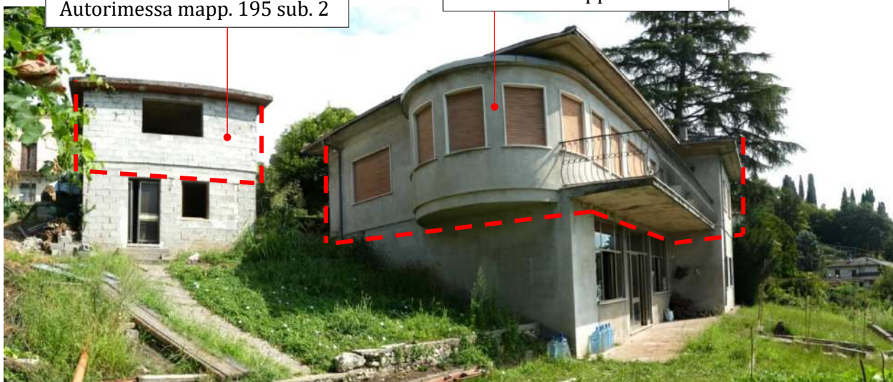
7. – Fabbricati sul mappale 195– lato Sud/Ovest fronte corte comune sub. 7
