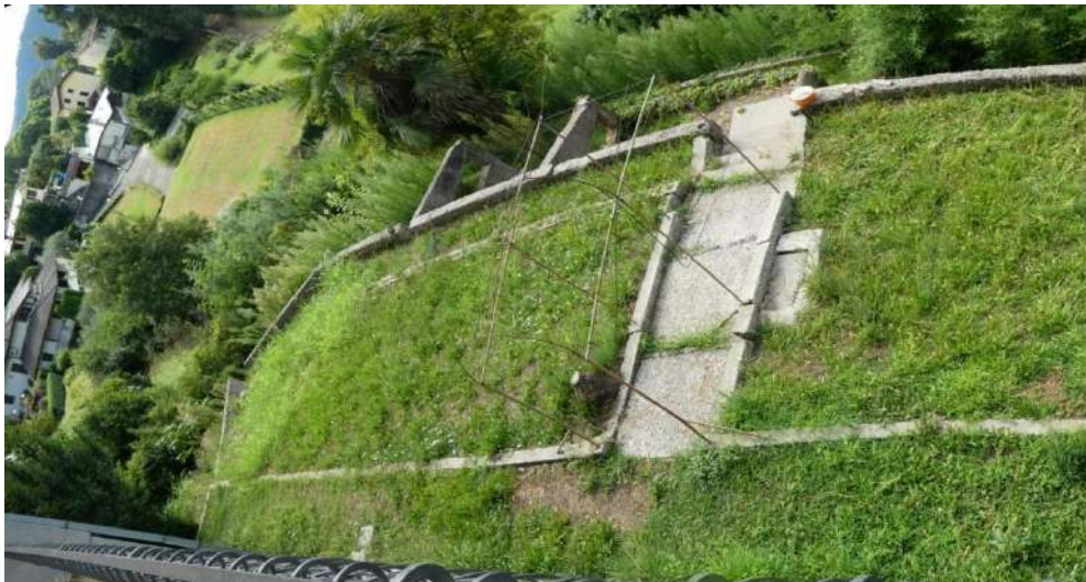
45. – Corte comune mappale 195 sub. 7: porzione lato Sud con terrazzamenti
