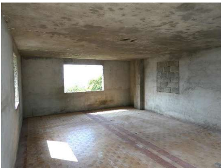
41. - Autorimessa Fig. 4 mappale 195 sub. 2 – Interno
