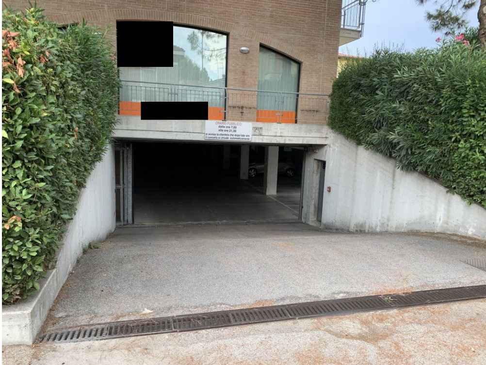
Foto n. 15 - RAMPA DI ACCESSO ALL'AUTORIMESSA DA VIA RISORGIMENTO
