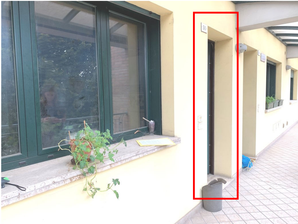
Foto n. 5 - INGRESSO CASA ( portone d'ingresso)
