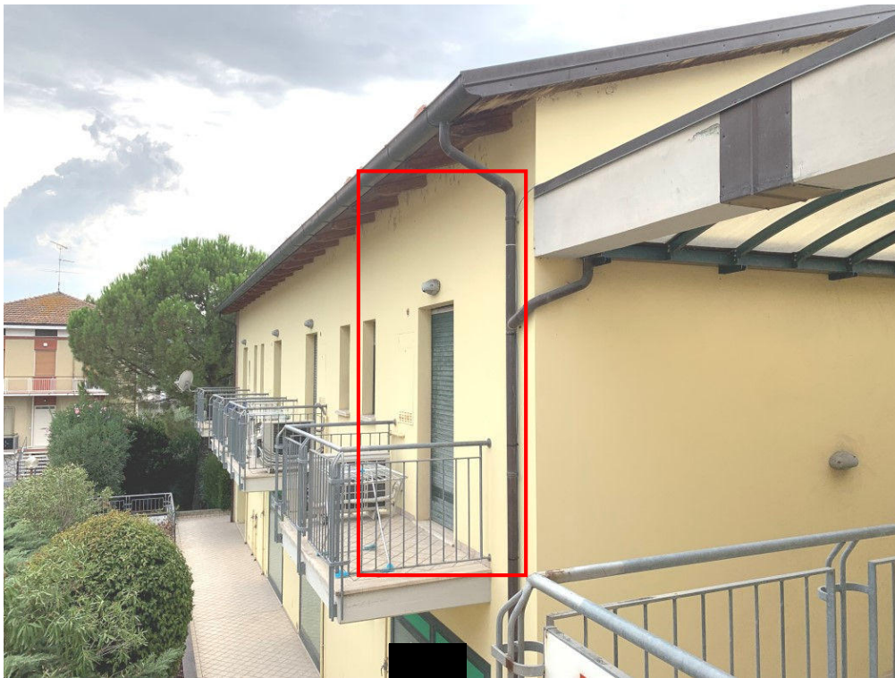
Foto n. 2 - FOTO ESTERNO CASA ( vista dalla corte interna)
